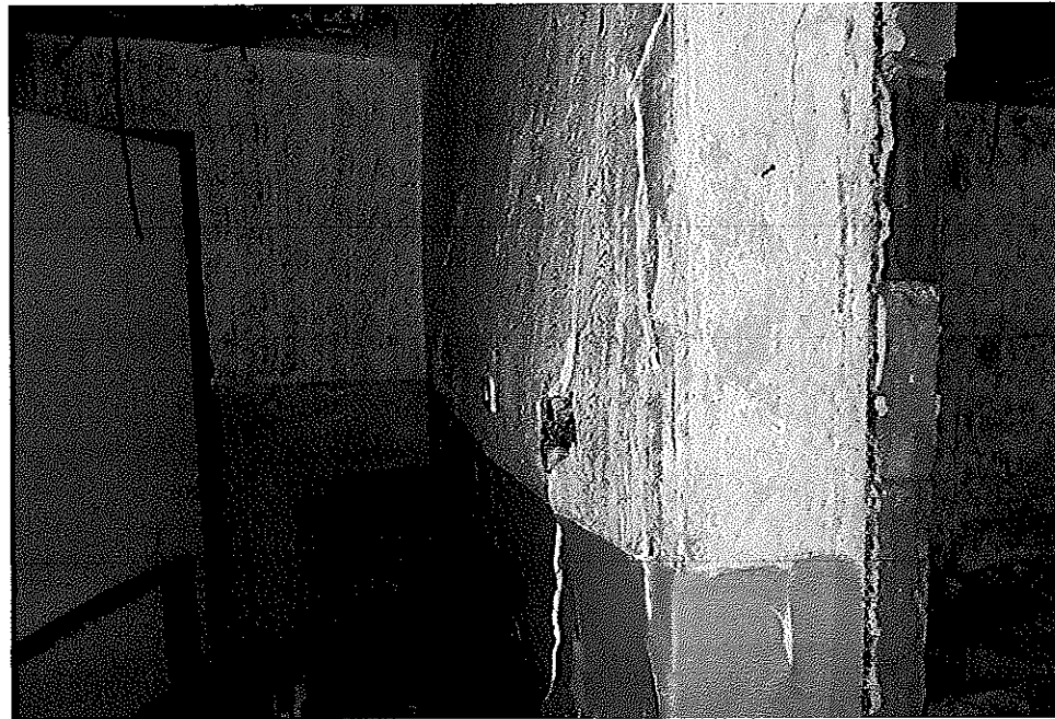
Fot. 1 spękana i wyboczona wewnętrzna ściana nośna
