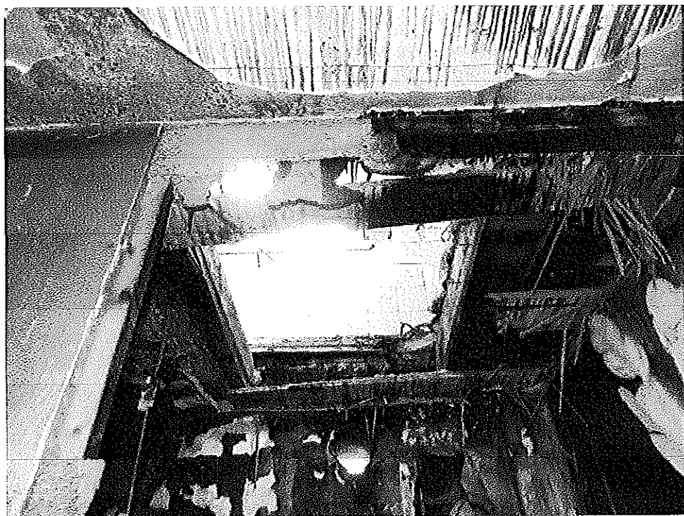
Fot. 3 spalony strop drugiego piętra
