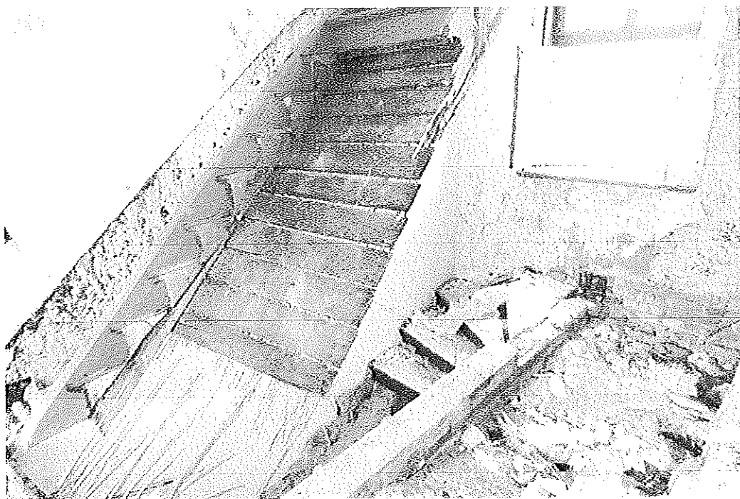
Fot. 2 Zniszczone drewniane schody zawalony strop klatki schodowej
