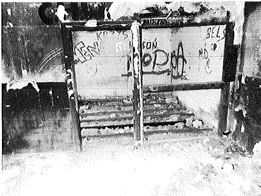
fot. nr 2 zawalona ściana i stropodach w tylnej części budynku
