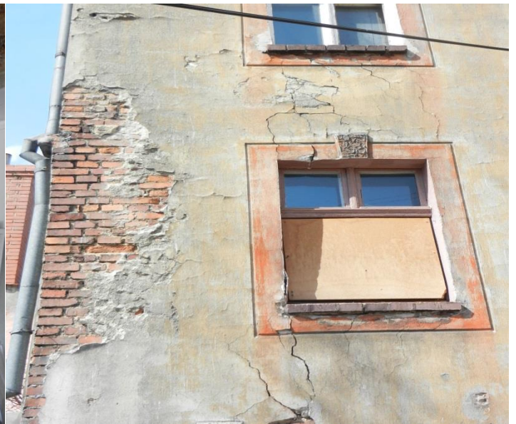
Fot. 5 spękane ściany zewnętrzne
