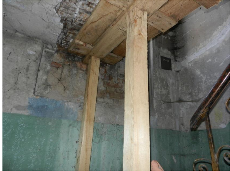
fot.2 zniszczony spocznik klatki schodowej
