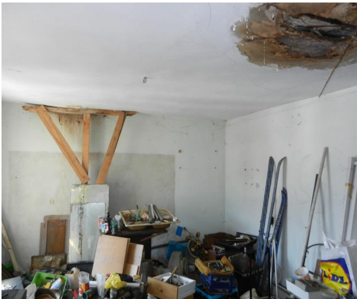
Fot. 4 przecieki z połaci dachowej
