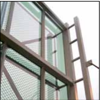
Zastosowanie siatki cięto-ciągnionej jako balustrady (po lewej) oraz osłony przeciwsłonecznej (po prawej). Front: Elewacja w Bilbao Exhibition Centre
