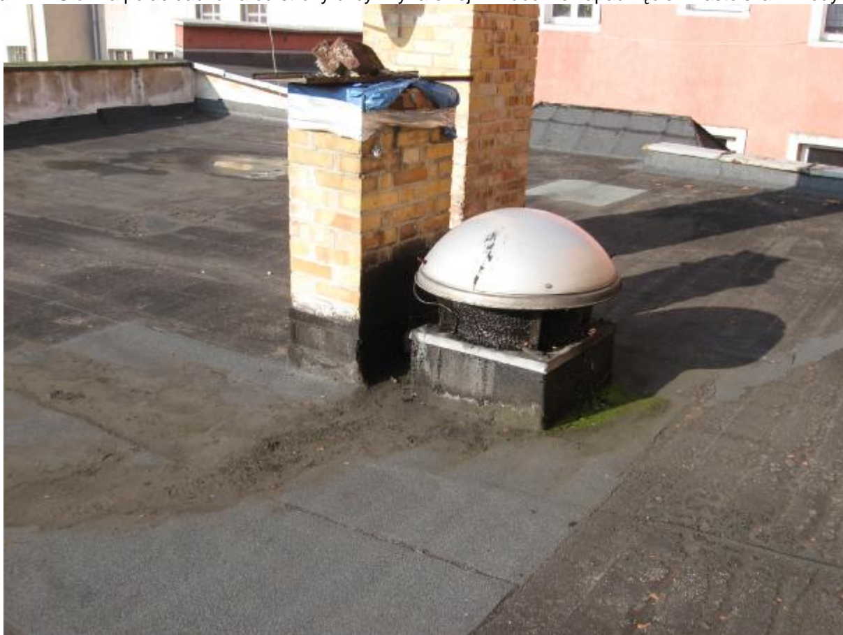
Fotografia nr 8. Wentylator z osadami tłuszczu na połaci dachowej.
