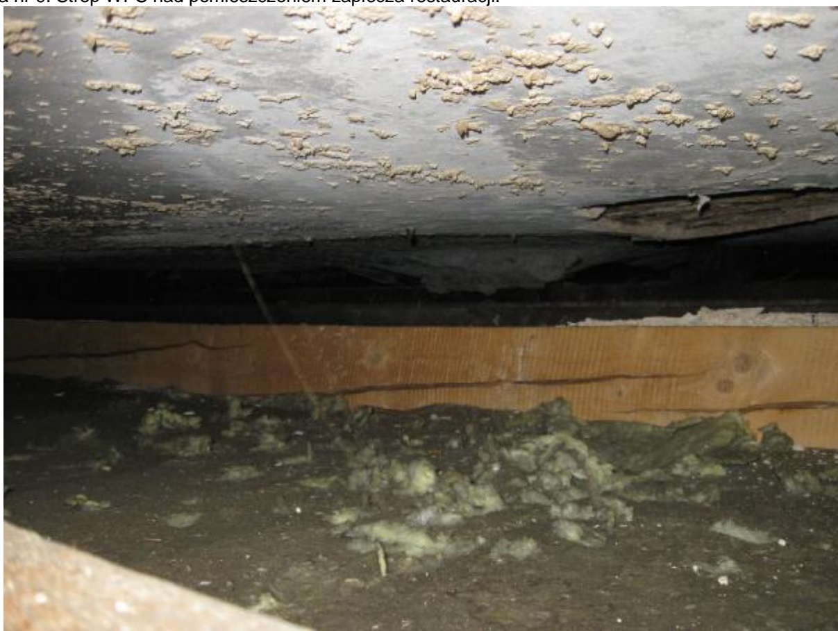
Fotografia nr 10. Pośredni strop drewniany nad pomieszczeniem sali restauracyjnej. Widoczne odkształcenie połaci dachu.
