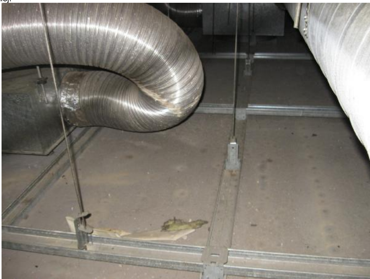
Fotografia nr 12. Przestrzeń nad sufitem sali restauracyjnej wykonanym z płyt g-k. – widoczna instalacja wentylacyjna restauracji.
