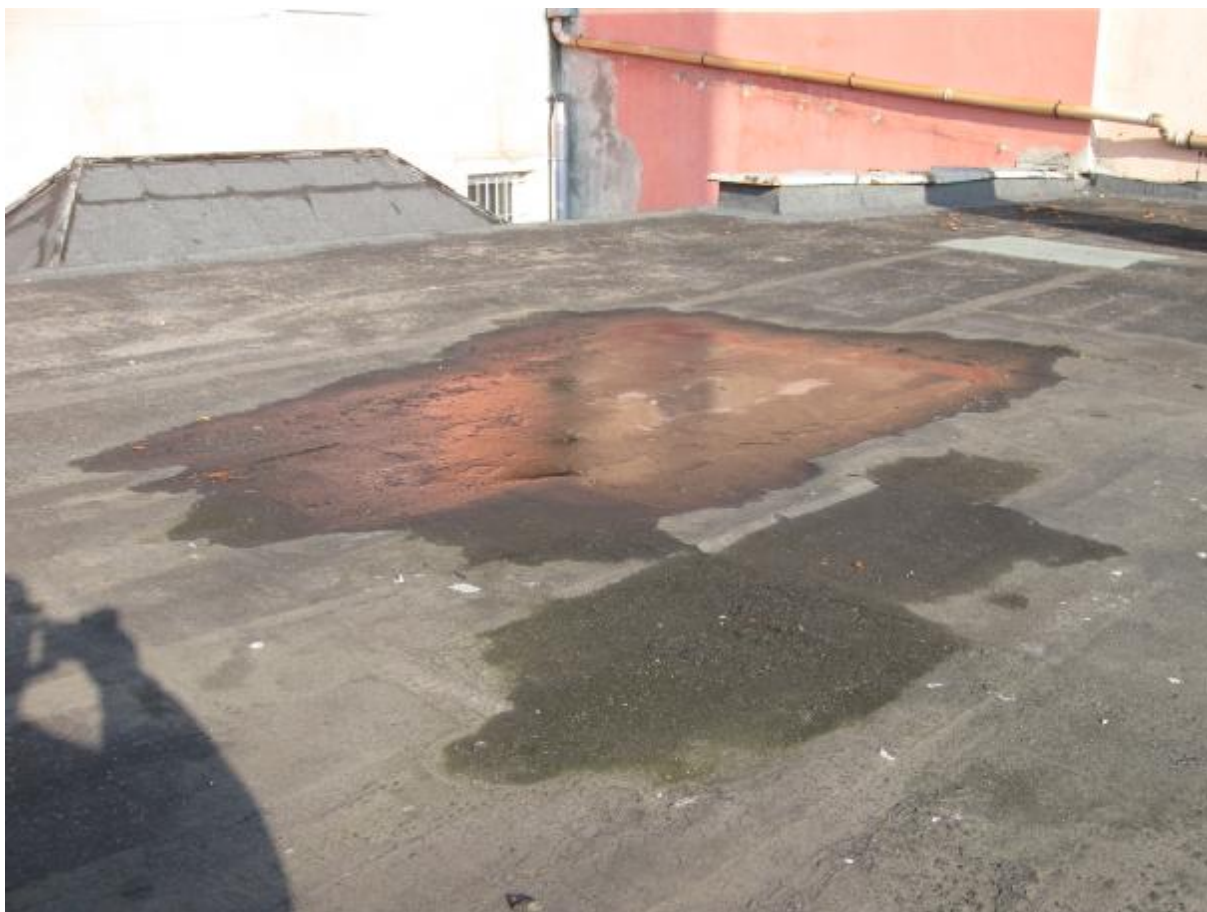
Fotografia nr 7. Główna połać dachowa od strony ulicy Młynarskiej – widoczne zapadnięcie z zastoiskami wody.
