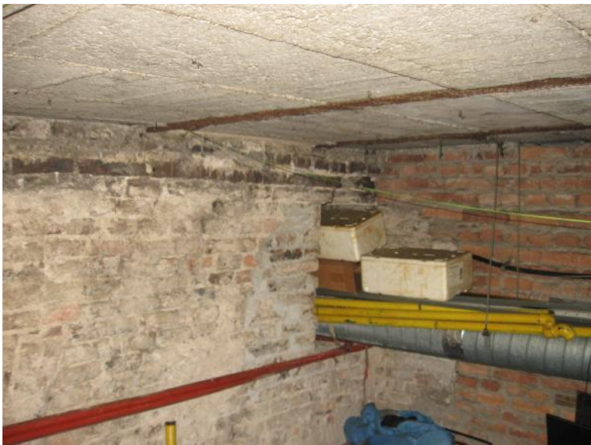
Fotografia nr 9. Strop WPS nad pomieszczeniem zaplecza restauracji.
