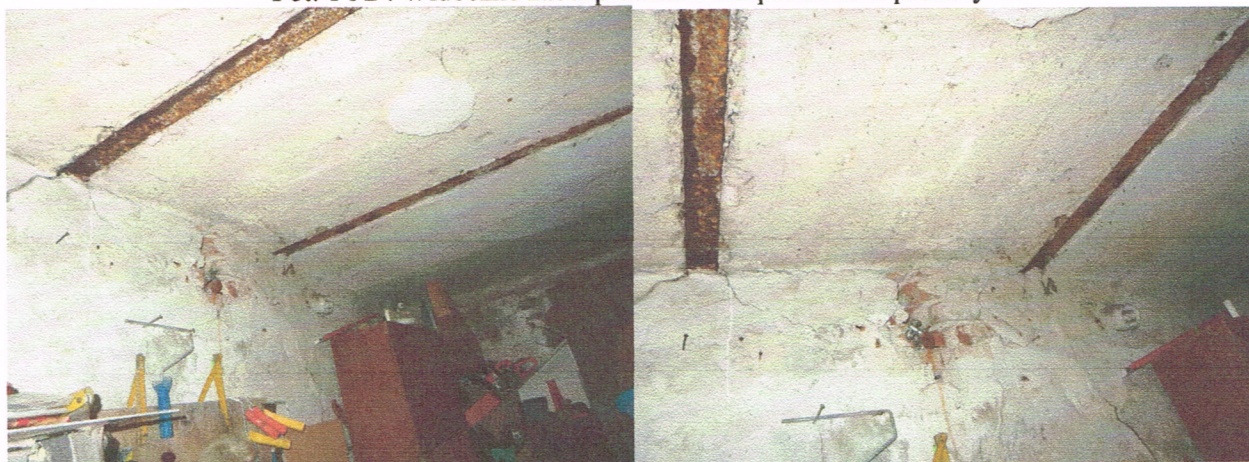
Fot. 3 i 4 Widoczne zardzewiałe belki stropowe nad przyziemiem.
