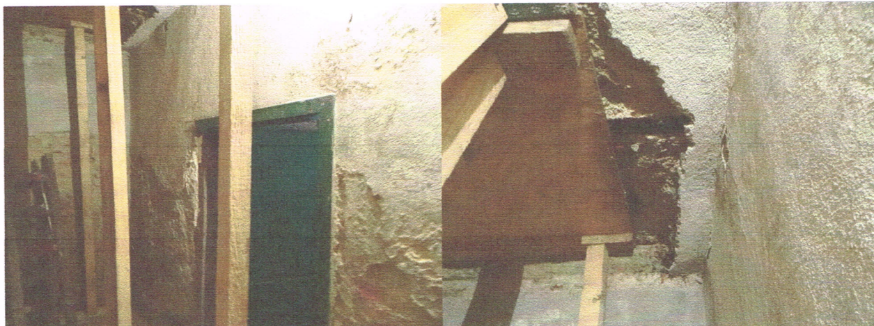
Fot. 1 i 2 . Widoczne zabezpieczenie stropodachu w piwnicy
