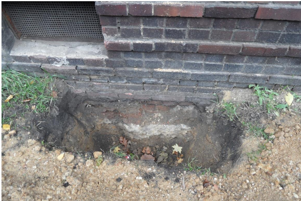
fragment odkrywki ściany frontowej z widocznym łupkiem skalnym
