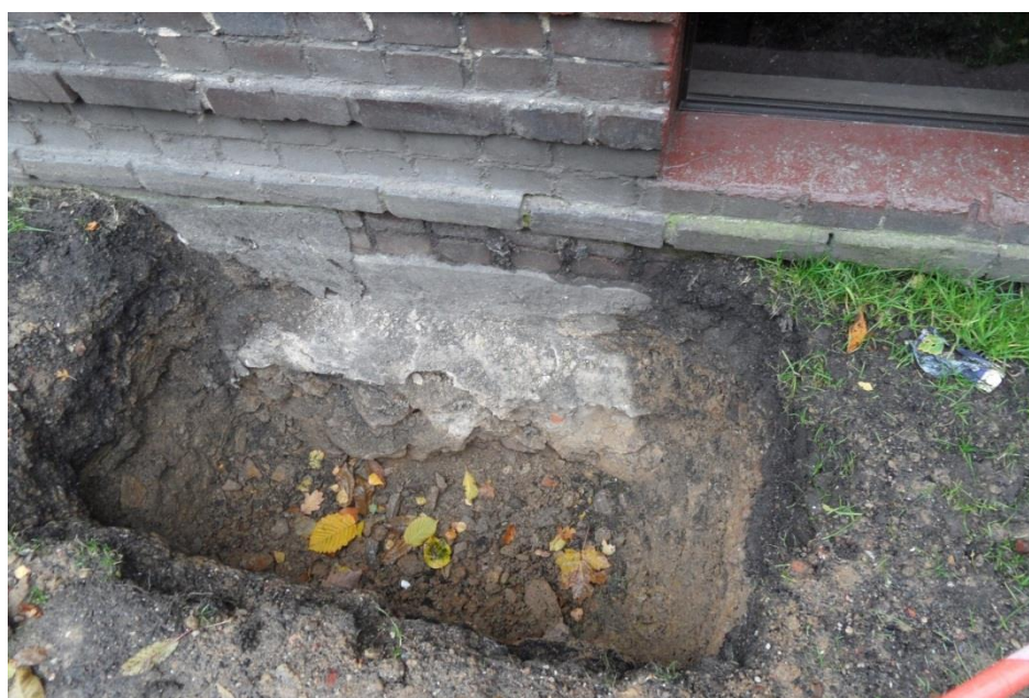
odkrywka przy ścianie tylnej, widoczny beton wylany na ciosach kamiennych
