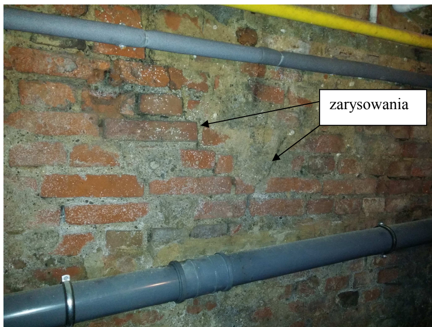
Fot. nr 7 Zarysowanie na ścianie wewnętrznej w piwnicy
