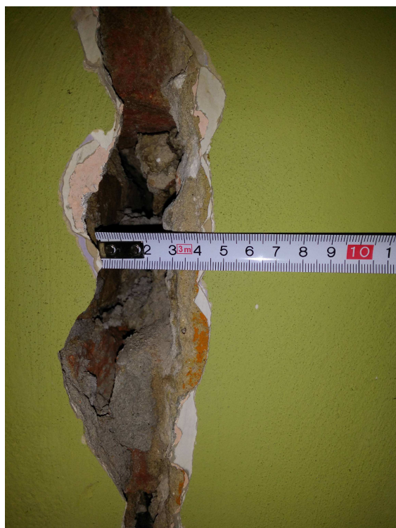
Fot. nr 5 Pęknięcie z fot. nr 4 po rozkuciu
