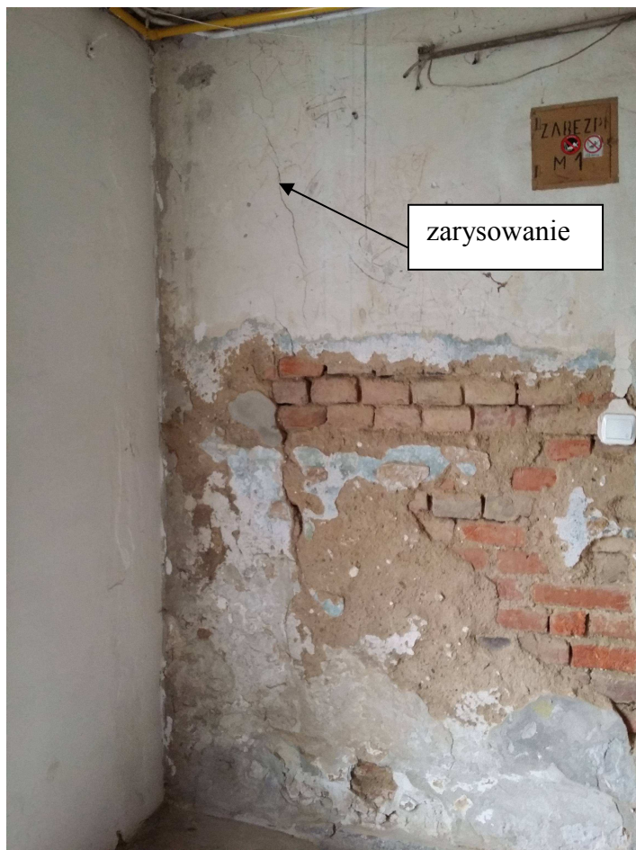
Fot. nr 6 uszkodzenia ściany w korytarzu
