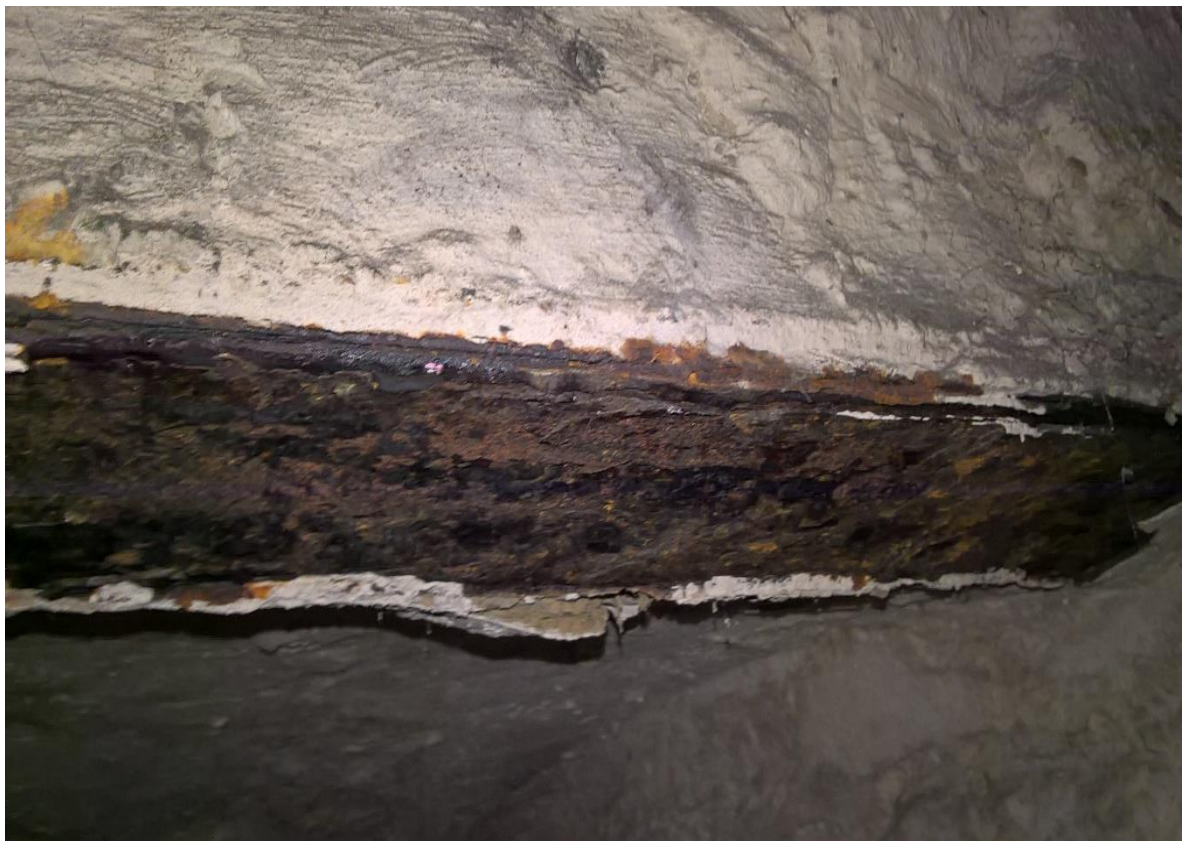
korozja powodująca rozwarstwienie dolnych pólek belek stropowych
