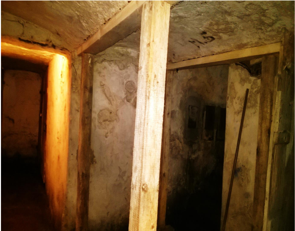
zabezpieczenie uszkodzonych belek stropowych stalowych
