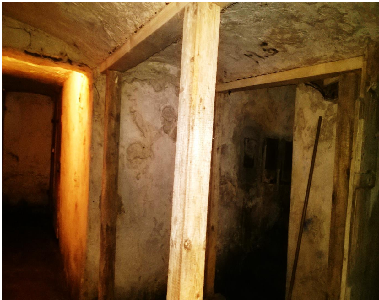
zabezpieczenie uszkodzonych belek stropowych stalowych
