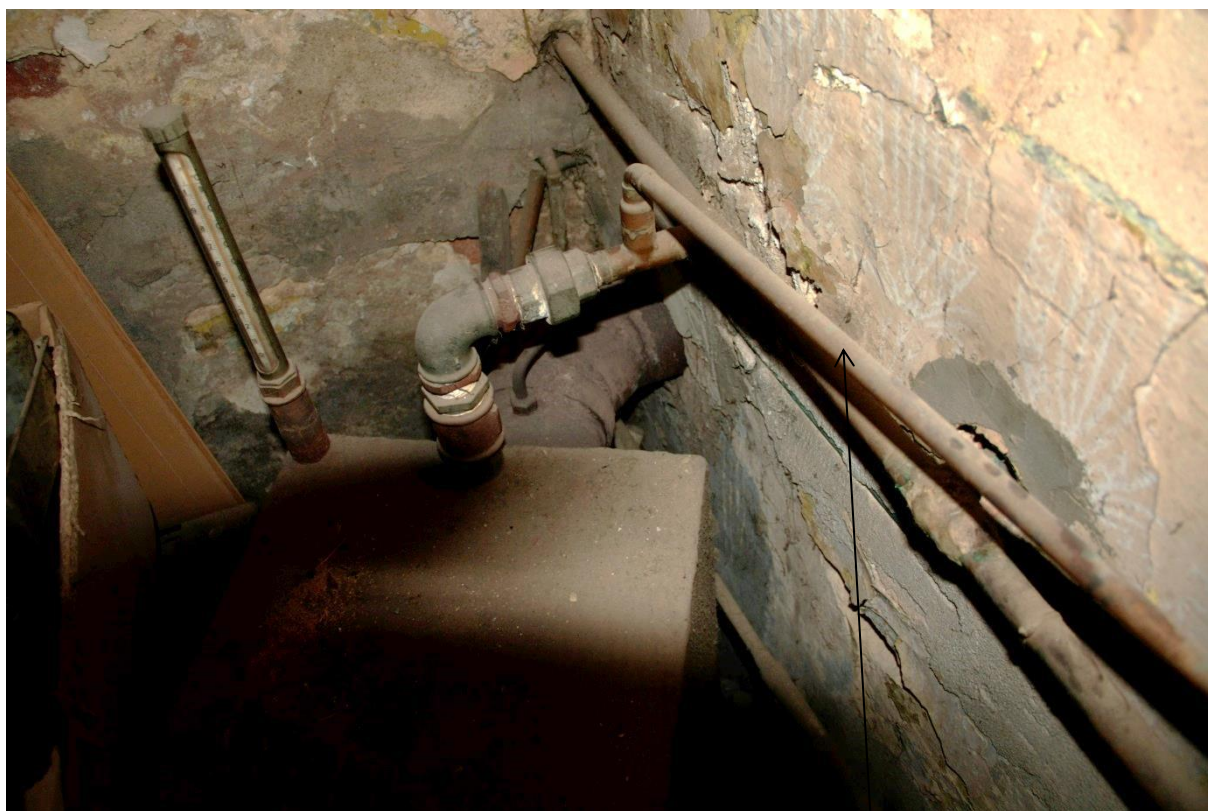
nieprawidłowa średnica rury zabezpieczającej kocioł
