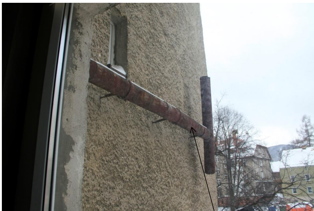
zardzewiała rura stalowa czerpni powietrza
