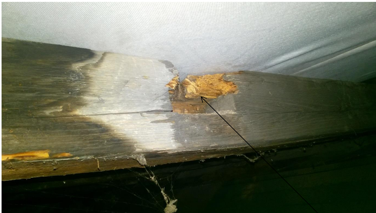
gniazda w krokwiach po zdemontowanej konstrukcji okienek mansardowych
