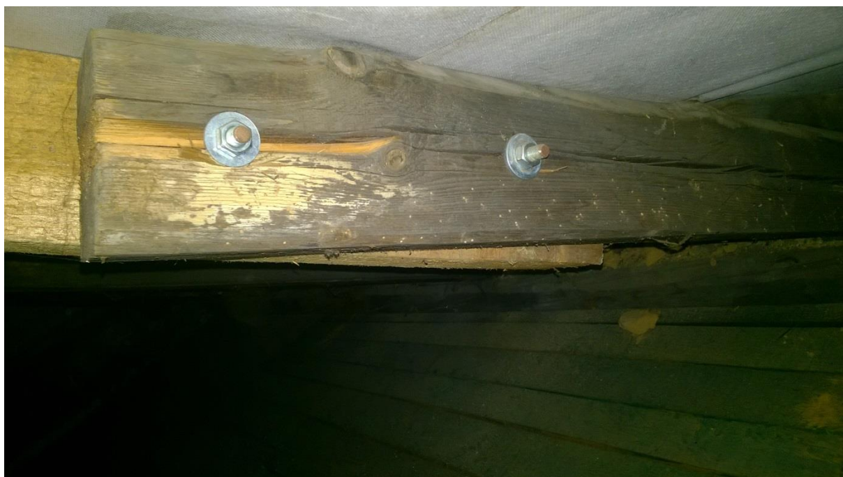
złącze końcówki krokwi z wymienianym fragmentem
