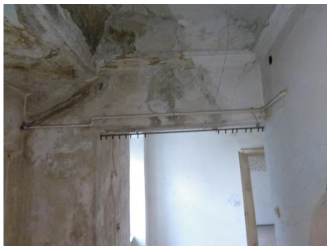
zacieki na ścianach przedpokoju
