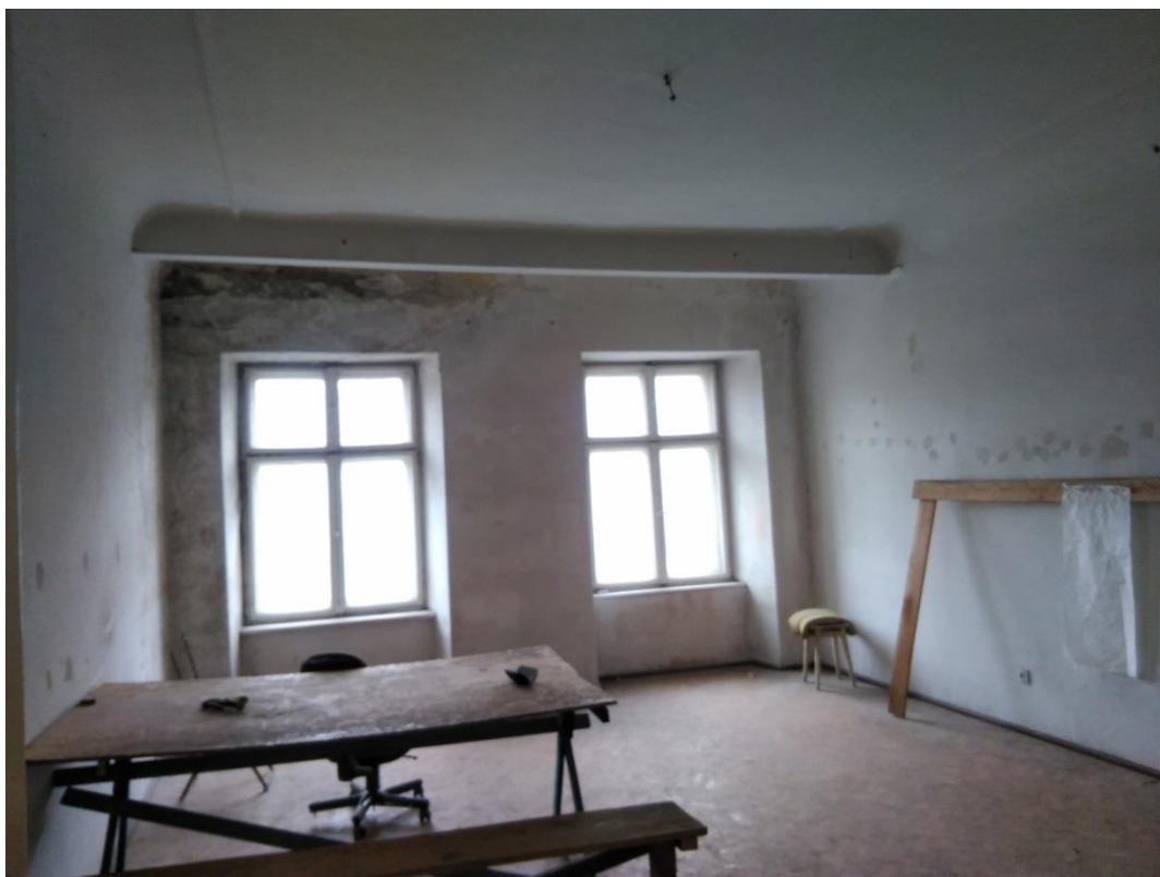
zaciek na ścianie zewnętrznej w pokoju dużym
