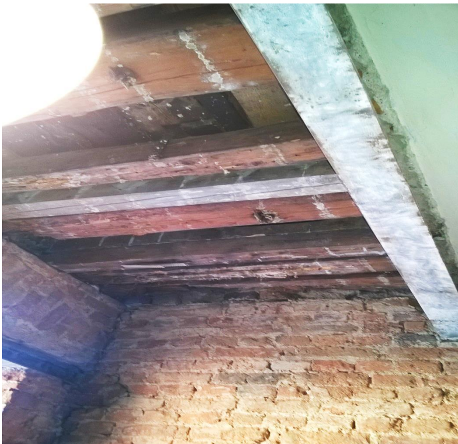
zniszczone fragmenty belek stropowych pomiędzy podciągami a ścianą
