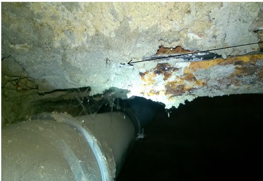
fot. nr 4 zdemontowany fragment dolnej stopki stalowego nadproża
