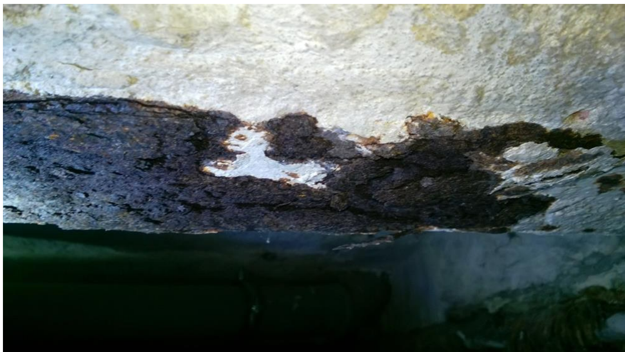
fot. nr 1 korozja powodująca rozwarstwienie dolnych pól belek stropowych -belka korytarzowa
