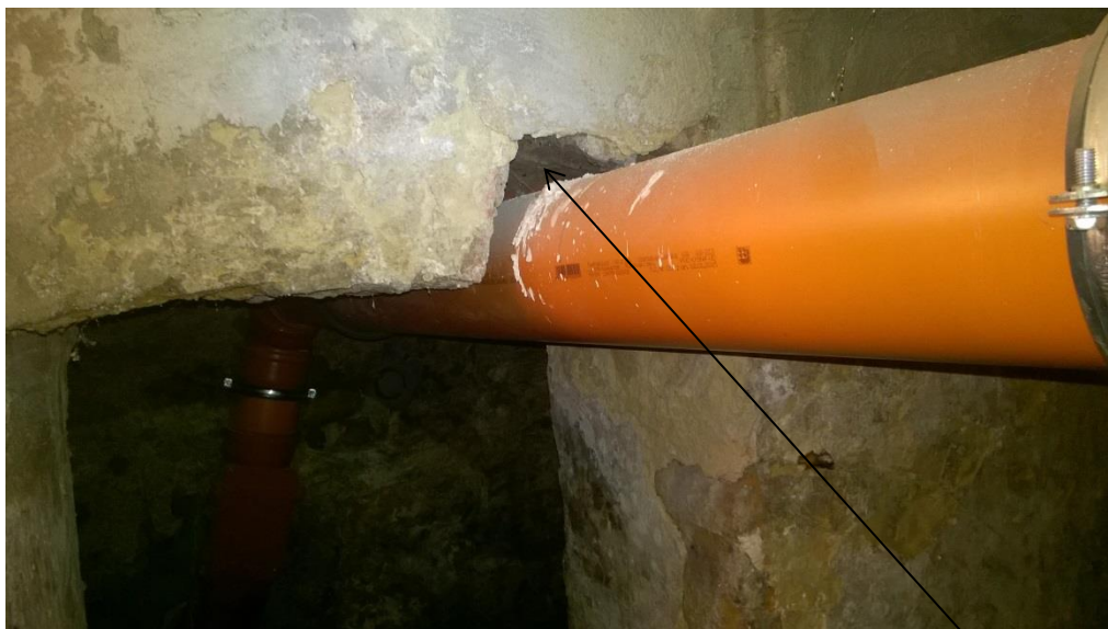
fot. nr 3 podkute nadproże ceramiczne otworu drzwiowego
