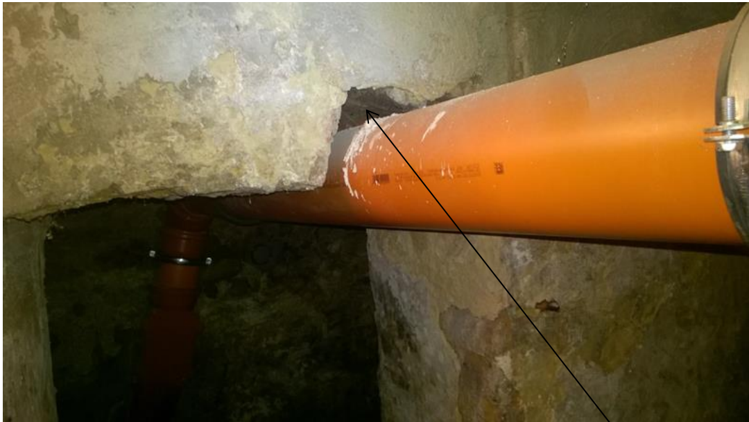
fot. nr 3 podkucie nadproża ceramiczne otworu drzwiowego
