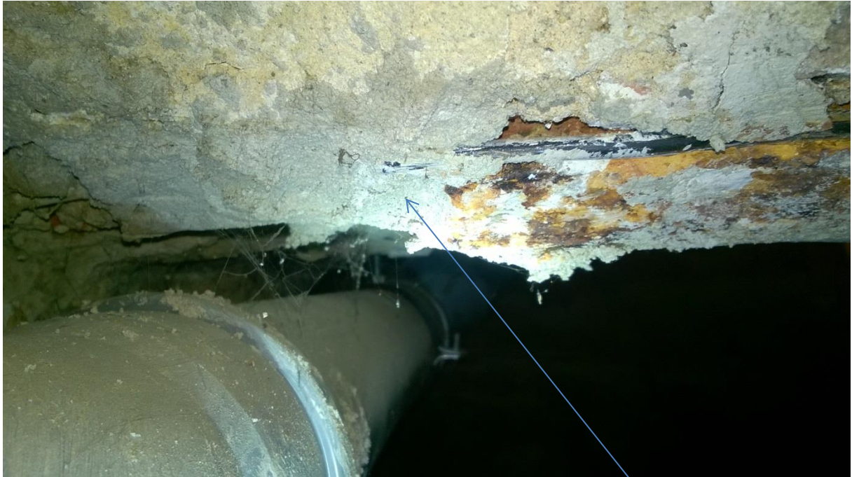
fot. nr 4 zdemontowany fragment dolnej stopki stalowego nadproża
