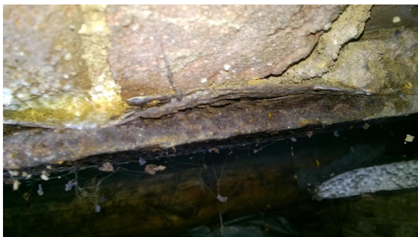
fot. nr 2 korozja ogólna belki stropowej- belka w piwnicy przy komorze technicznej
