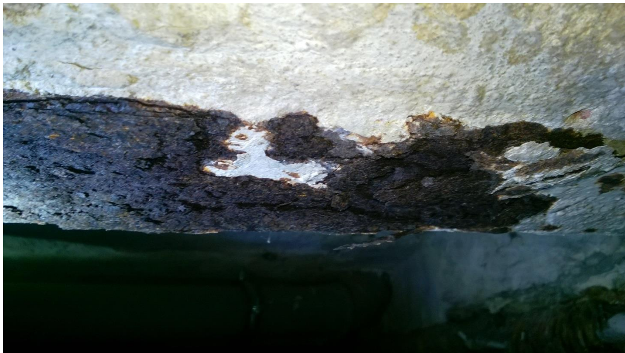
fot. nr 1 korozja powodująca rozwarstwienie dolnych półek belek stropowych - belka korytarzowa
