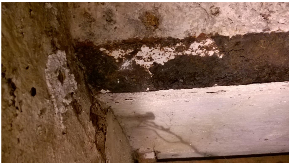
fot. nr 2 skorodowana belka stropowa w środkowej części piwnicy
