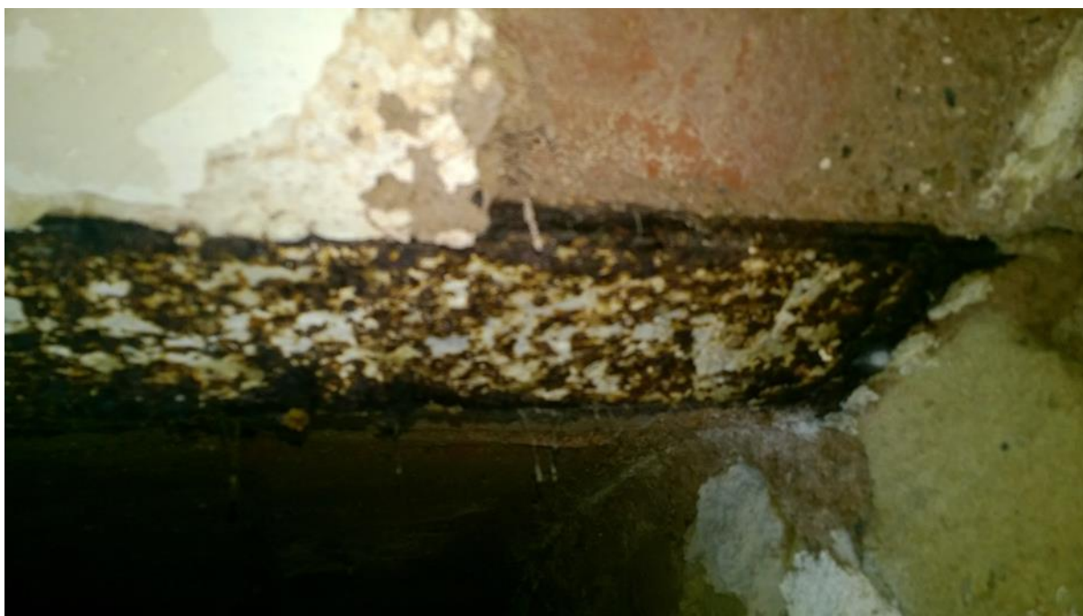
fot. nr 1 korozja powodująca rozwarstwienie dolnych pól belk stropowych – belka w pralni
