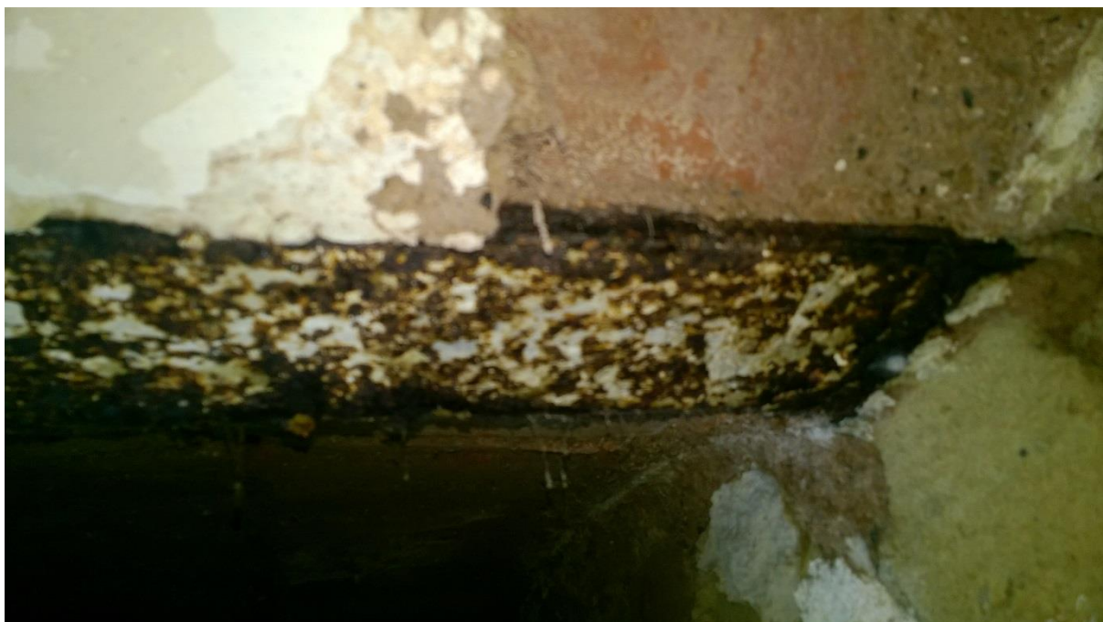
fot. nr 1 korozja powodująca rozwarstwienie dolnych pólek belek stropowych -belka w pralni
