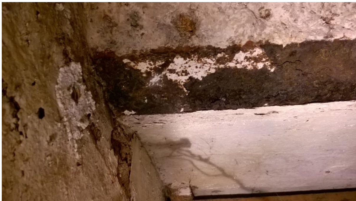
fot. nr 2 skorodowana belka stropowa w pomieszczeniu piwnicznym
