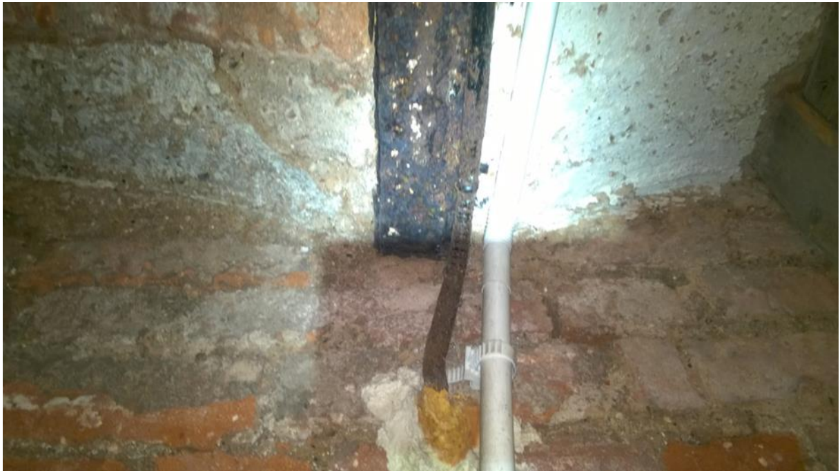
fot. nr 1 korozja powodująca rozwarstwienie dolnych pól belek stropowych - belka skrajnej prawej piwnicy
