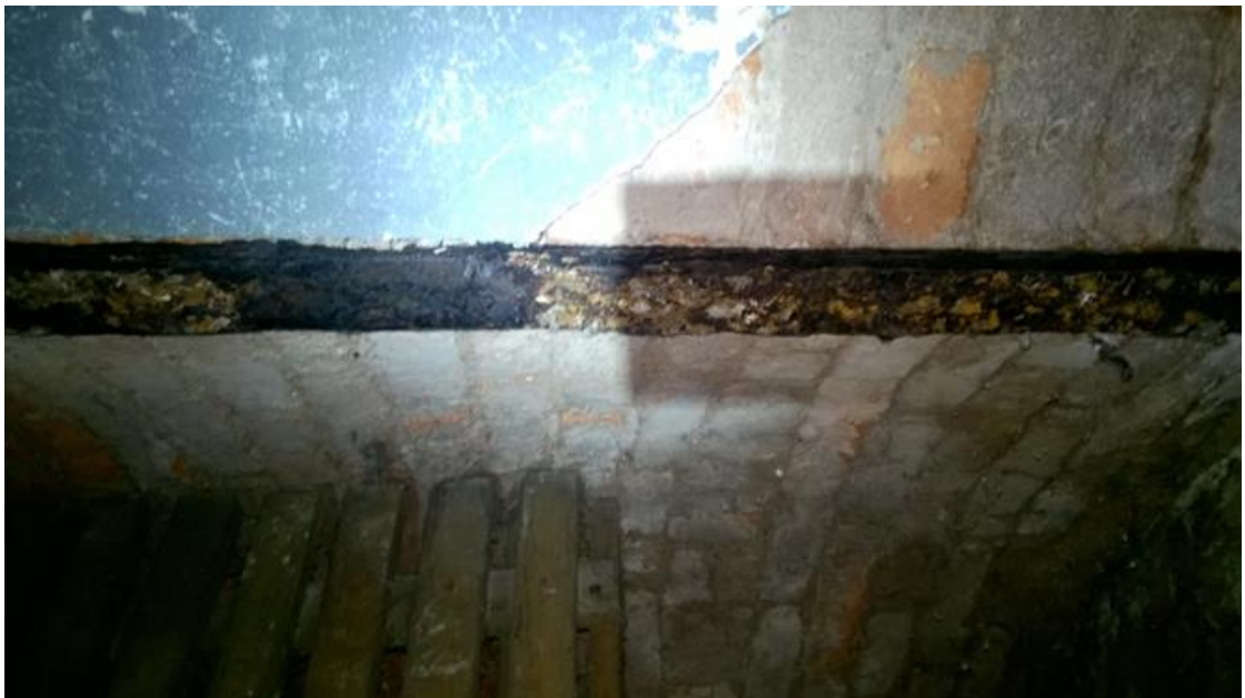
fot. nr 2 korozja ogólna belki stropowej- belka w korytarzu piwnicznym
