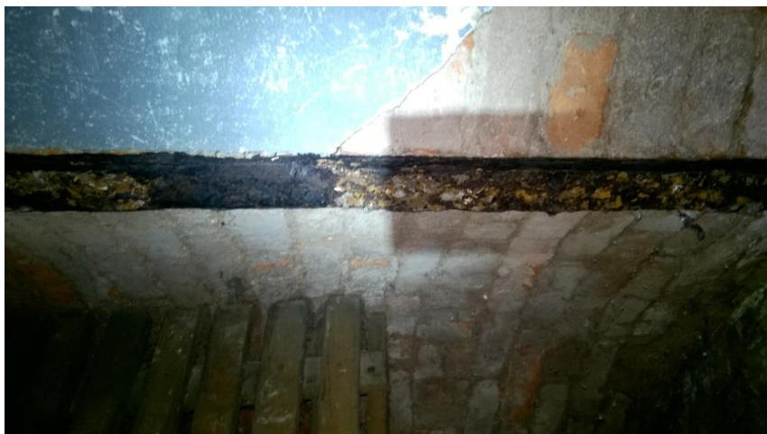
fot. nr 2 korozja ogólna belki stropowej- belka w korytarzu piwnicznym
