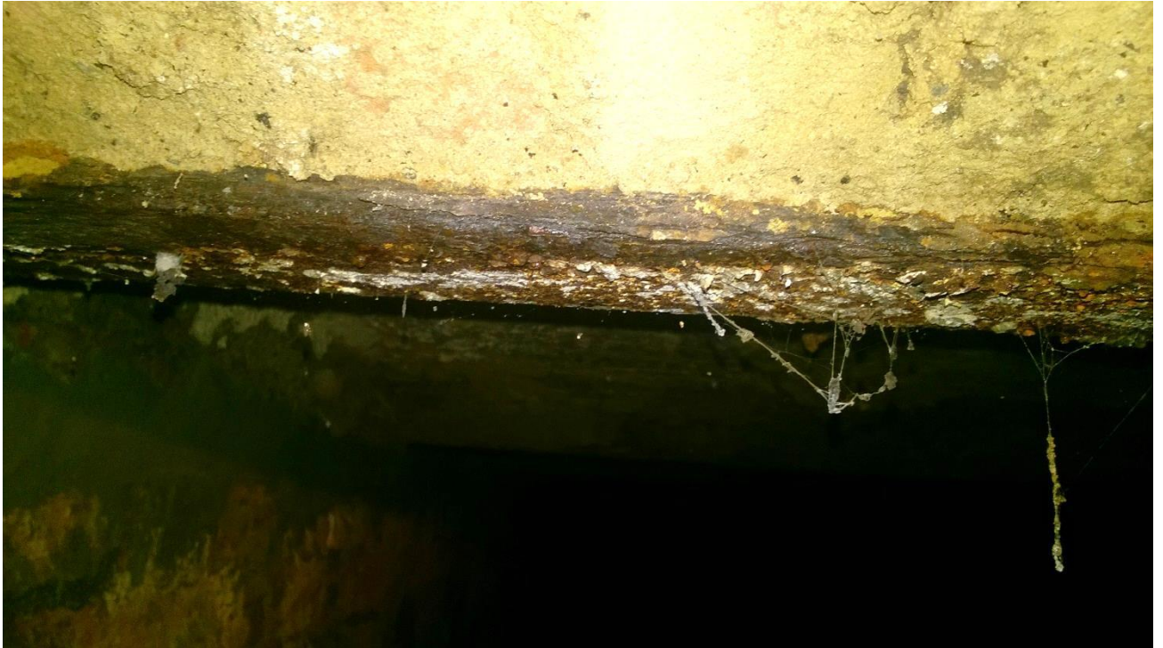
fot. nr 1 korozja powodująca rozwarstwienie dolnych pól belk stropowych
