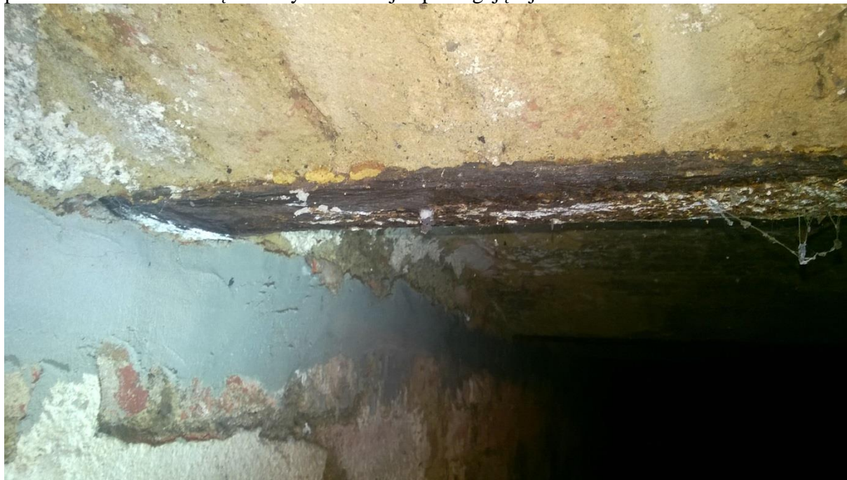
fot. nr 3 skorodowana belka stropowa w pomieszczeniu piwnicznym
