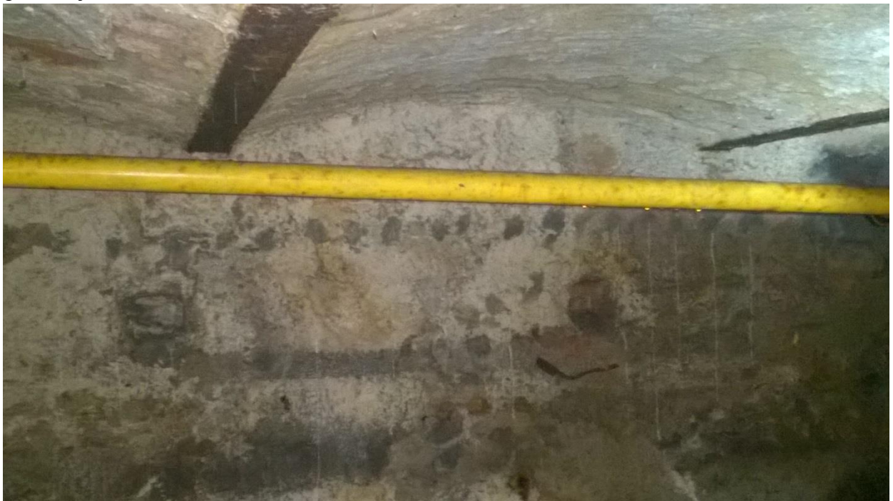
fot. nr 2 roszenie wilgoci na stołowej rurze gazowej
