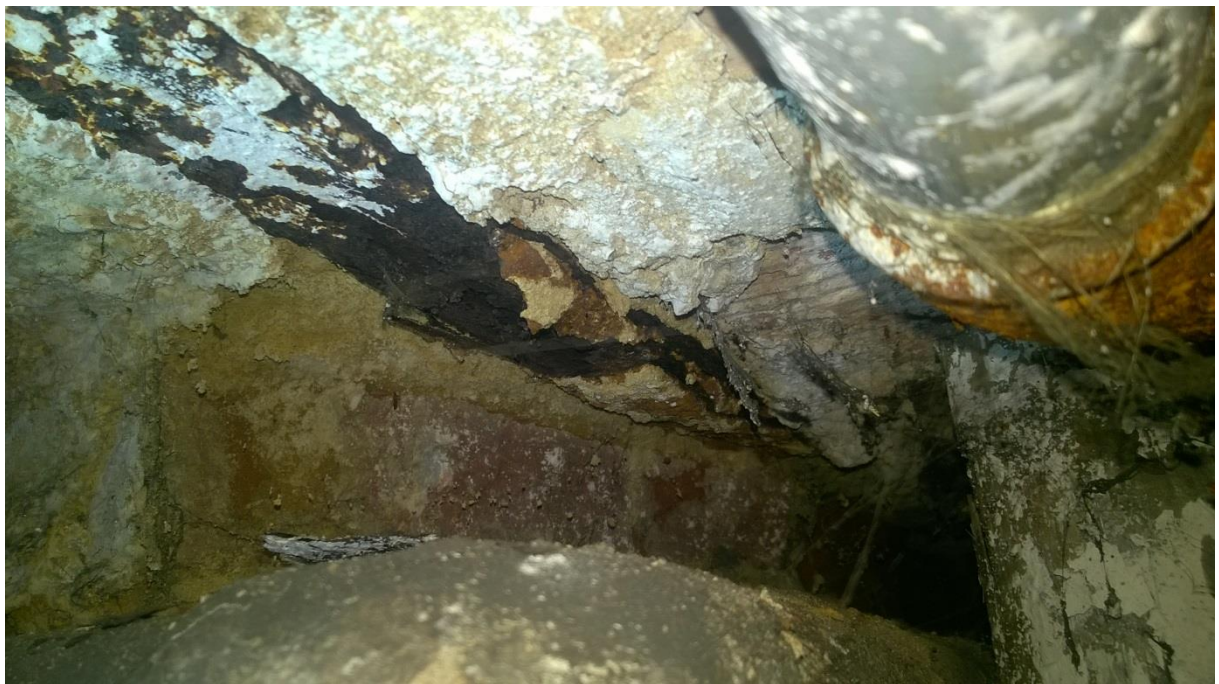
fot. nr 2 korozja ogólna belki nadprożowej pokute oparcie nadproża
