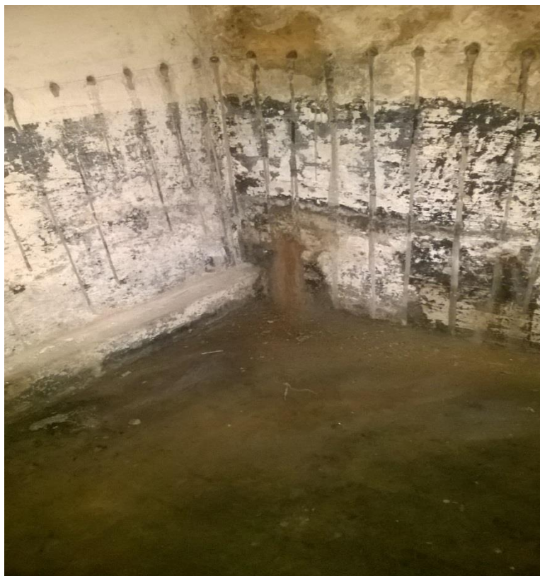
nieskuteczne prace iniekcyjne w pomieszczeniu pralni
