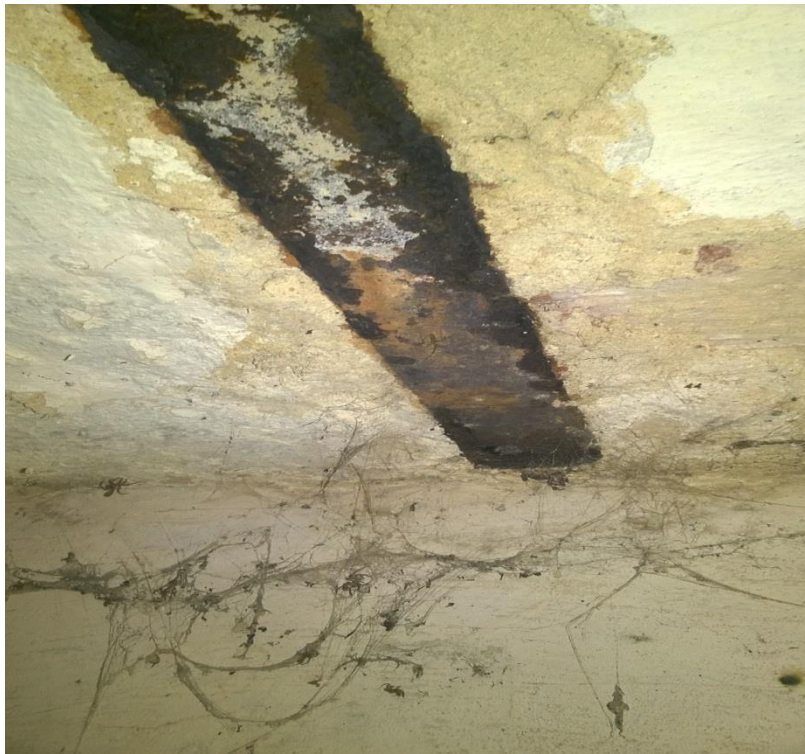
fot. nr 1 korozja powodująca rozwarstwienie dolnych pólek belek stropowych
