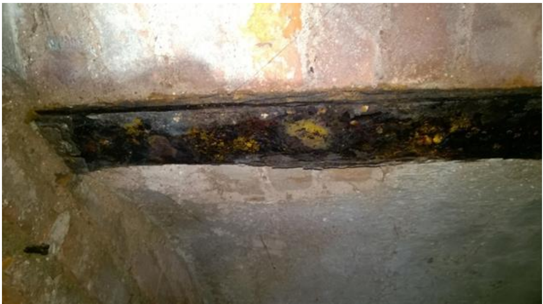
fot. nr 2 korozja ogólna belki stropowej- belka w kotłowni
