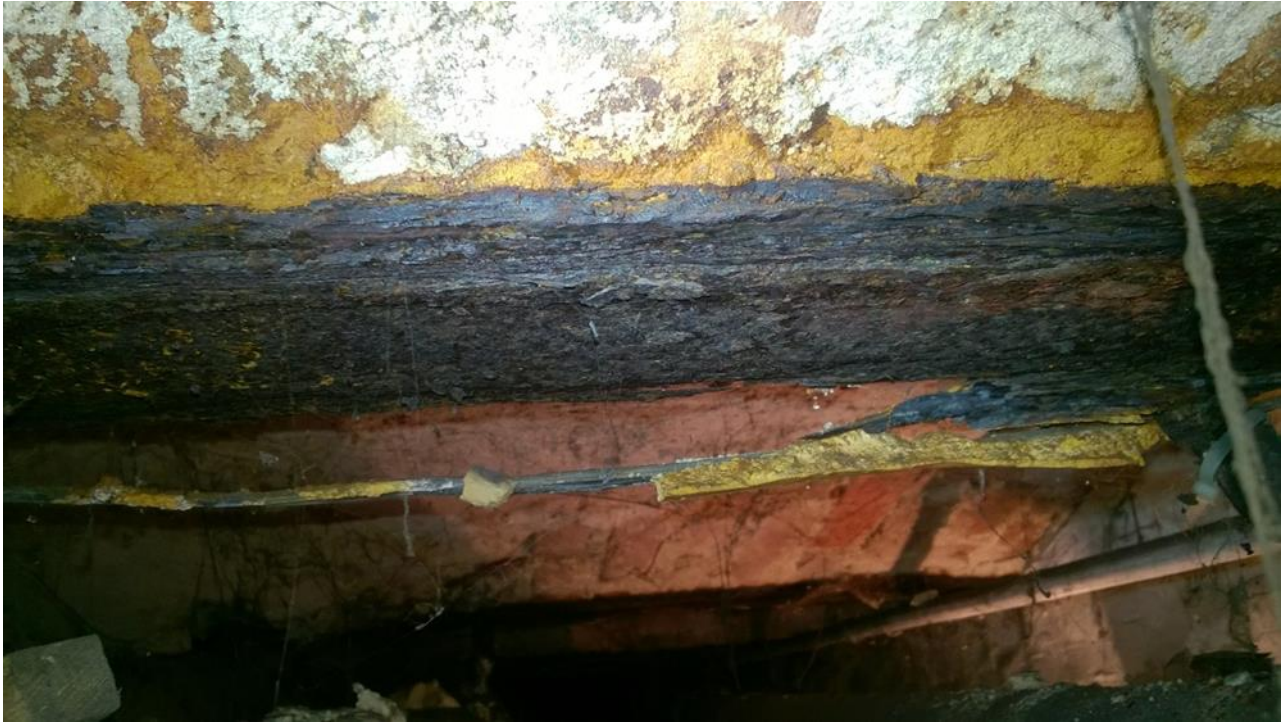
fot. nr 1 korozja powodująca rozwarstwienie dolnych pól belek stropowych -belka w lewej części piwnicy – belki o dużej rozpiętości 710cm i nietypowym przekroju 1280
