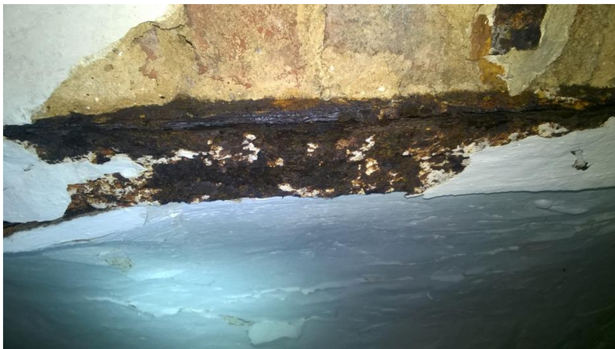
fot. nr 3 skorodowana belka stropowa w skrajnym prawym pomieszczeniu piwnicznym
