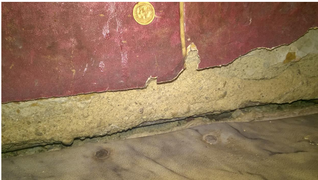
fot. nr 3 widoczne ugięcie posadzki w pomieszczeniu ubikacyjnym
