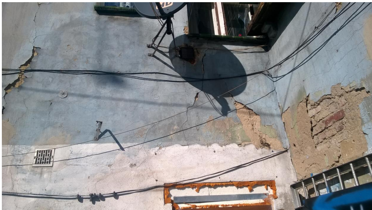
fot. nr 1 spękanie ściany zewnętrznej
