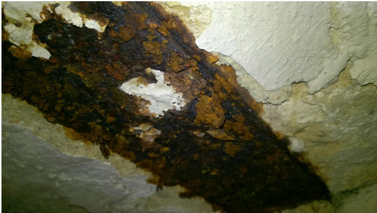
fot. nr 1 rozwarstwiająca korozja dolnej półki belki stropowej piwnica po prawej stronie korytarza piwnicznego
