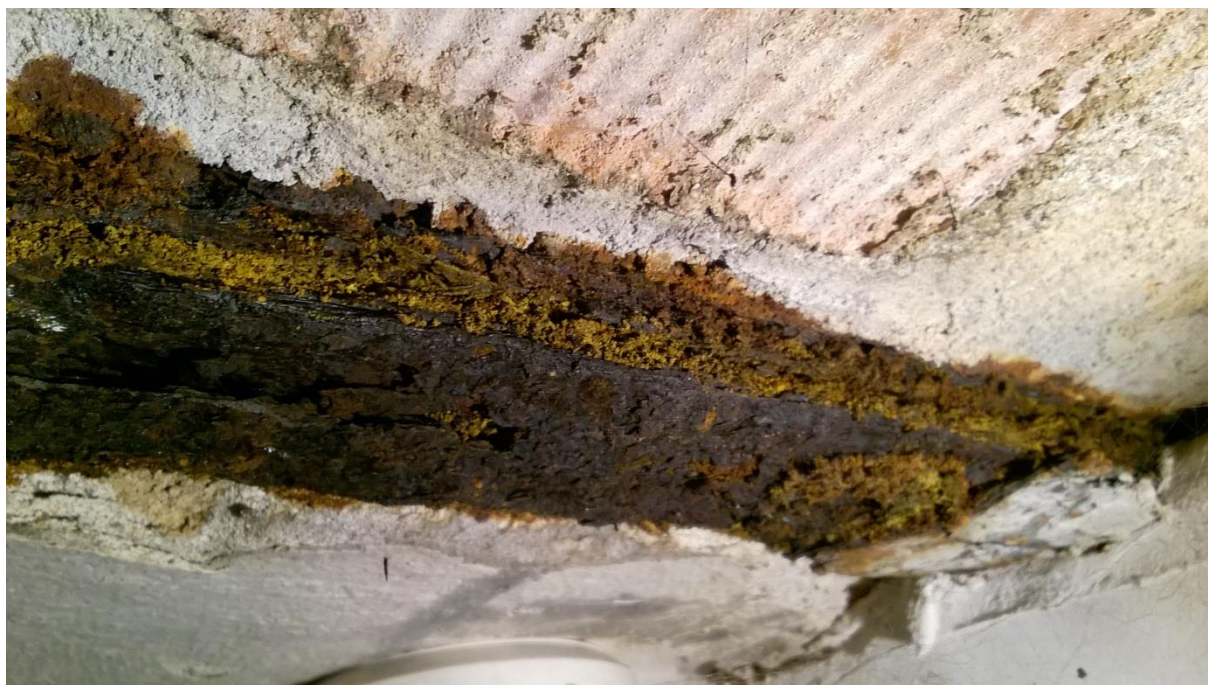
fot 3 silna korozja rozwarstwiająca dolne półki na całej długości belki
