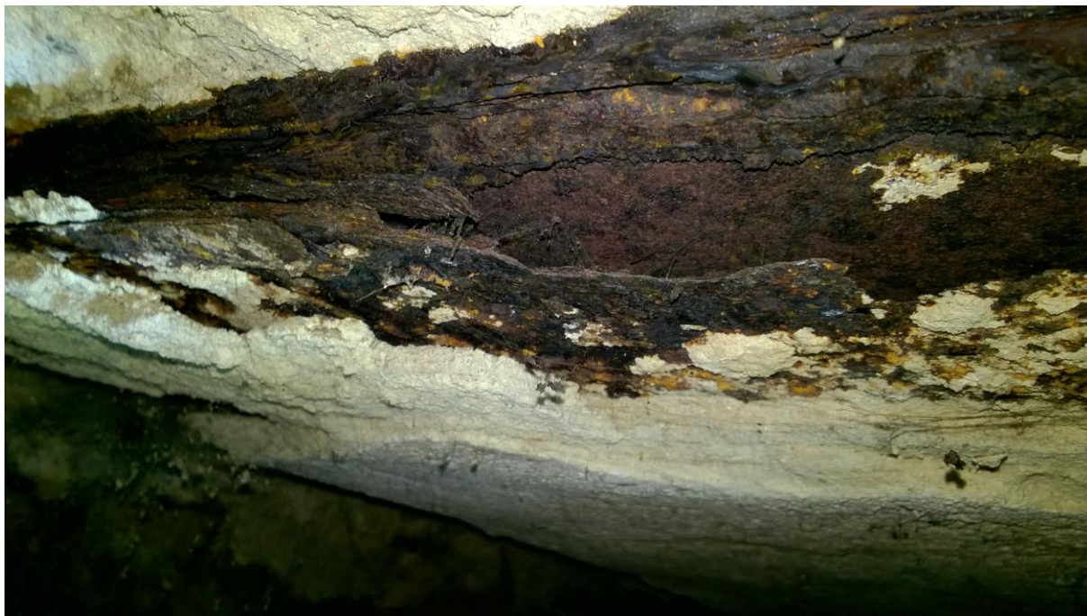
fot. nr 3 bardzo silna korozja rozwarstwiająca belka w prawym pomieszczeniu piwnicznym na końcu korytarza
