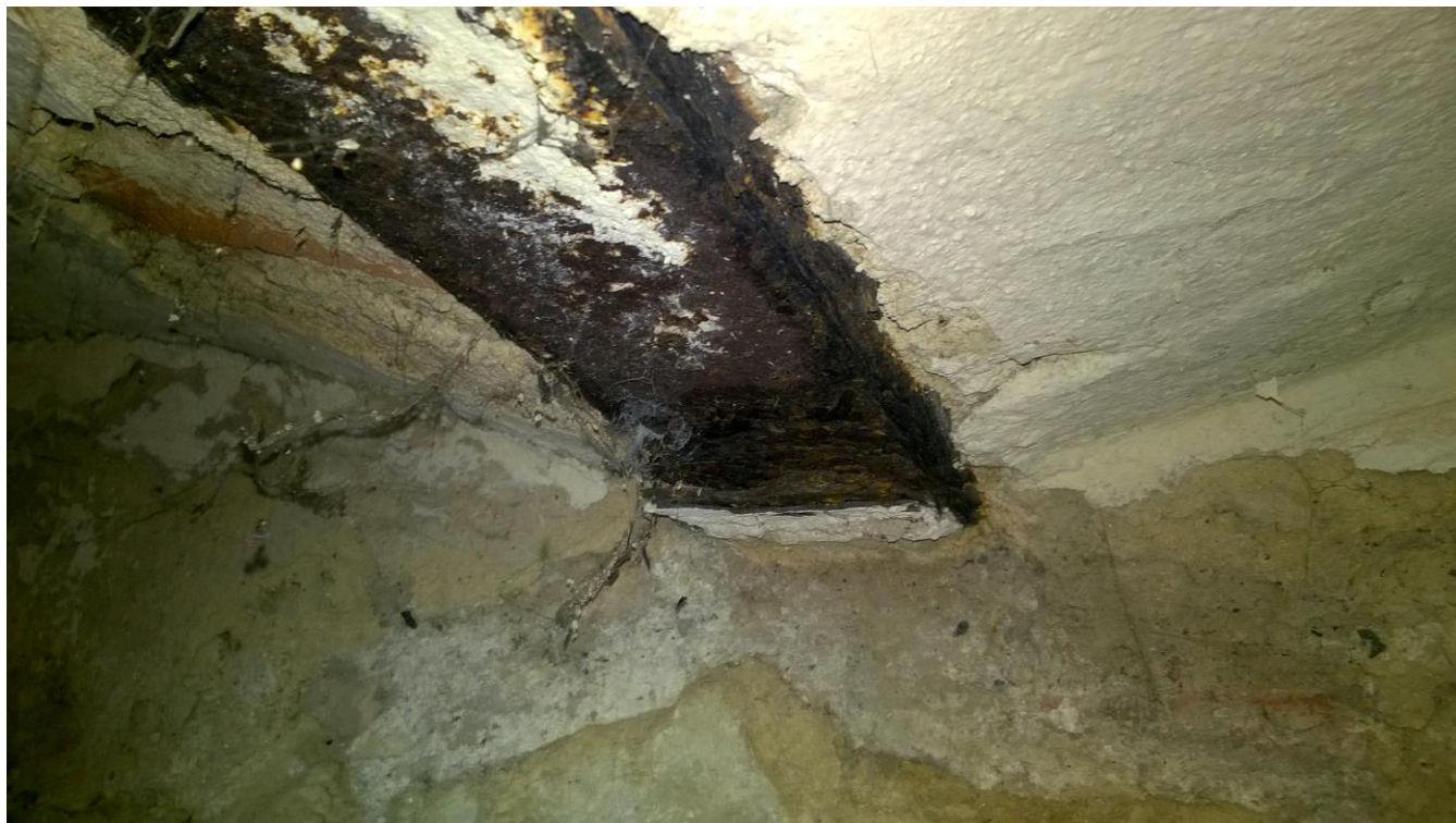
fot. nr 1 rozwarstwiająca korozja dolnej półki belki stropowej piwnica po prawej stronie przy schodach
