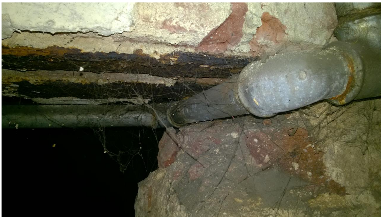
fot. nr 4 podcięta podpora pod nadprożem widoczne skorodowane belki nadproża
