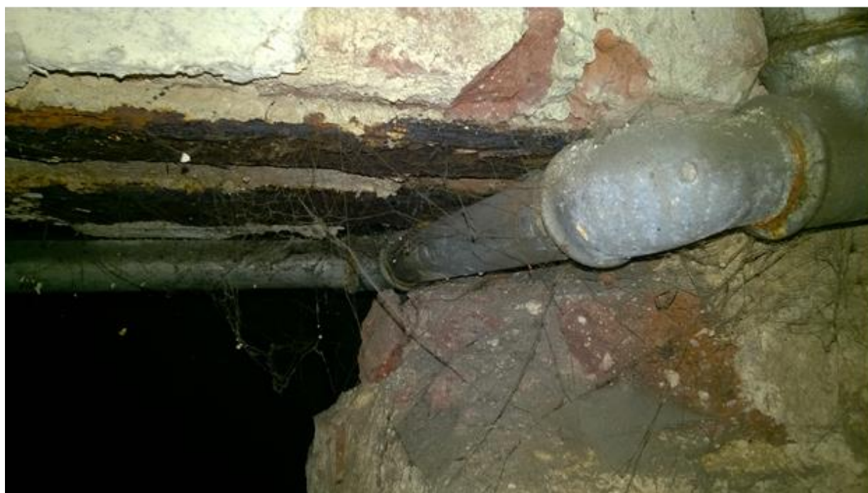
podcięta podpora pod nadprożem widoczne skorodowane belki nadproża
