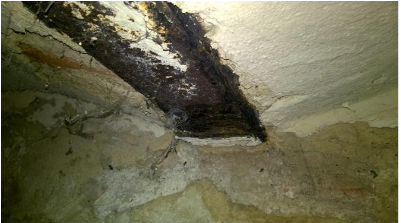
korozja powodująca rozwarstwienie dolnych półek belek stropowych –piwnica po prawej stronie przy schodach
