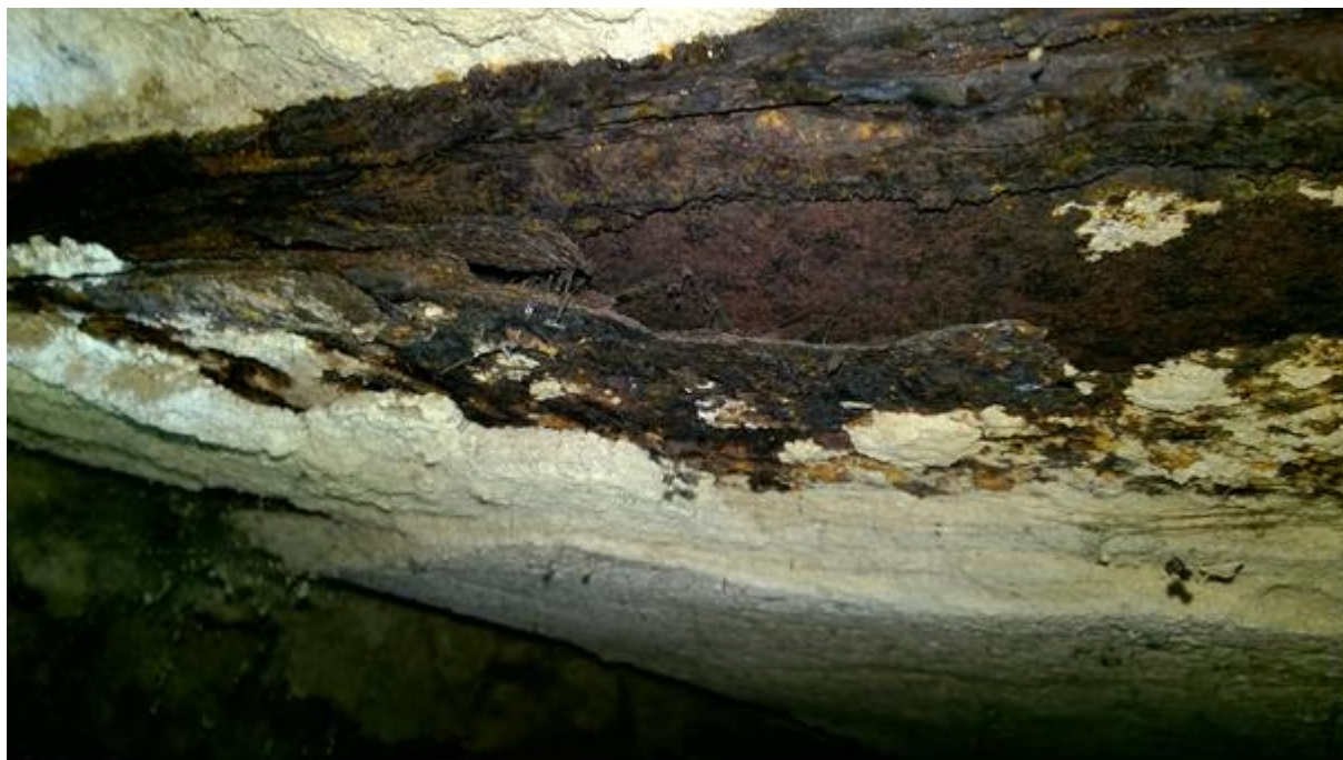
bardzo silna korozja rozwarstwiająca belka w prawym pomieszczeniu piwnicznym na końcu korytarza
