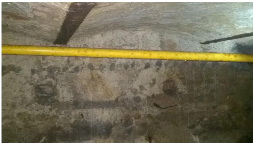
fot. nr 2 widoczne na rurze stalowej roszczenie wilgoci
