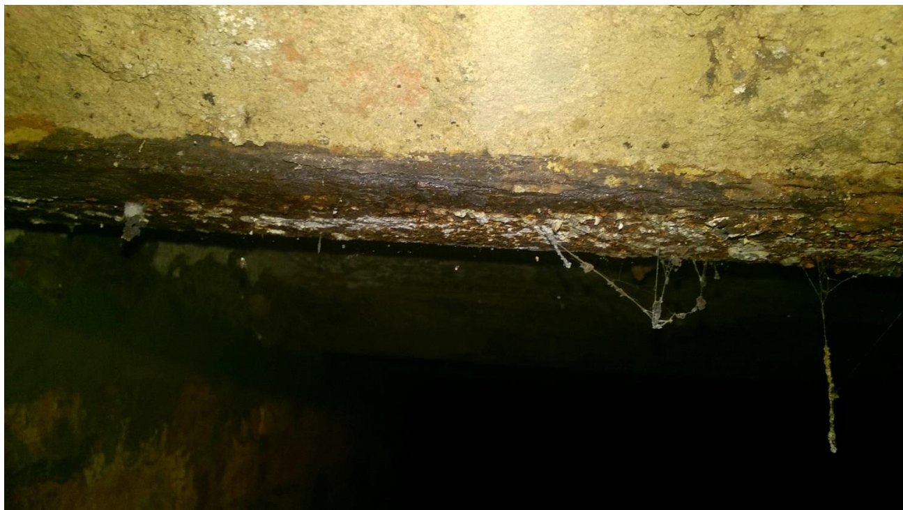
fot. nr 1 korozja powodująca rozwarstwienie dolnych pól belek stropowych
