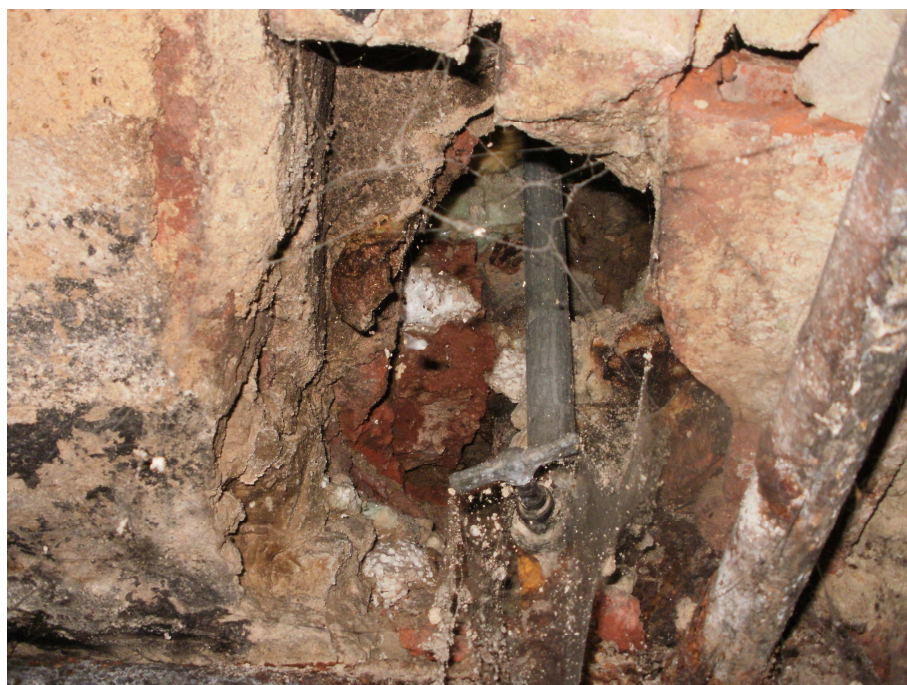
Zdjęcie nr 10 – ubytek w stropie nad pomieszczeniem nr 001
