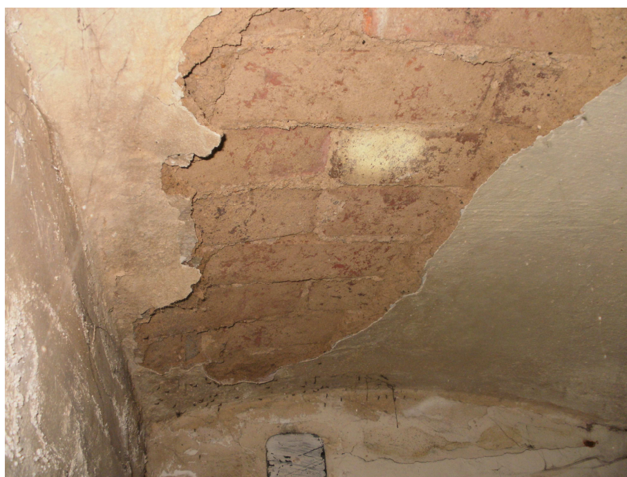
Zdjęcie nr 11 – ubytki w tynkowaniu stropu ceglanego
