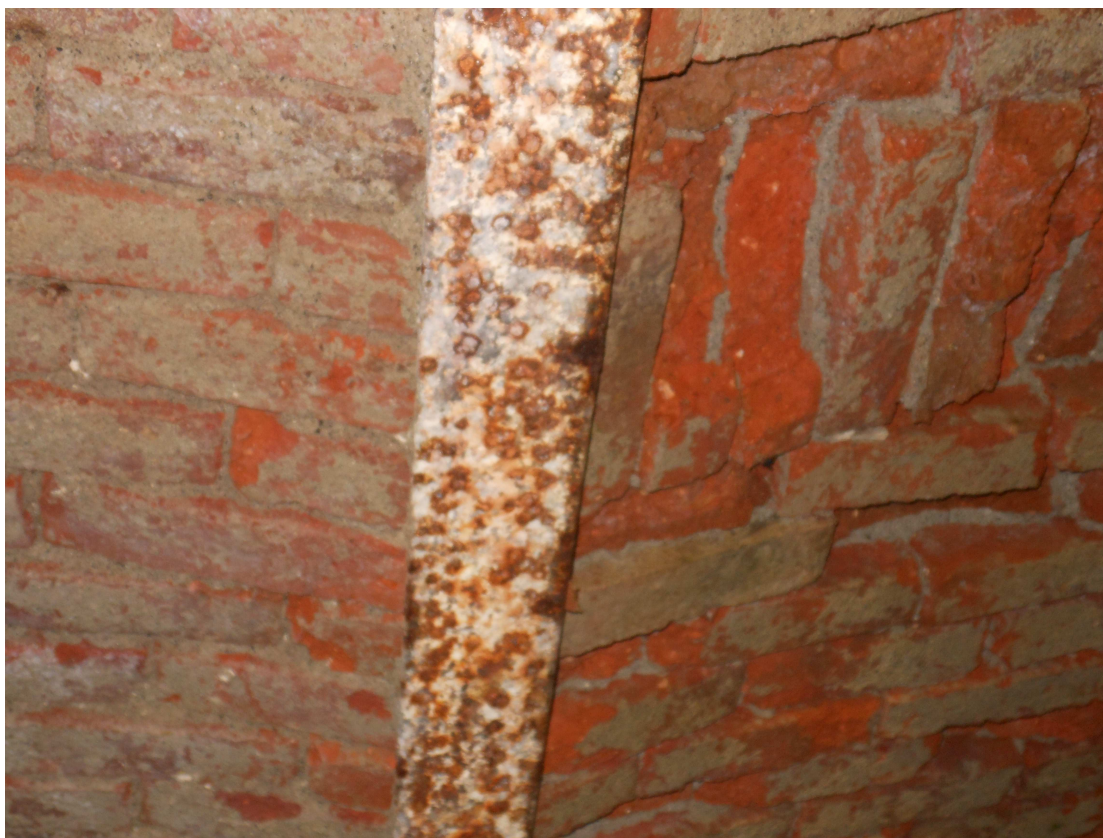
Fot. 04 – Strop odcinkowy. Zniszczenie wilgocią pasa dolnego żebra stalowego i płyty ceramicznej.
