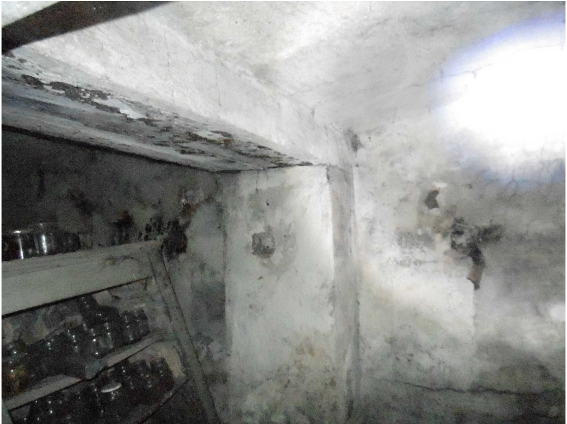
Fot. 08 – Nadproże stalowe 3-dźwigarowe. Oś "3".
