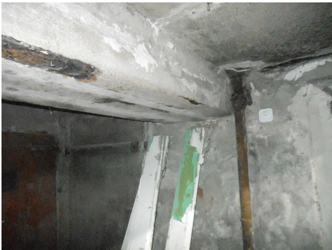
Fot. 07 – Nadproże stalowe 3-dźwigarowe. Os "C".
