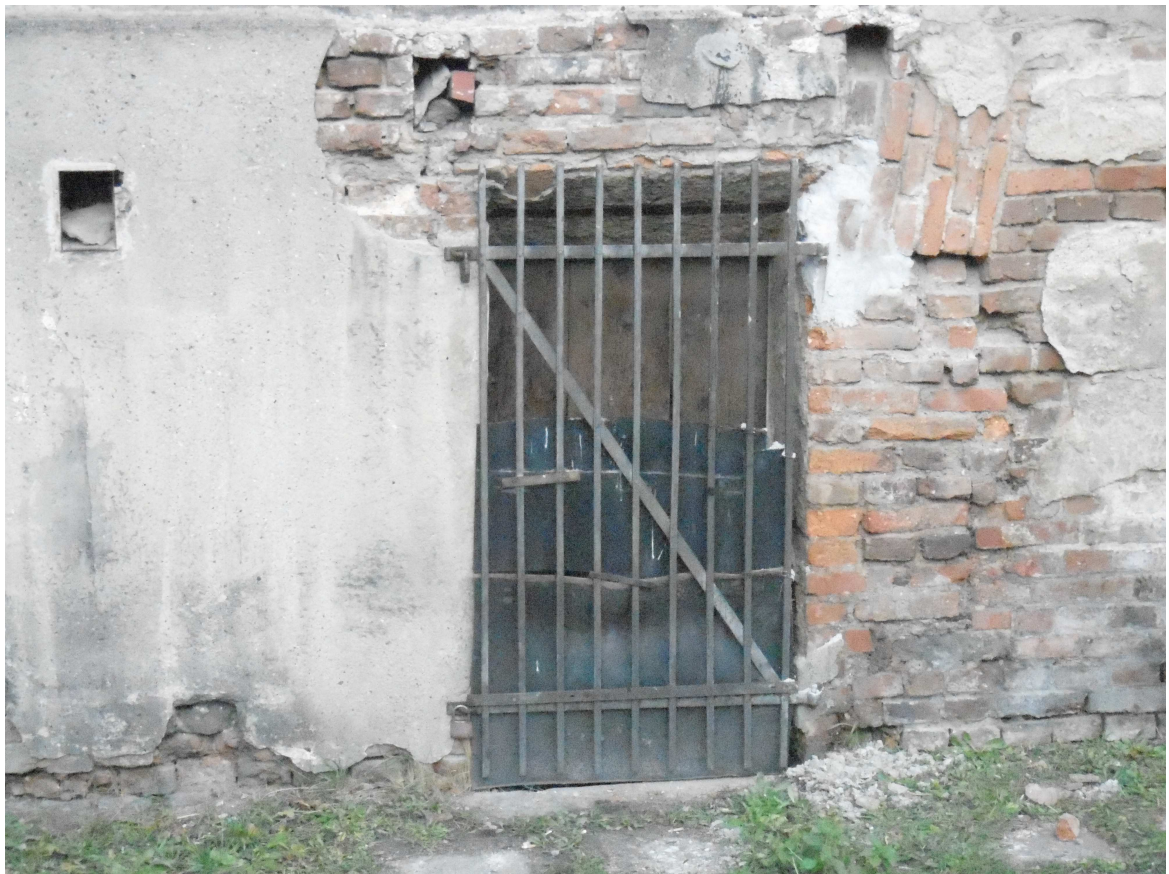
Rys. 23 – Elewacja tylna. Pęknięcia tynku.
