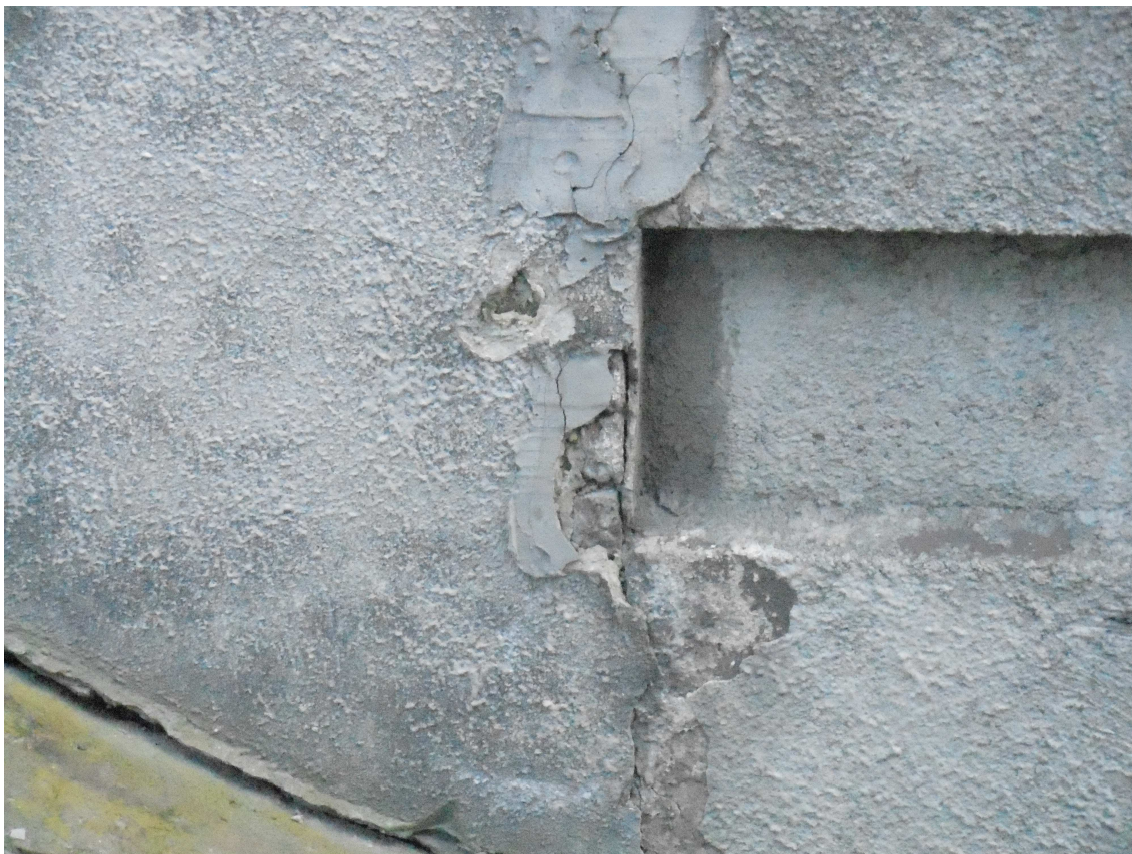
Fot. 20 – Elewacja szczytowa. Pęknięcia tynku.
