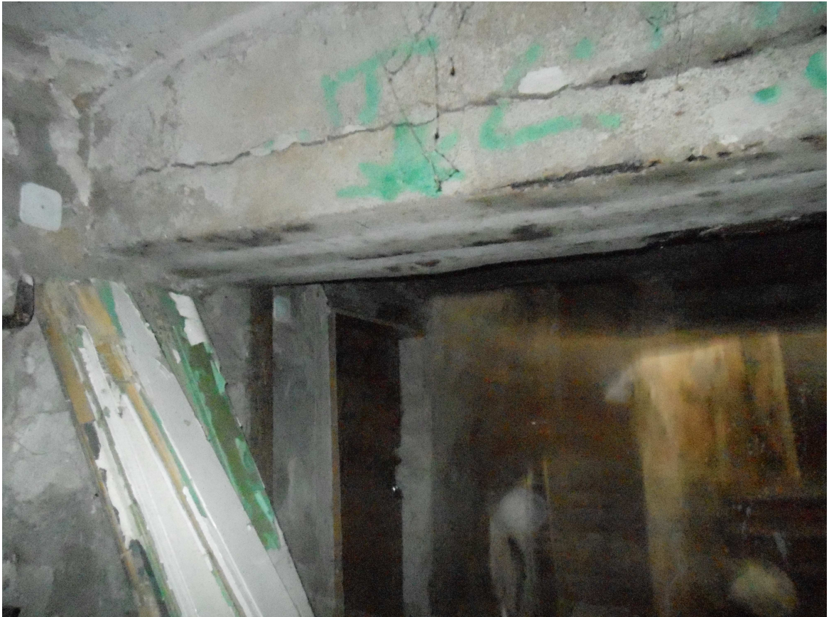
Fot. 13 – Nadproże stalowe 3-dźwigarowe. Oś "C". Zniszczenia.
