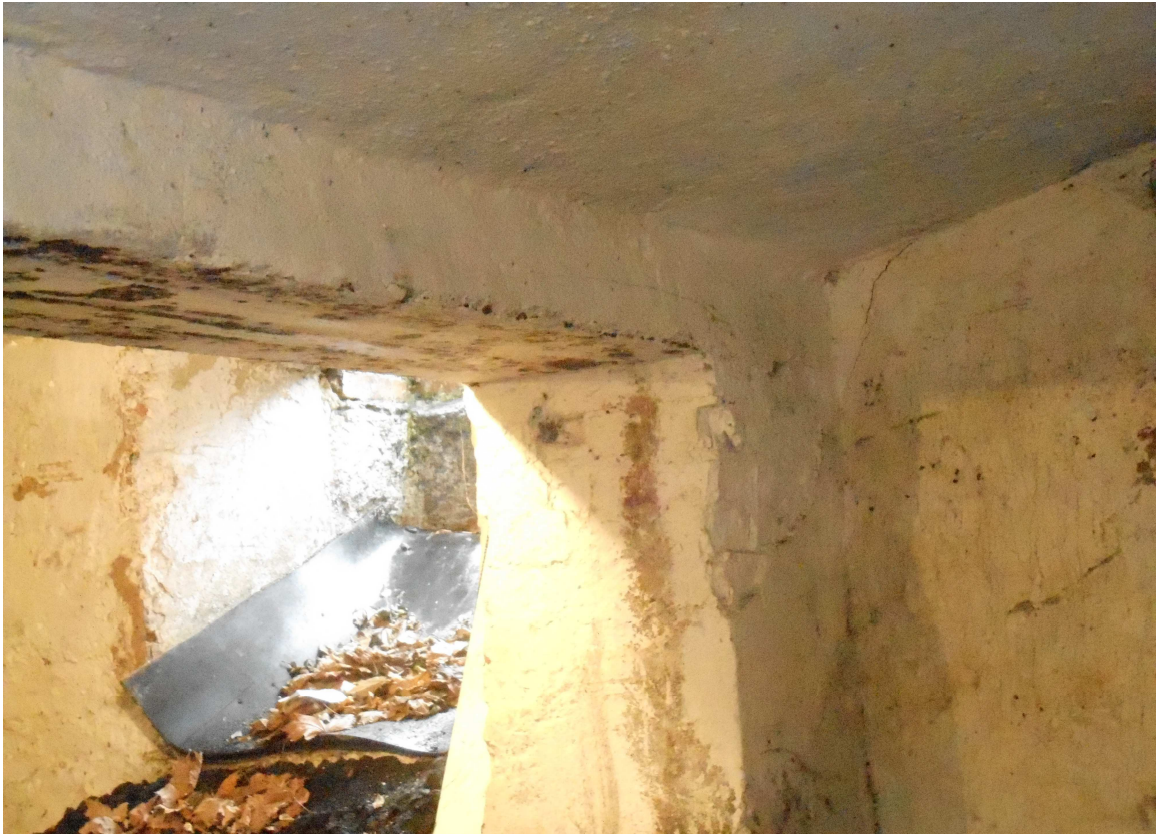
Fot. 10 – Nadproże stalowe 4-dźwigarowe. Oś "5".
