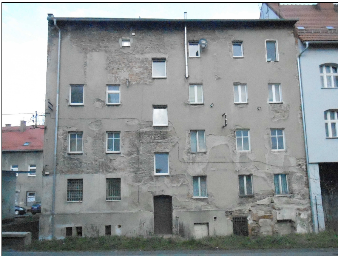
Fot. 17 – Elewacja tylna. Pęknięcia tynku.
