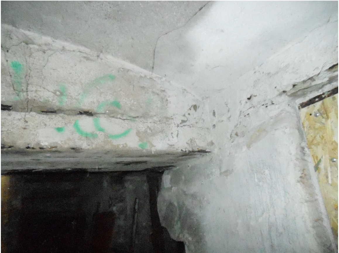
Fot. 12 – Nadproże stalowe 3-dźwigarowe. Oś "C".
