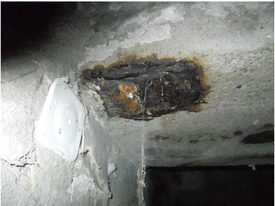
Fot. 11 – Nadproże stalowe 3-dźwigarowe. Oś "B".
