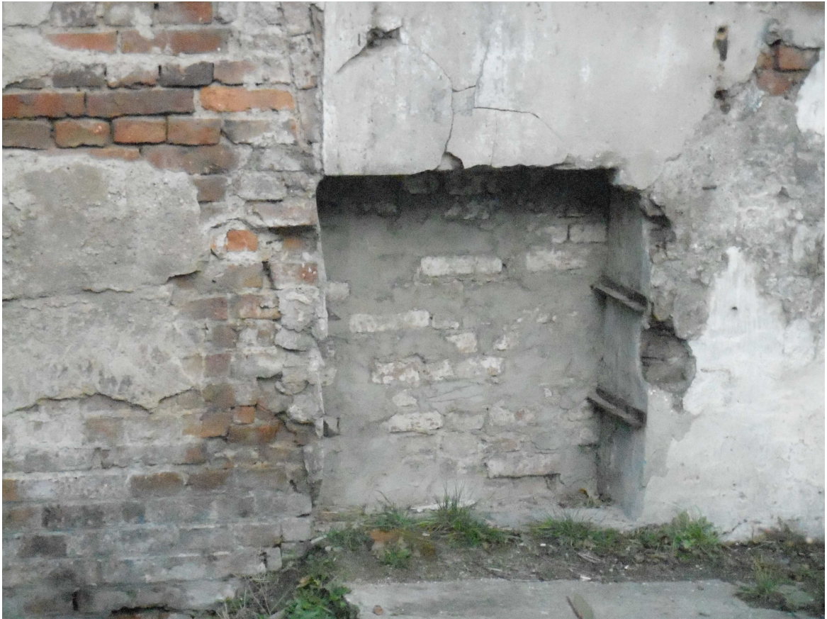
Rys. 22 – Elewacja tylna. Pęknięcia tynku.
