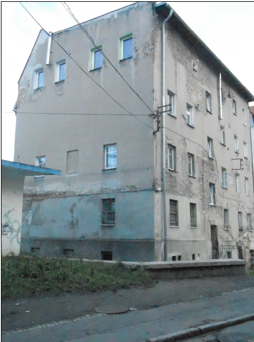
Fot. 18 – Elewacja szczytowa. Pęknięcia tynku.
