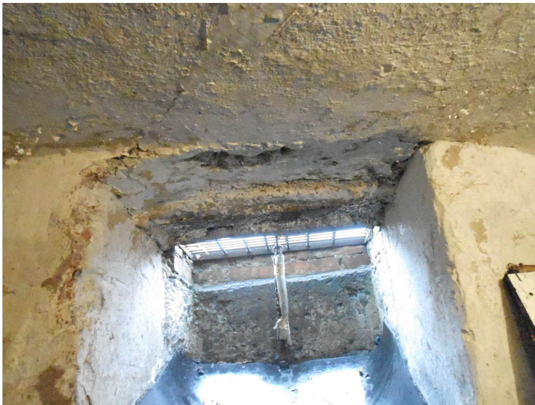
Fot. 05 – Strop odcinkowy. Zniszczenie wilgocią stropu. Do skucia.
