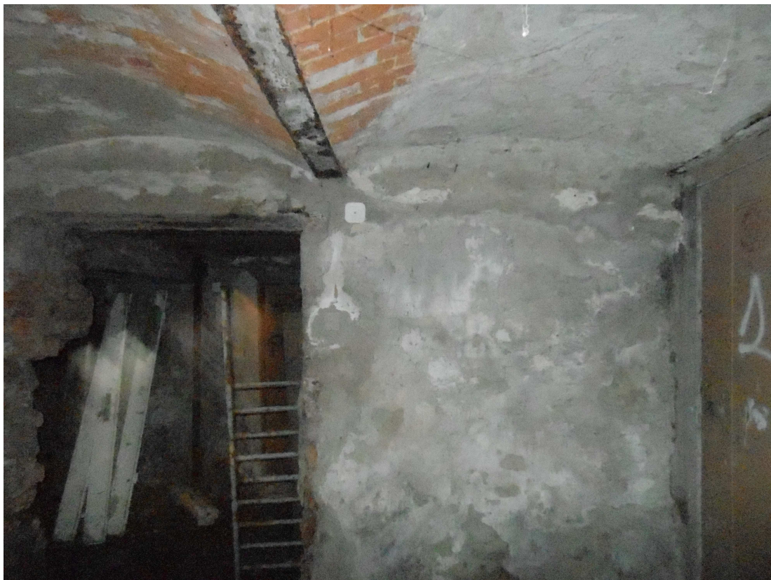
Fot.03 - Pom.011- Piwnica ogólna. Strop odcinkowy. Zniszczenie przy otworze drzwiowym.
