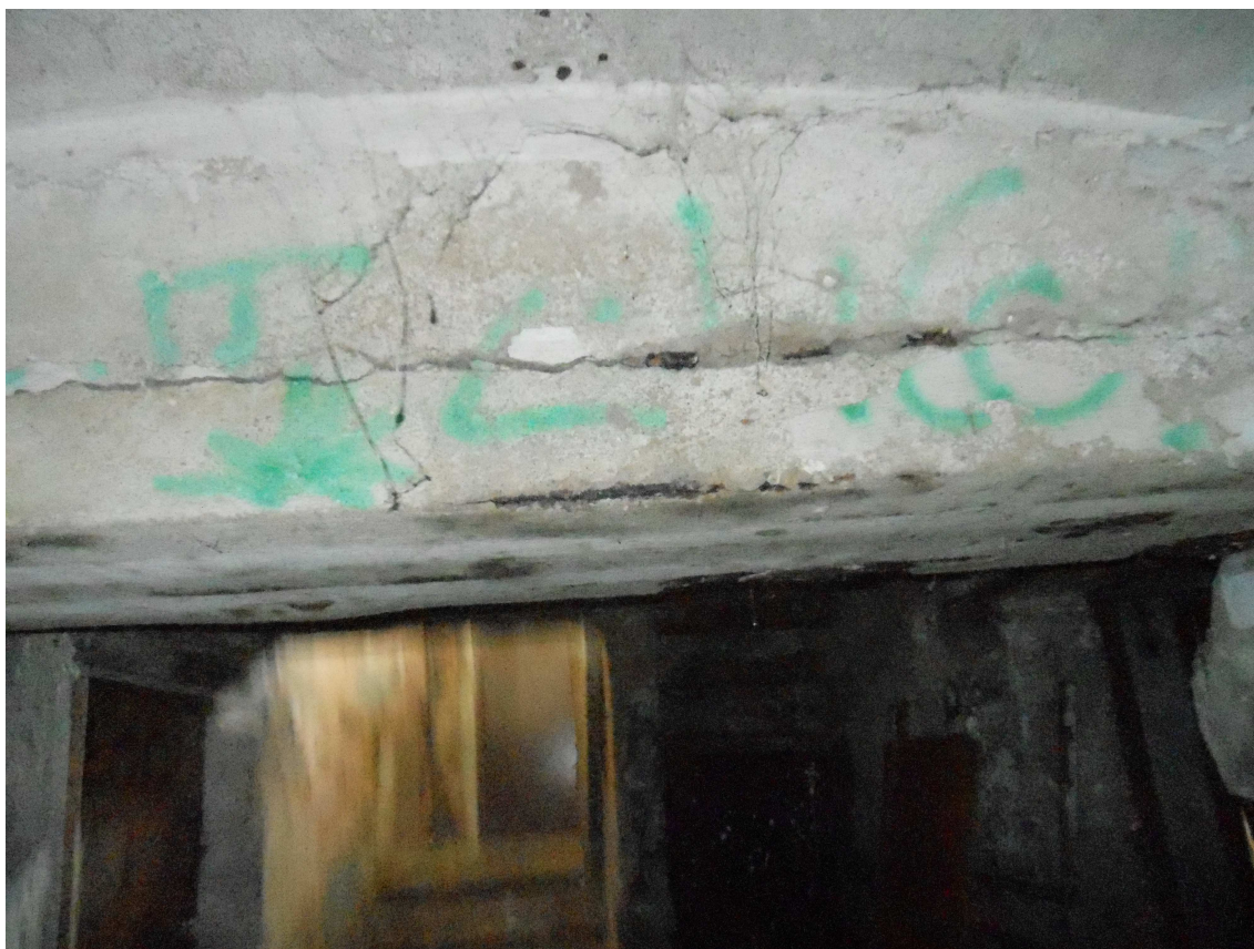
Fot. 14 – Nadproże stalowe 3-dźwigarowe. Oś "F". Zniszczenia.
