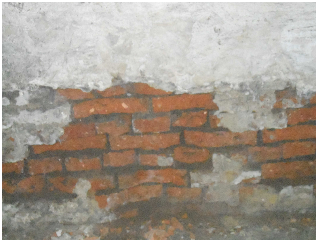
Fot. 06 – Ściany piwnic. Zniszczenie wilgocią spoin i glazury cegieł.
