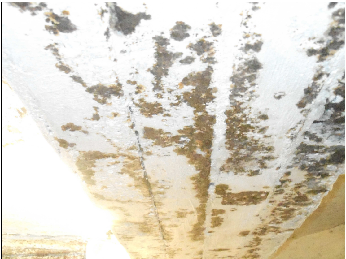
Fot. 09 – Nadproże stalowe 4-dźwigarowe. Widok z dołu. Oś "2".
