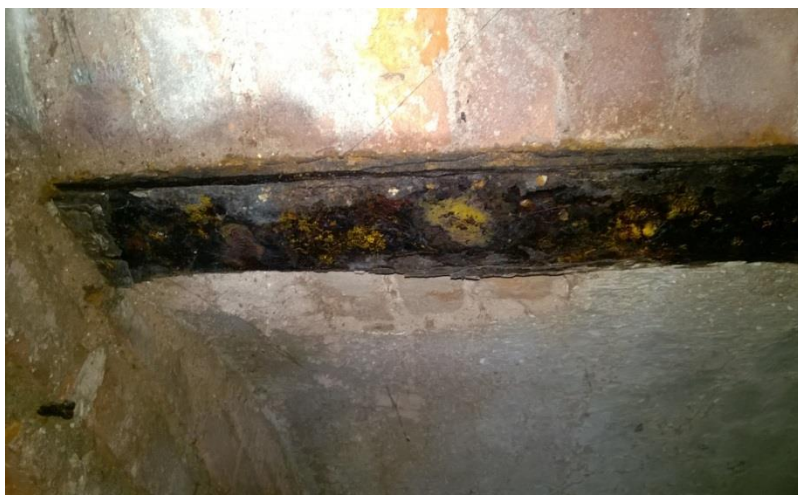
fot. nr 2 korozja ogólna belki stropowej- belka pomieszczeniu przy schodach lewa strona
