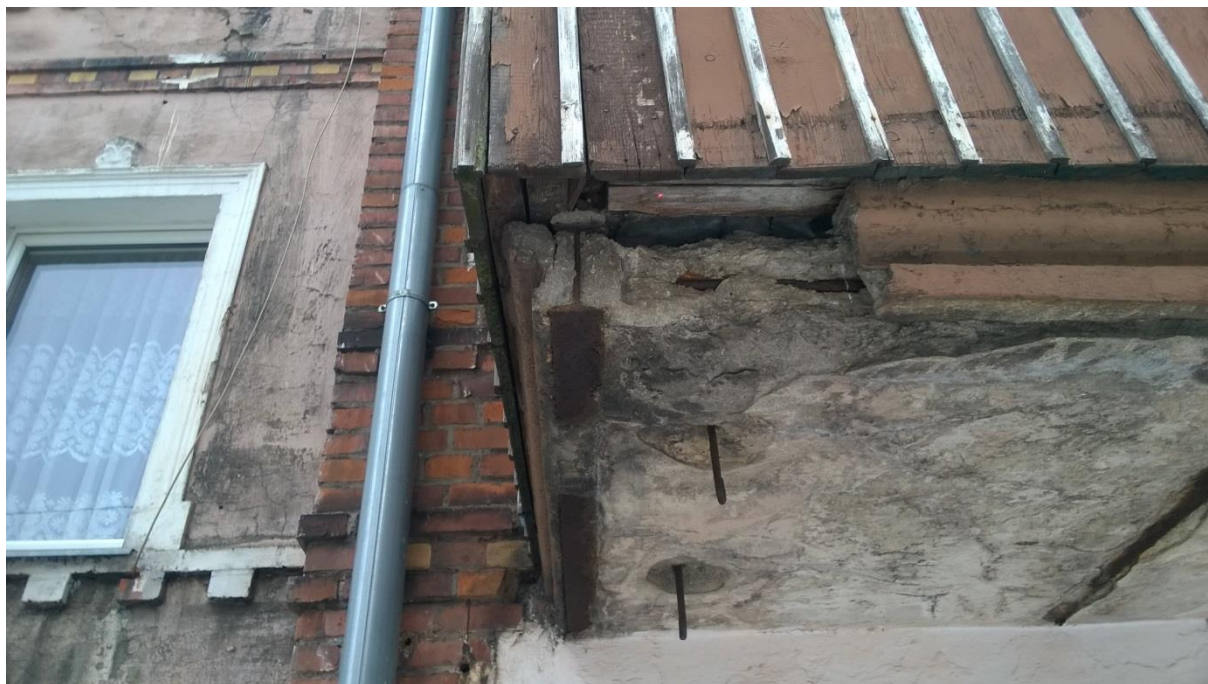
zniszczona płyta balkonowa , skorodowane belki nośne
