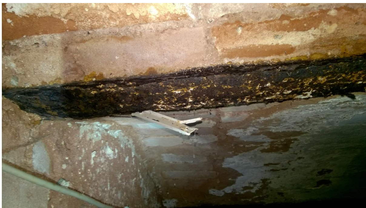
fot. nr 1 korozja powodująca rozwarstwienie dolnych półek belek stropowych -belka w piwnicy na końcu korytarza po lewej stronie
