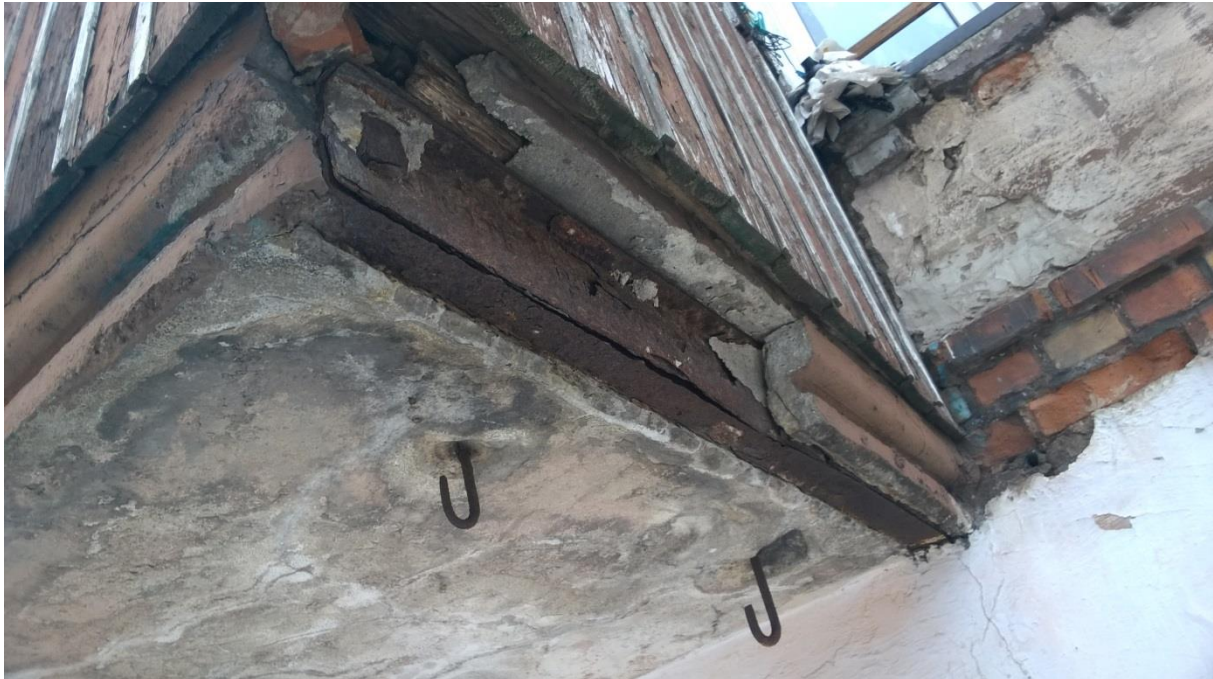
fot. nr 3 skorodowana belka płyty balkonowej ściany frontowej
