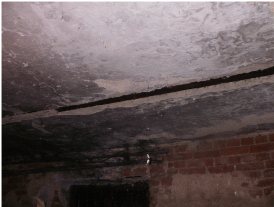
Zdjęcie nr 19 – widok stropu nad pomieszczeniem nr 0014, podparcie drewniane belek nr 16 i nr 17
