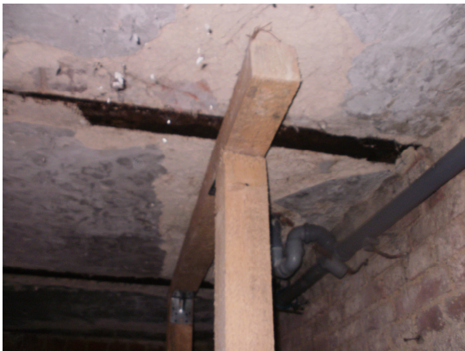
Zdjęcie nr 19 – widok stropu nad pomieszczeniem nr 0014, podparcie drewniane belek nr 16 i nr 17
