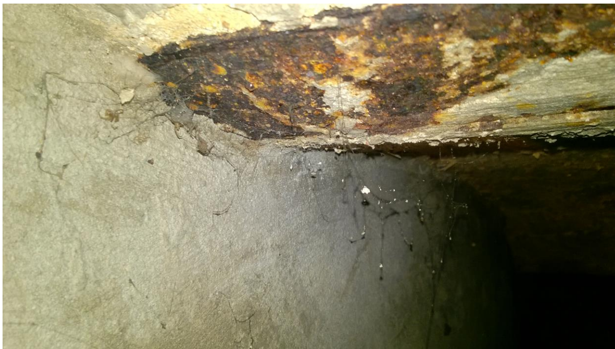
fot. nr 2 korozja rozwarstwiająca w strefie przypodporowej belki
