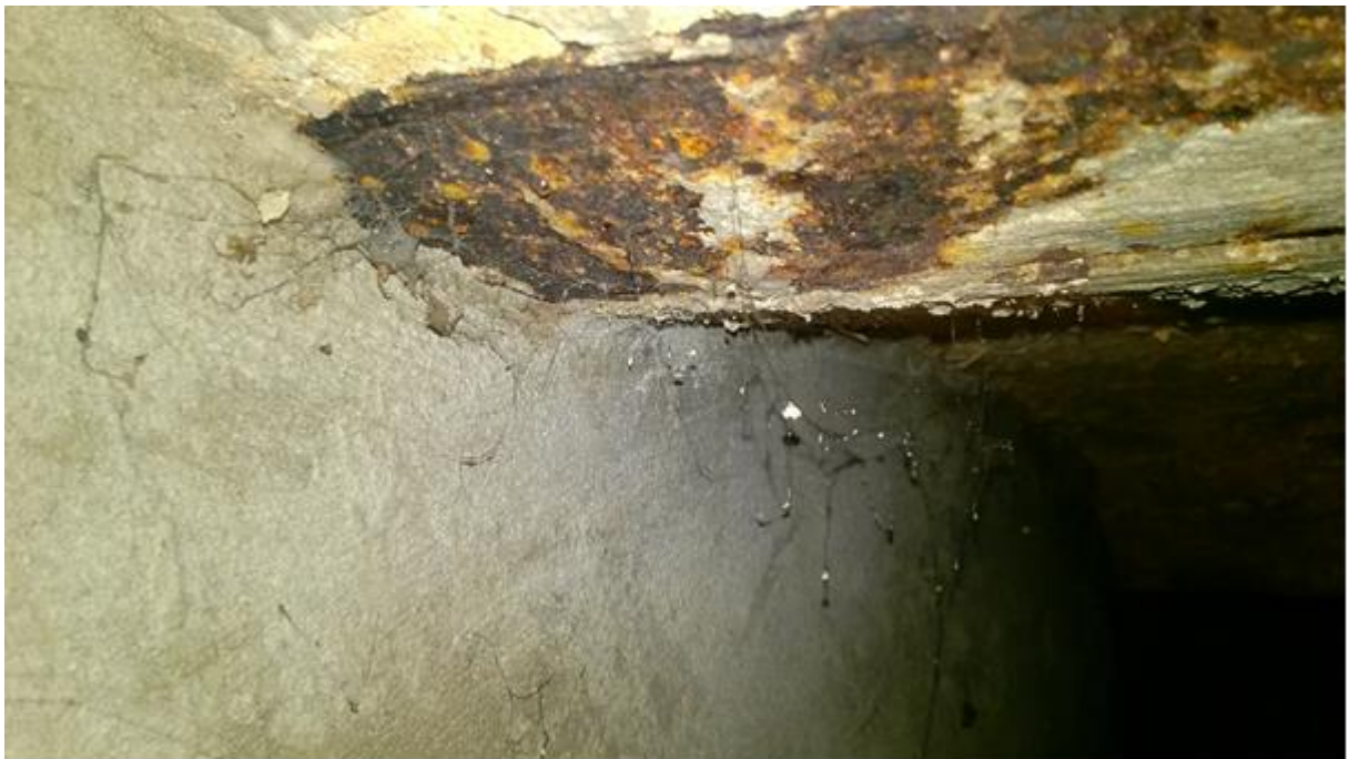
korozja rozwarstwiająca w strefie przypodporowej belki
