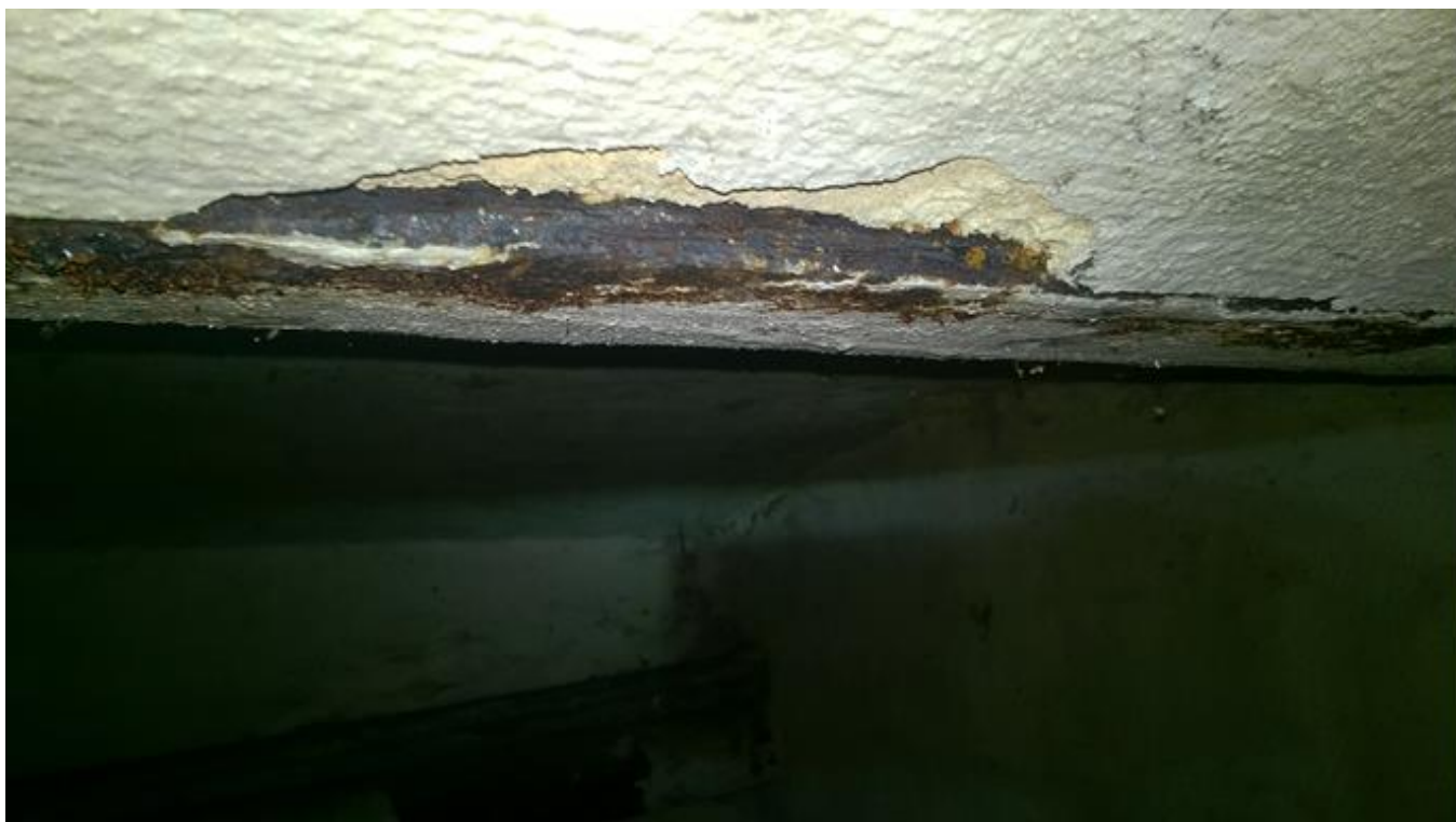
korozja powodująca rozwarstwienie dolnych pól belek stropowych -belka w lewej części piwnicy
