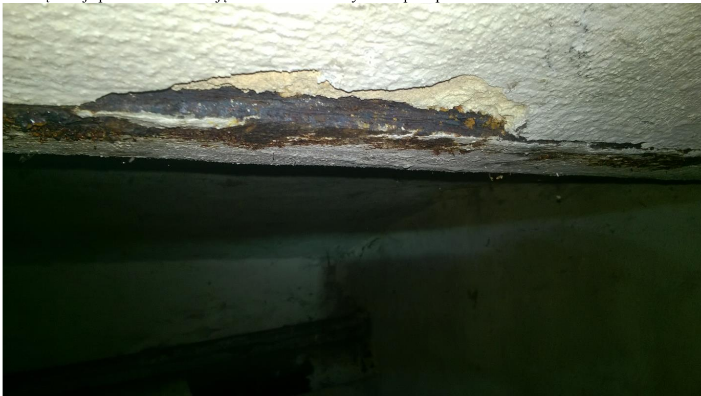
fot. nr 1 korozja powodująca rozwarstwienie dolnych pól belek stropowych -belka w lewej części piwnicy
