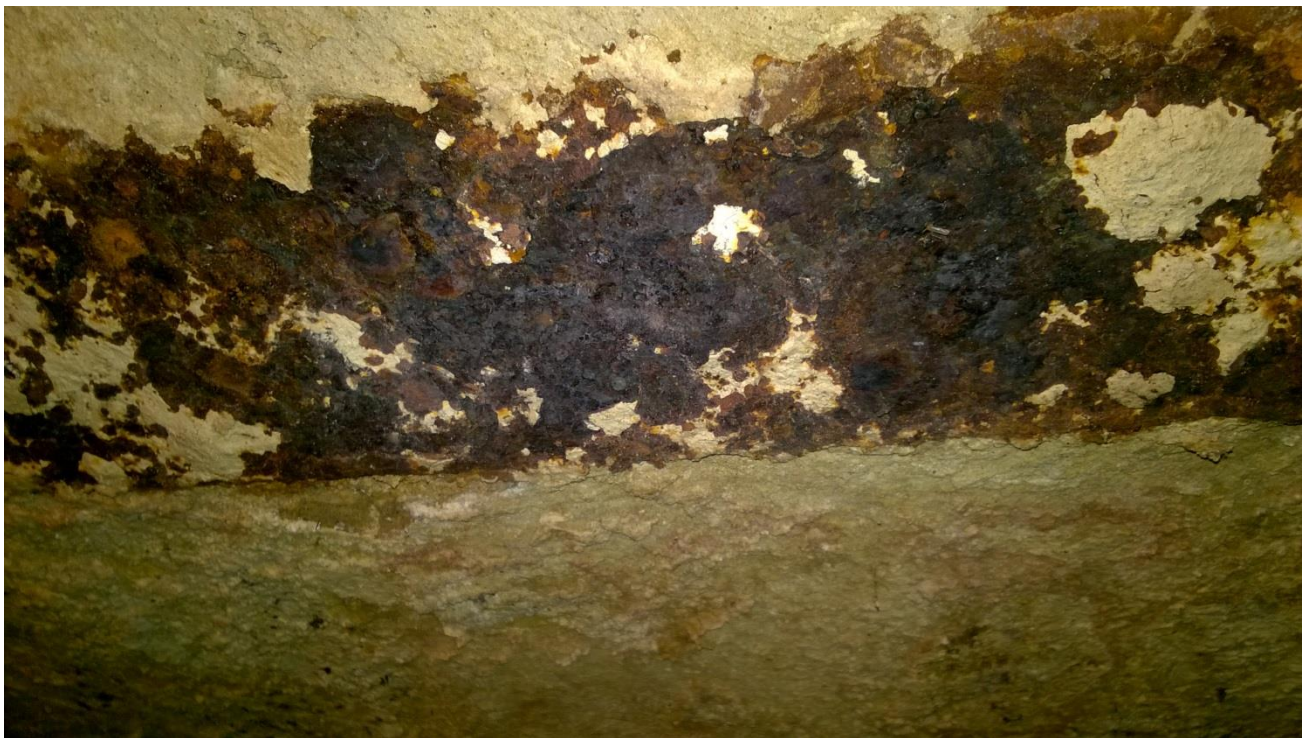
fot. nr 1 rozwarstwiająca korozja dolnej półki belki stropowej piwnica po lewej stronie korytarza piwnicznego
