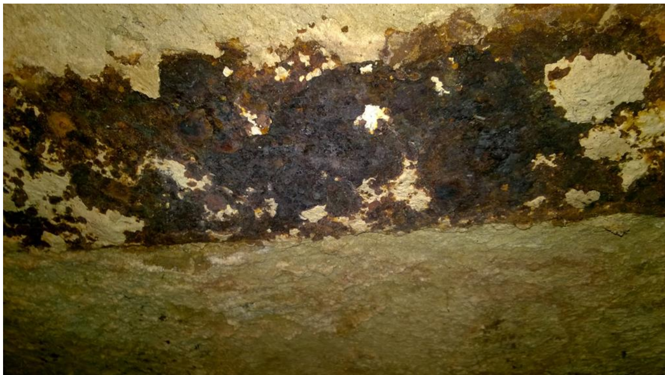
rozwarstwiająca korozja dolnej półki belki stropowej piwnica po lewej stronie korytarza piwnicznego
