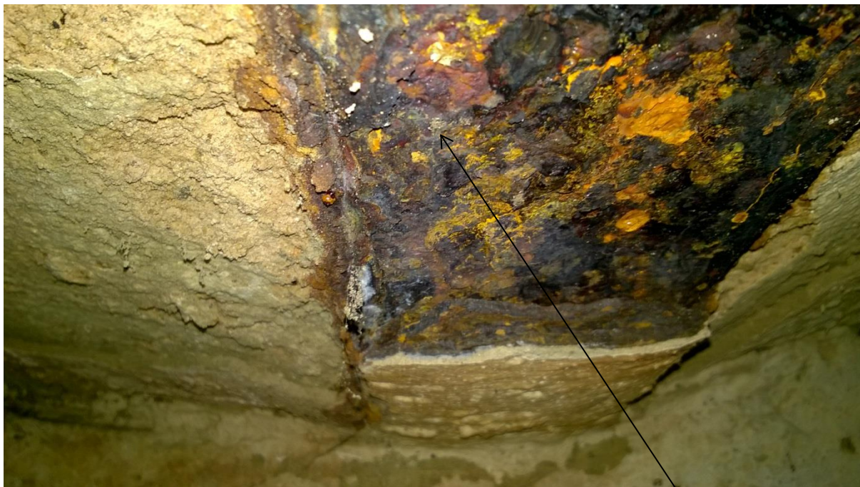
fot 3 silna korozja rozwarstwiająca dolne półki belek strefa przypodporowa
