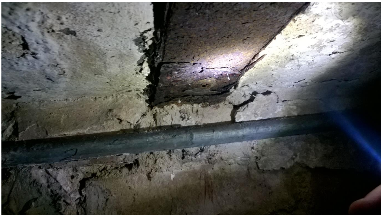
fot. nr 1 rozwarstwiająca korozja dolnej półki belki stropowej
