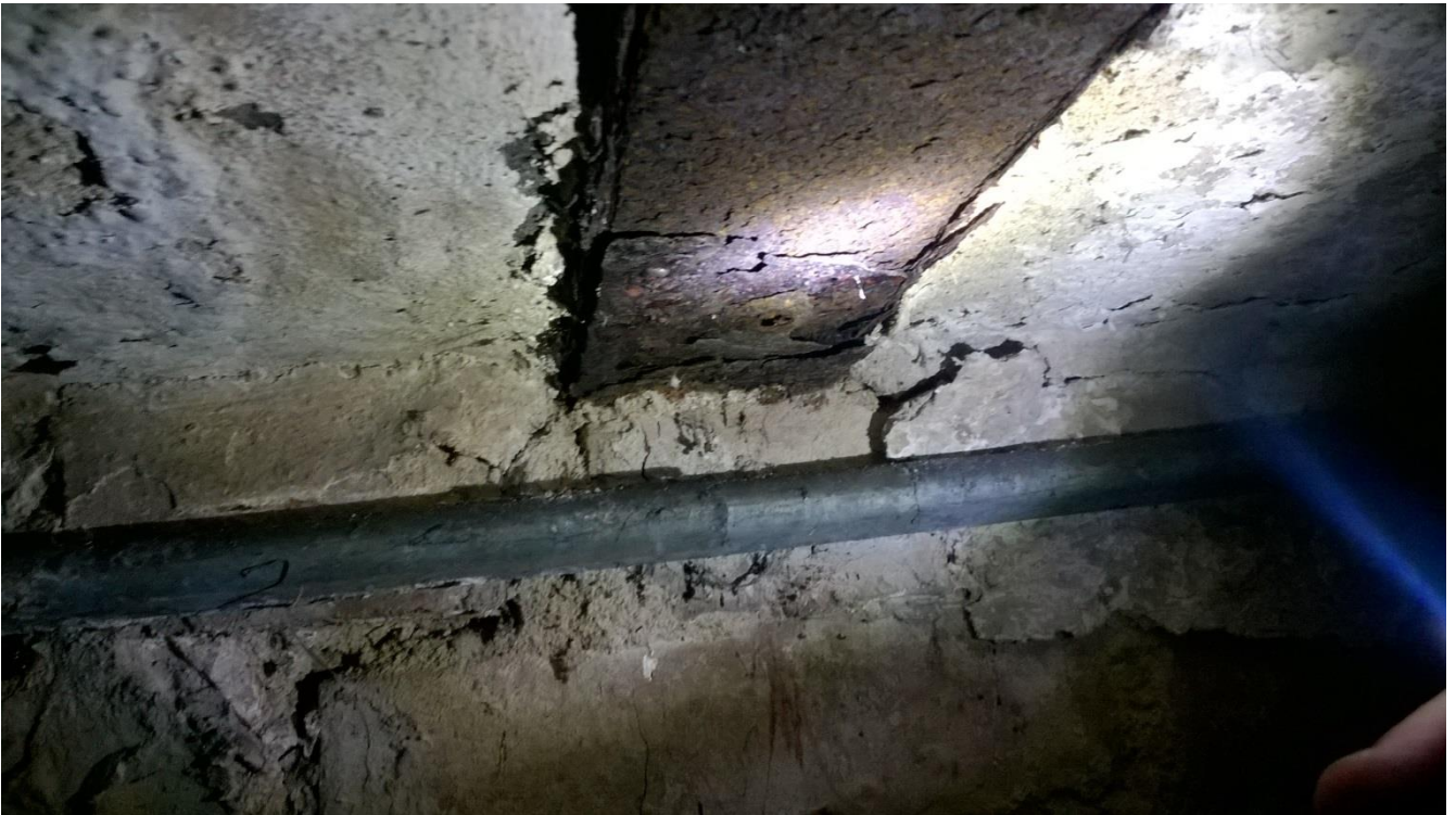
korozja powodująca rozwarstwienie dolnych pól belek stropowych -belka w prawej części piwnicy
