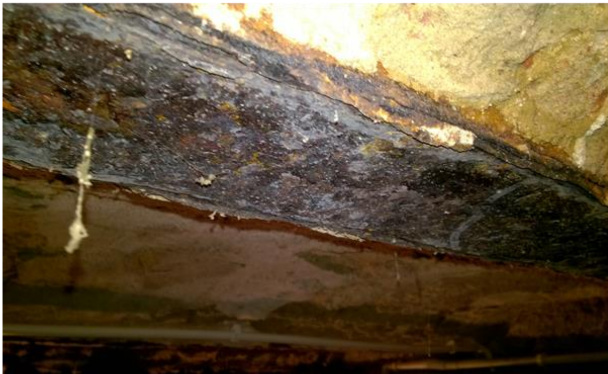
rozwarstwiająca korozja dolnej półki belki stropowej korytarza piwnicznego
