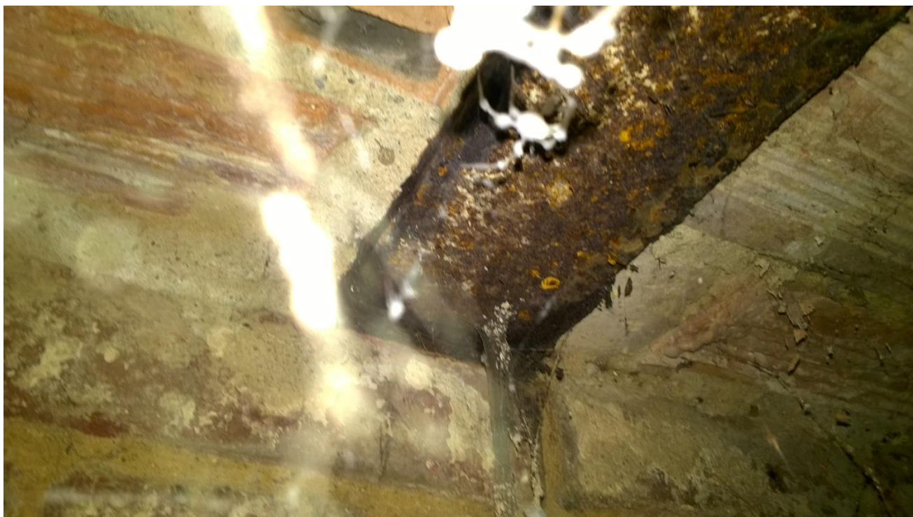
fot. nr 1 rozwarstwiająca korozja dolnej półki belki stropowej w pomieszczeniu piwnicznym po prawej stronie schodów piwnicznych
