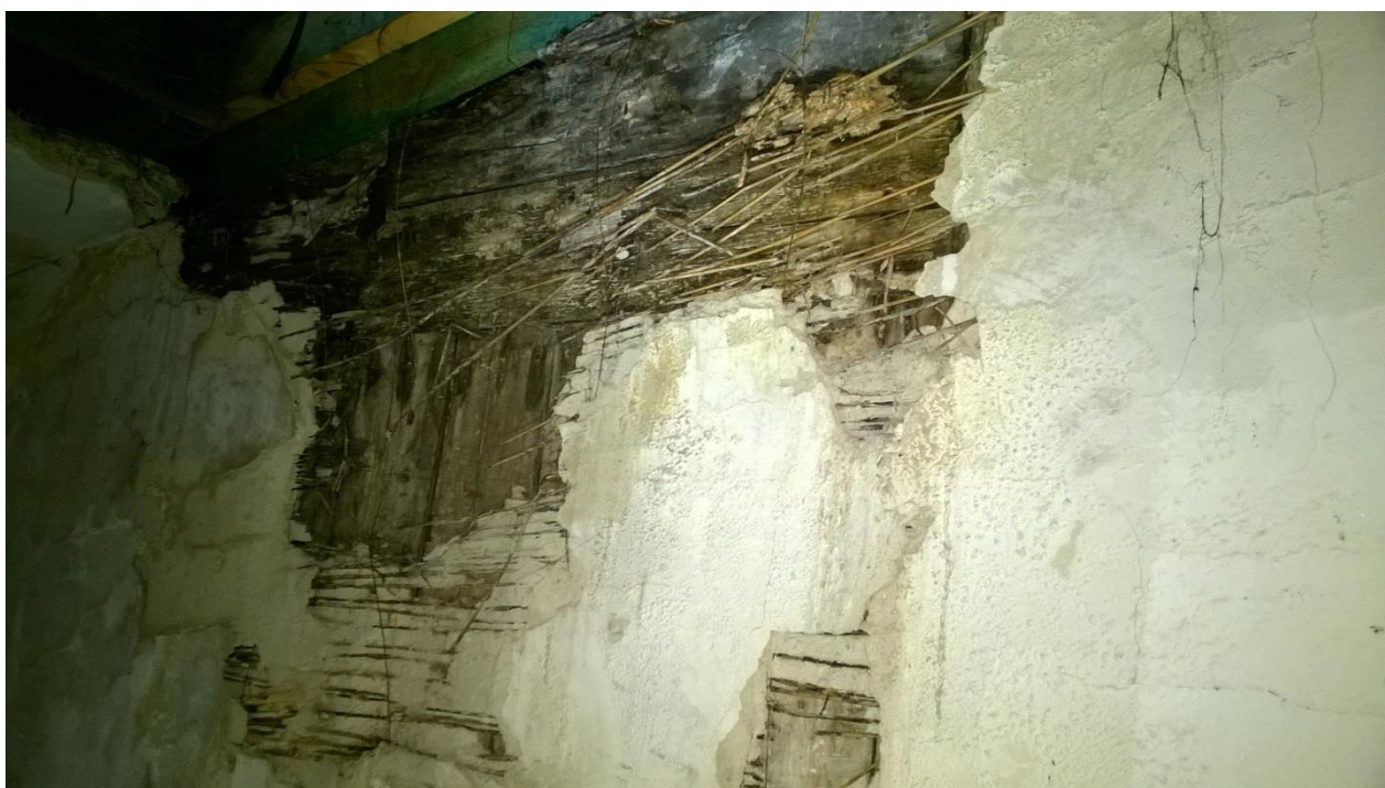
drewniana ścianka oddzielająca pomieszczenie od klatki schodowej
