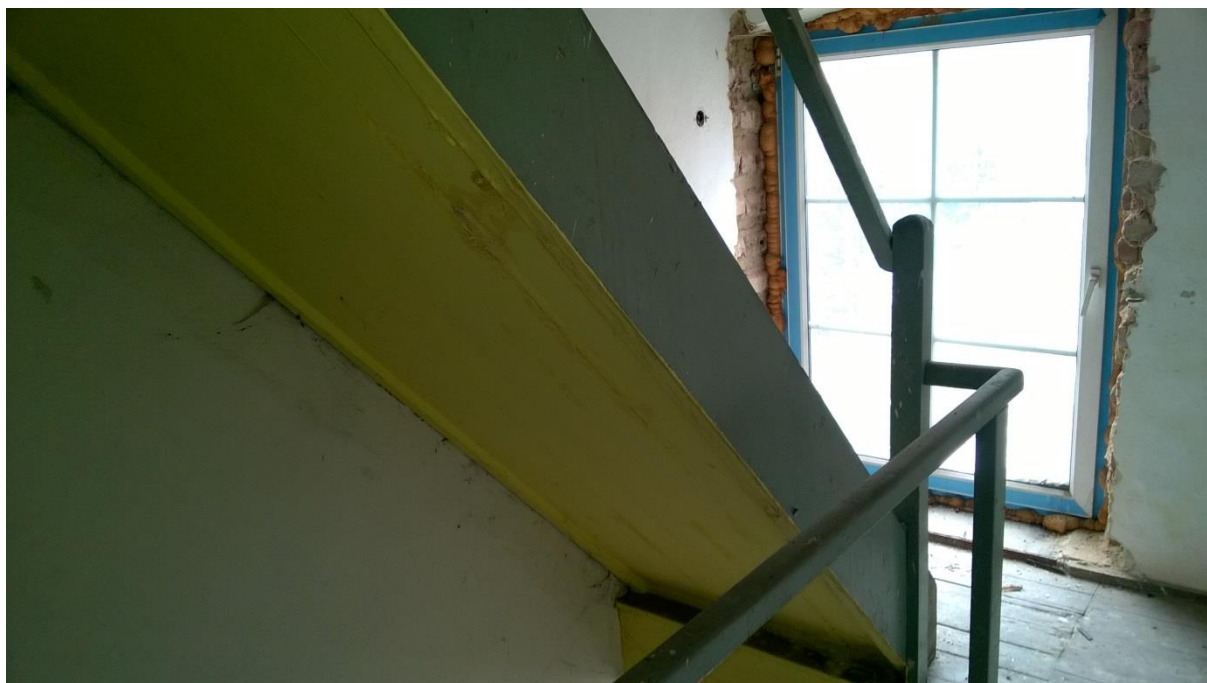
drewniana balustrada schodowa bez tralek lub wypełnienia
