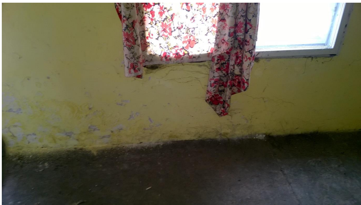
wilgoć i grzyby budowlane na ścianie frontowej przybudówki
