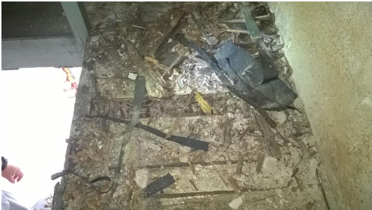
drewniany podest klatki schodowej zniszczony przez penetrację wody opadowej
