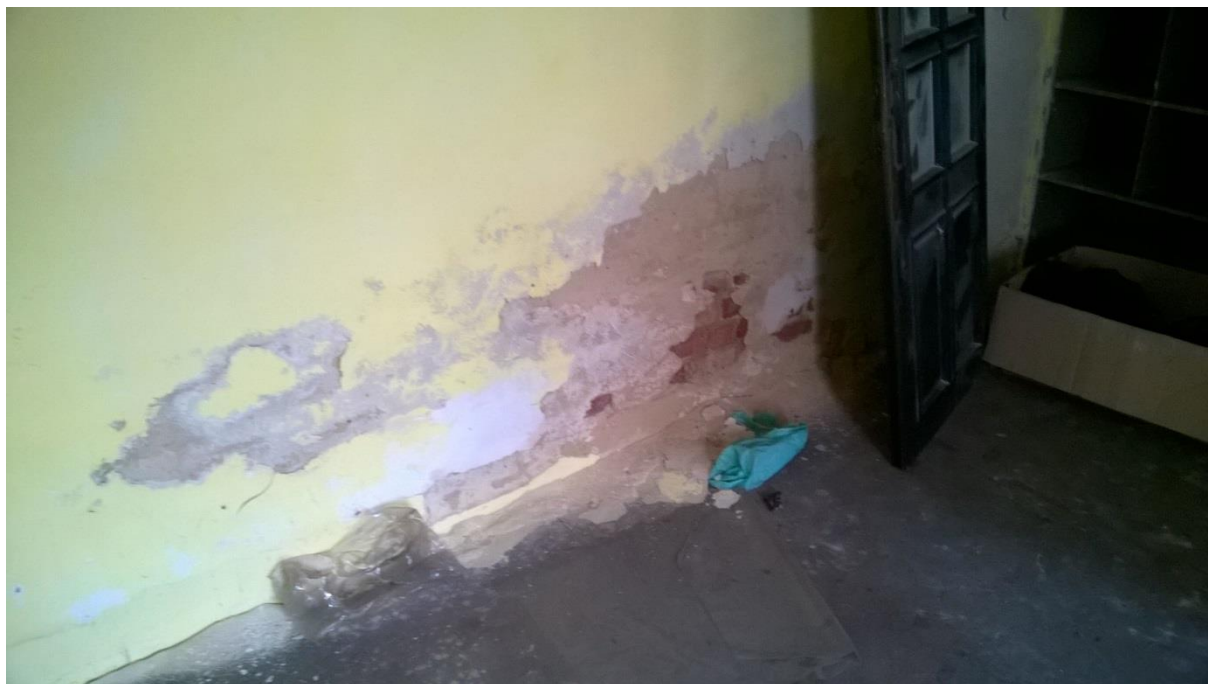
ubytki tynków i wilgoć na ścianie tylnej przybudówki
