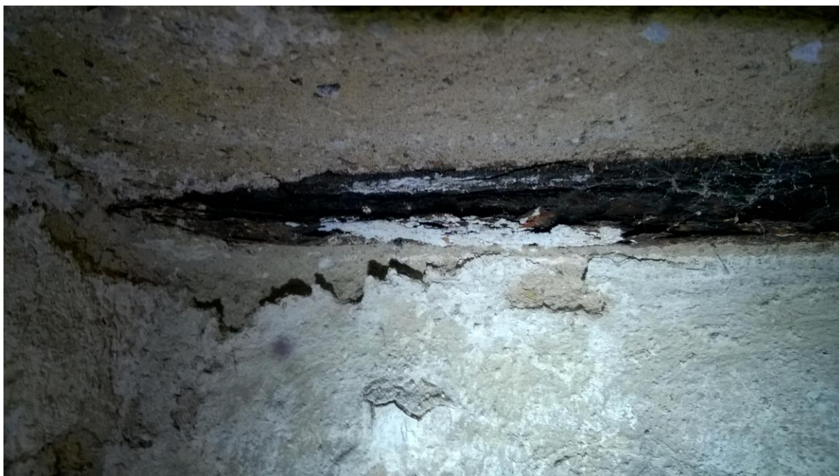
fot. nr 3 skorodowana belka stropowa w pomieszczeniu piwnicznym przy pralni
