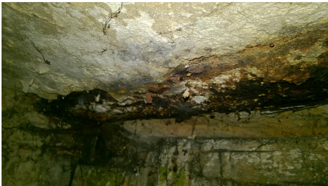
fot. nr 1 rozwarstwiająca korozja dolnej półki belki stropowej w pomieszczeniu po lewej stronie korytarza piwnicznego
