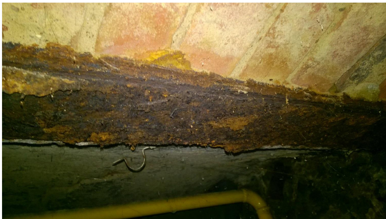
fot. nr 5 rozwarstwiająca korozja dolnej półki belki stropowej w pomieszczeniu nr 1
