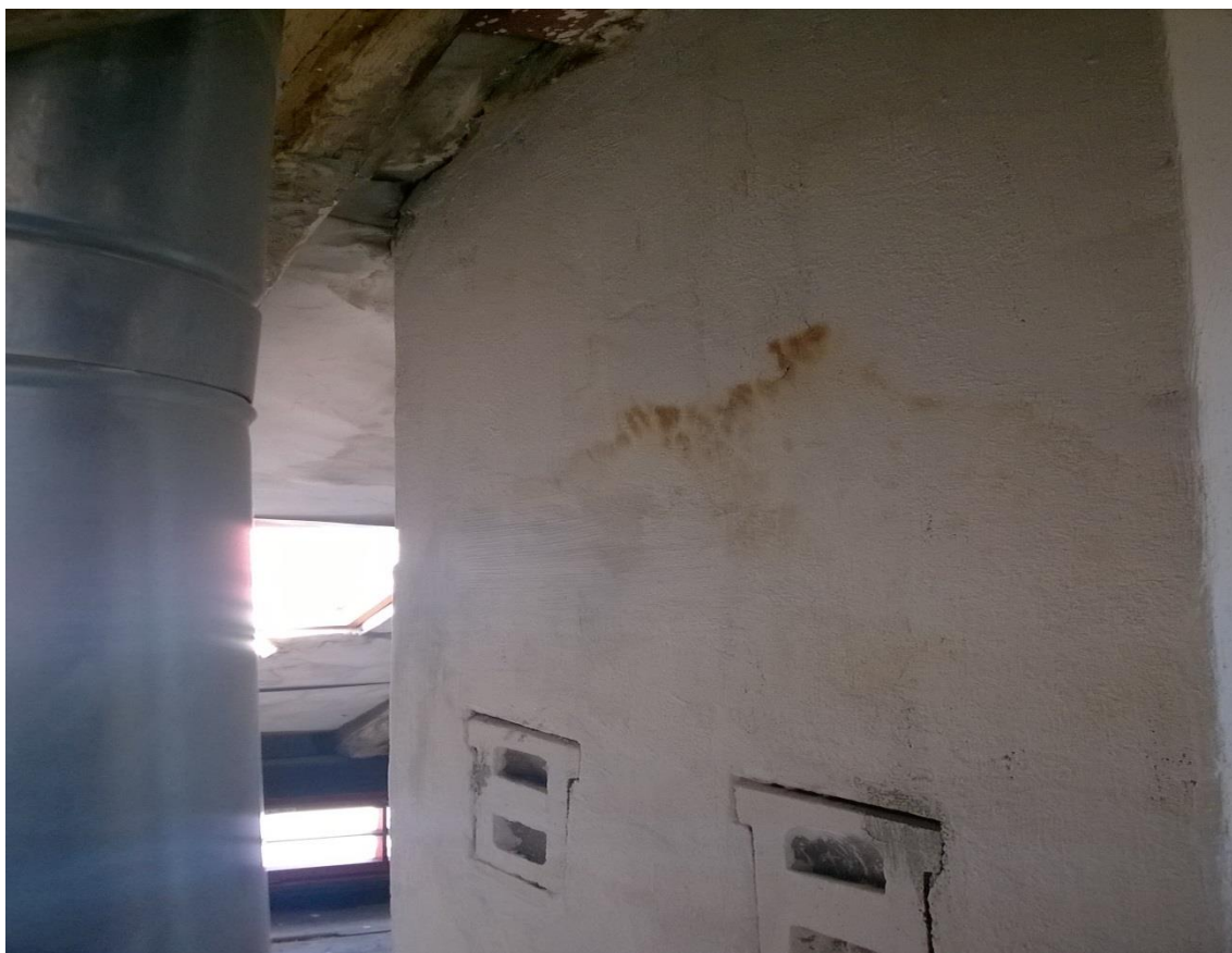
fot. nr 1 niewielkie przebarwienie na tynkach kominowych – komin przy wejściu na strych
