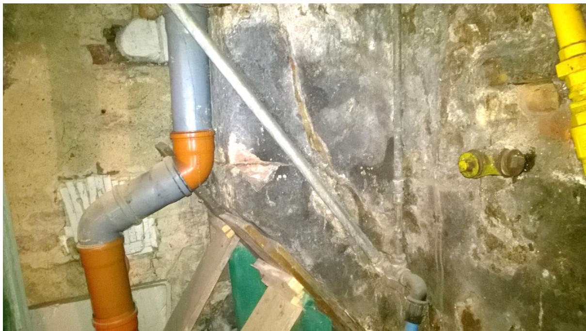
fot. nr 6 znacznie spękany ceramiczny wspornik podporowy w pomieszczeniu nr 1
