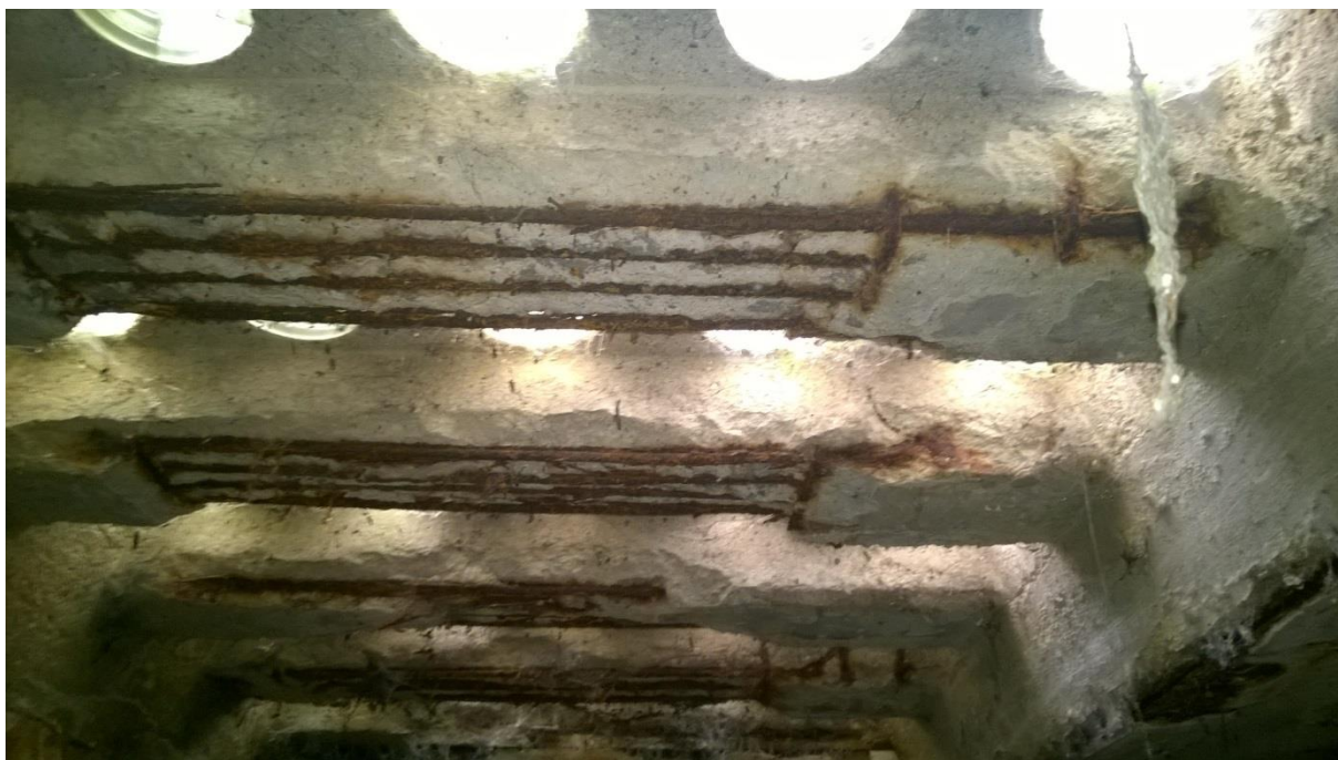
fot. nr 3 zniszczone otulenie zbrojenia żeber płyty stropodachowej piwnicy nr 6
