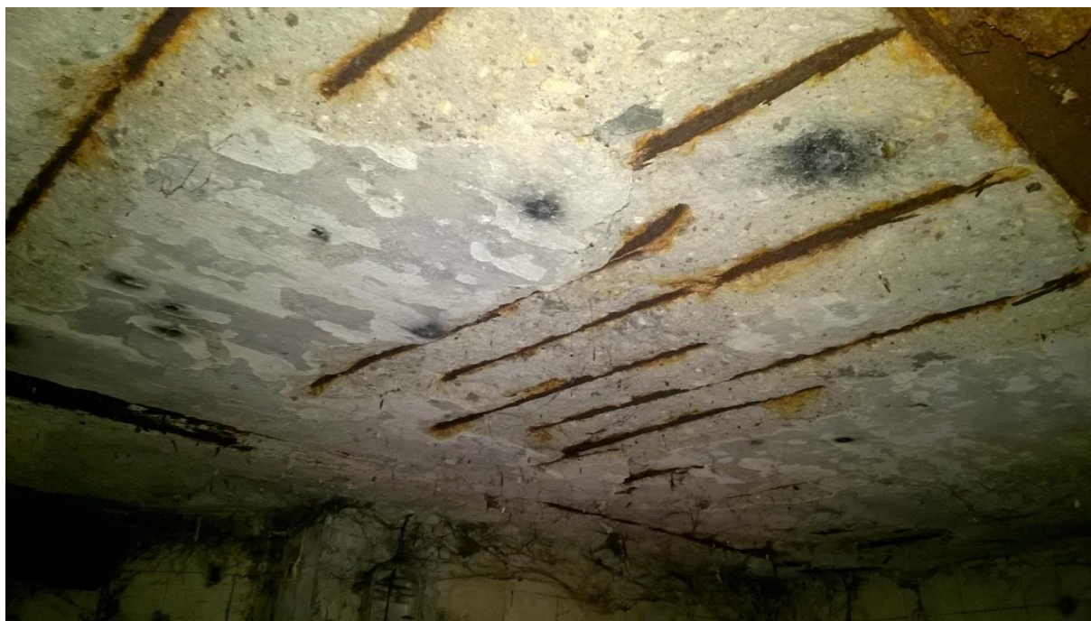
fot. nr 4 skorodowane belki stropowe ubytki otulenia na płycie stropodachowej pomieszczenie piwniczne nr 6
