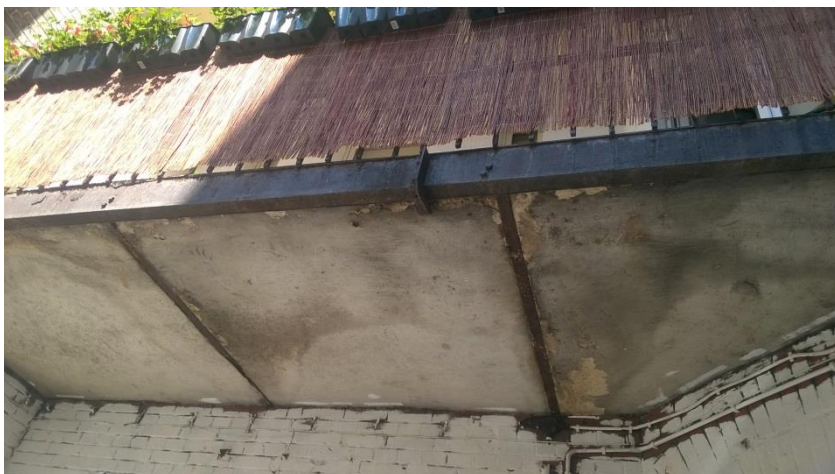
fot. nr 2 stalowe belki płyty balkonowej lokal nr1 z lekką korozją
