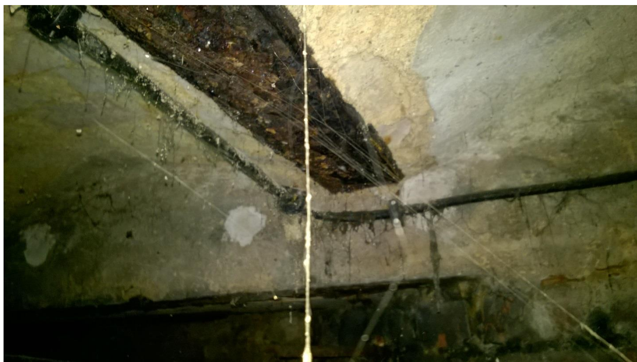
fot. nr 7 skorodowana belka stropowa w pomieszczeniu nr 5
