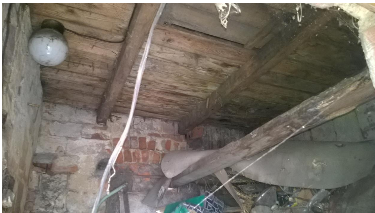
komórka z widocznym stropem belkowym nagim
