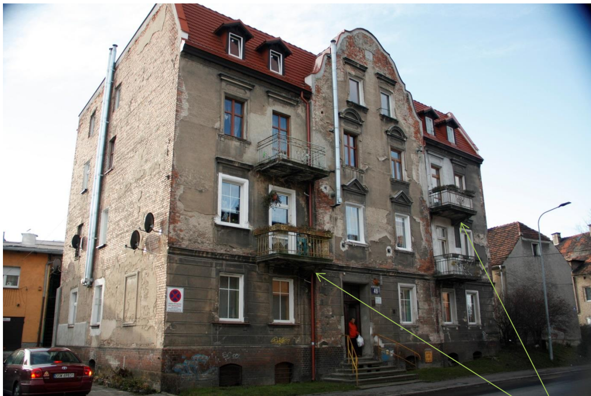
widoczne dwa z ośmiu zachowanych ozdobnych kroksztynów pod płytą balkonową
