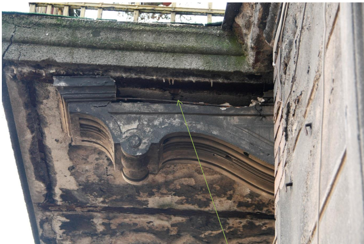
ozdobny kroksztyn ze znacznymi ubytkami
