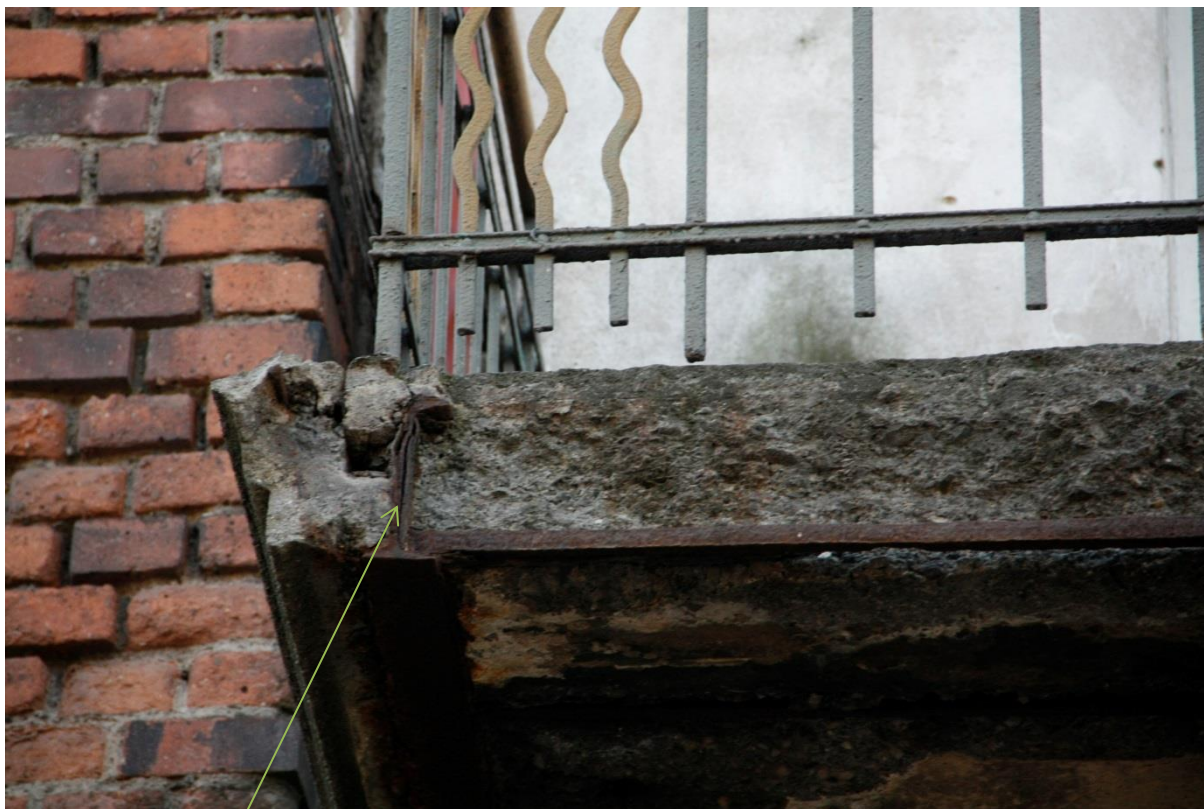
skorodowane i rozwarstwione środniki belek stalowych
