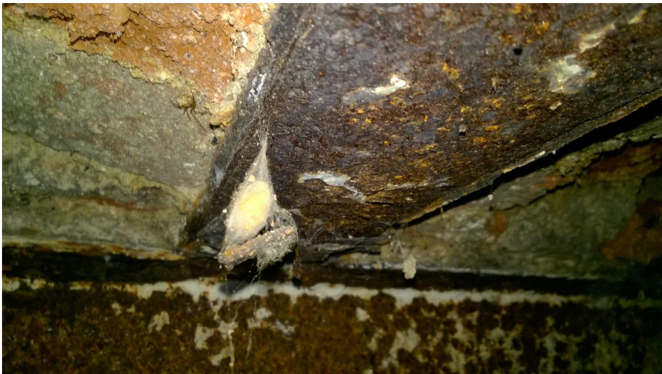
fot. nr 1 rozwarstwiająca korozja dolnej półki belki stropowej w pomieszczeniu piwnicznym nr 8
