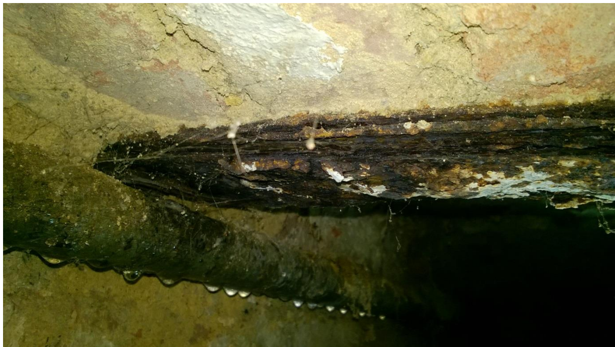
fot. nr 3 widoczne uszkodzenie belki w pomieszczeniu piwnicznym nr 5
