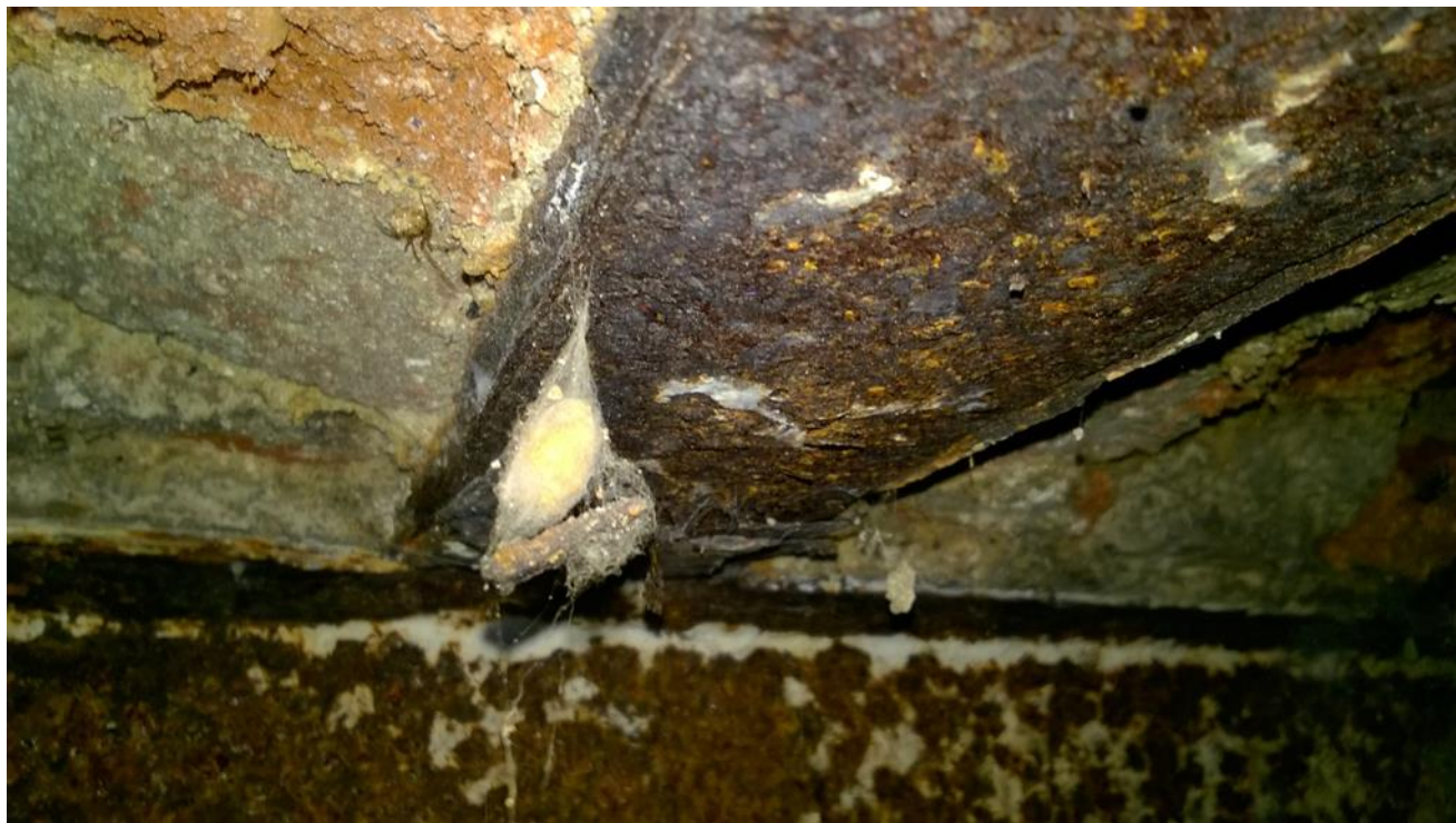
rozwarstwiająca korozja dolnej półki belki stropowej w pomieszczeniu piwnicznym nr 8
