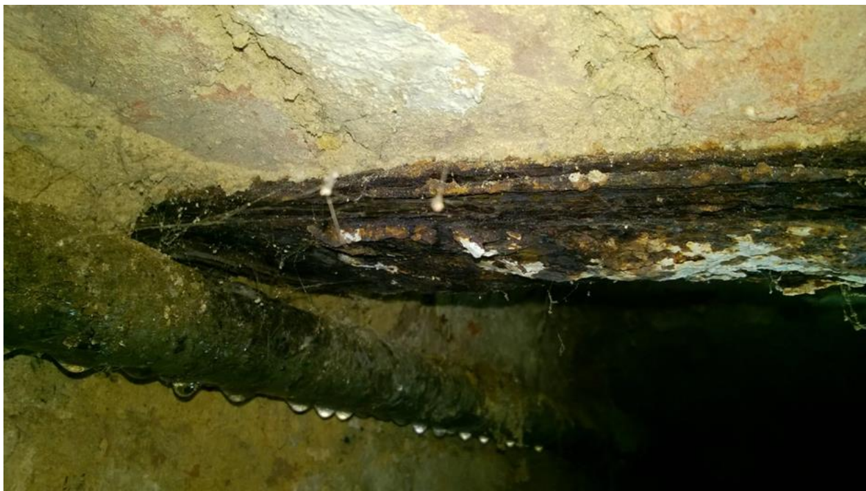
widoczne uszkodzenie belki w pomieszczeniu piwnicznym nr 5
