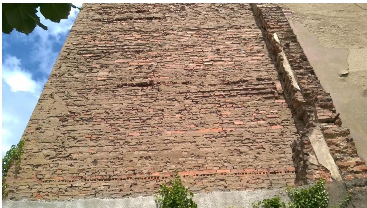
fot. 2 widoczny brak tynków elewacji na ścianie tylnej przybudówki oraz cegły dziurawki
