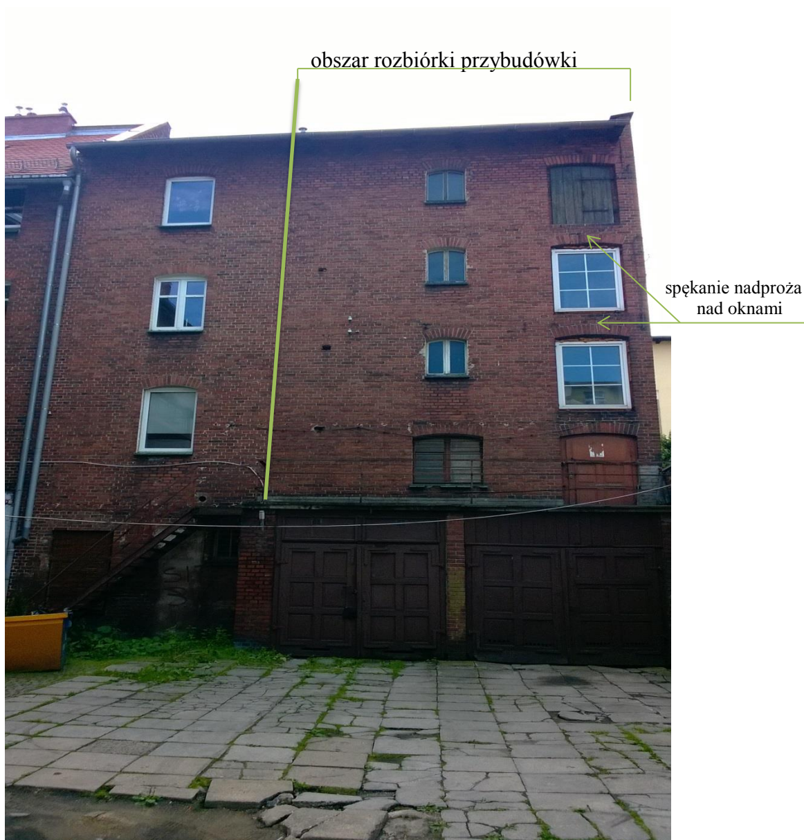
fot. 1 widoczne spękania nadproży okiennych
