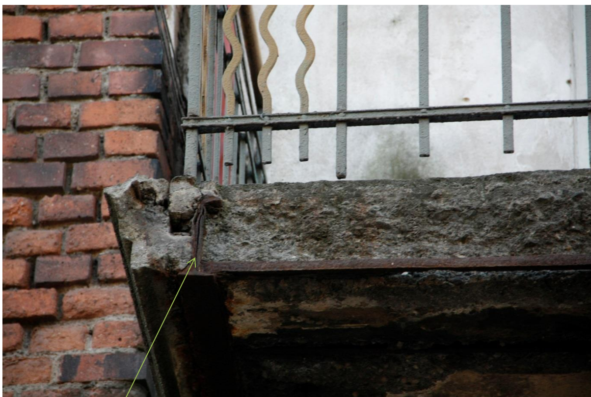
skorodowane i rozwarstwione środki belek stalowych
