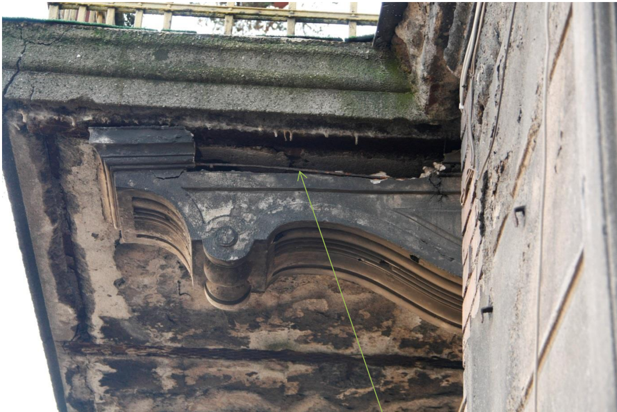
ozdobny kroksztyn ze znacznymi ubytkami
