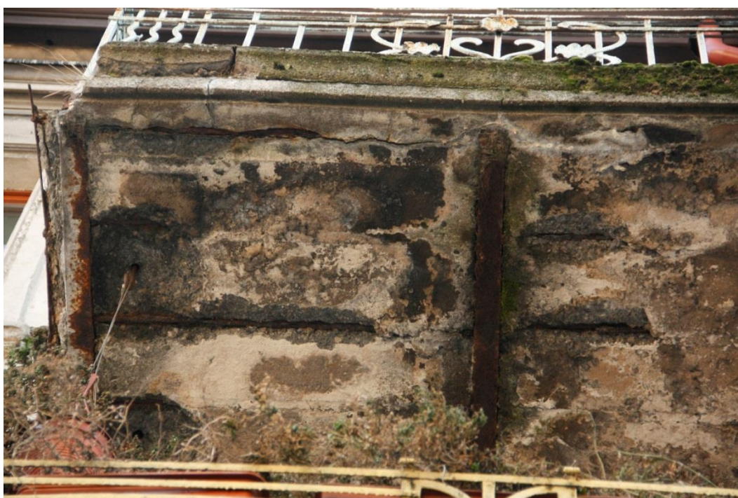
spękana płyta balkonowa, skorodowane zbrojenie i belki stalowe balkonów
