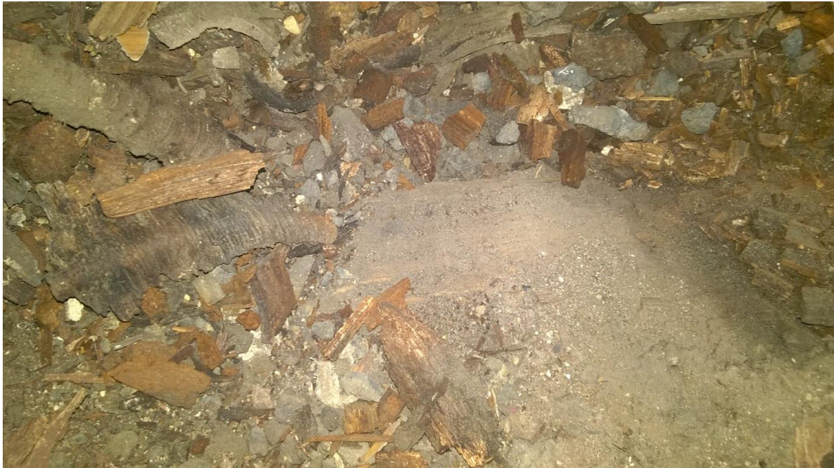
zmurszała belka stropowa na skutek długotrwałej penetracji wody opadowej
