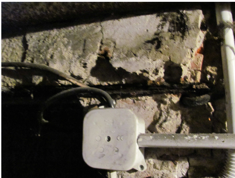
Uszkodzone elementy ściany , niezabezpieczone przewody elektryczne
