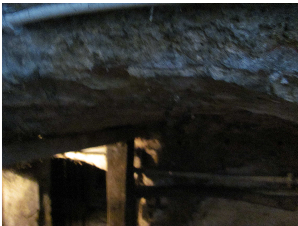
Widok stropu łukowego ceglanego w korytarzu piwnic - widoczne stęplowanie .
