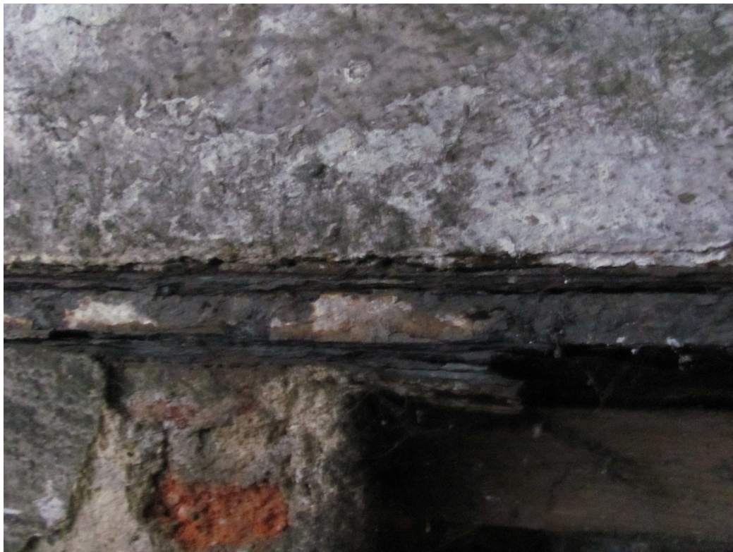
Szczegół skorodowanej stopki dwuteownika. – elementy konstrukcyjne do wymiany- strop do przebudowy
