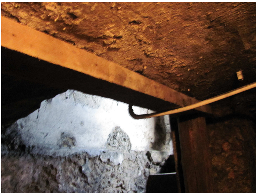
Ubytki w tynku na ścianach i stropie
