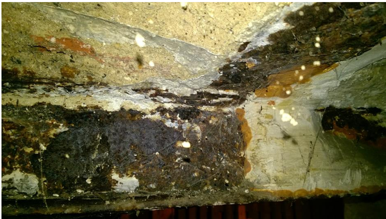
widoczne uszkodzenie belki w pomieszczeniu piwnicznym nr 5 nad nadprożem okiennym
