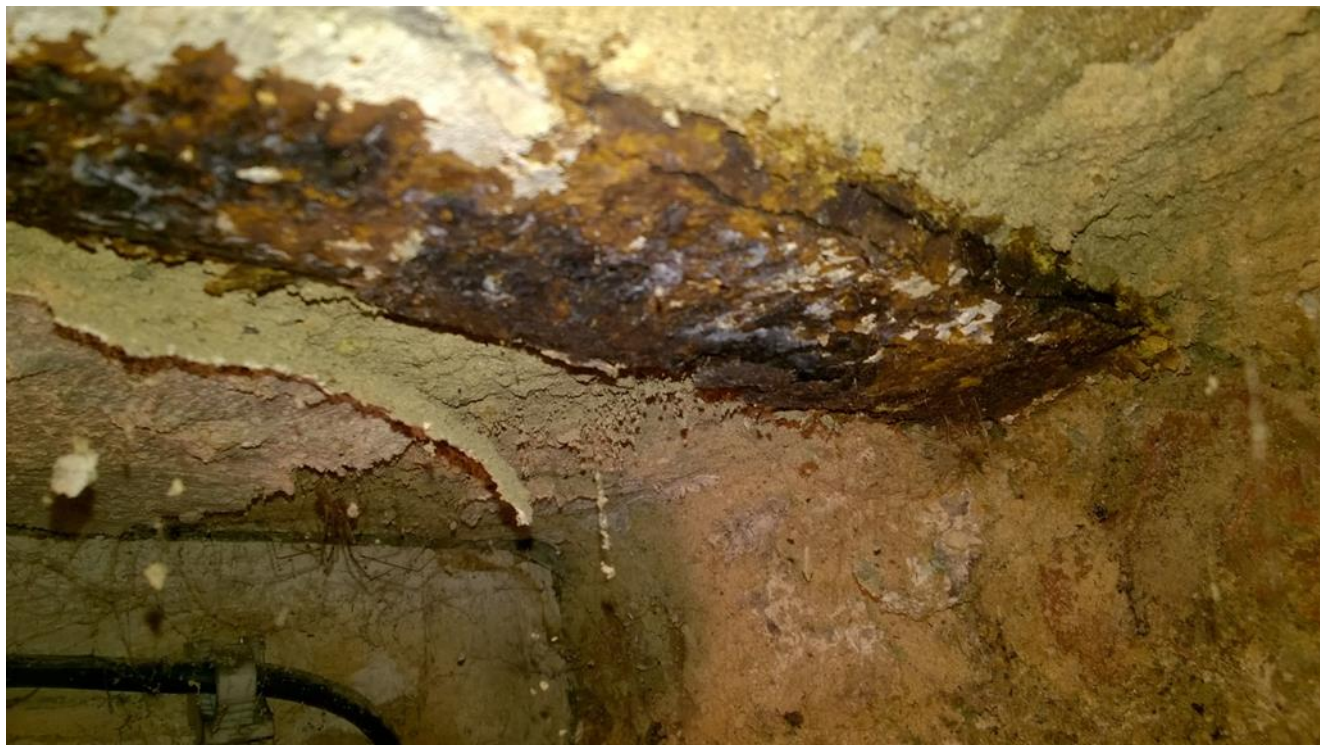
skorodowana belka w pomieszczeniu nr 4
