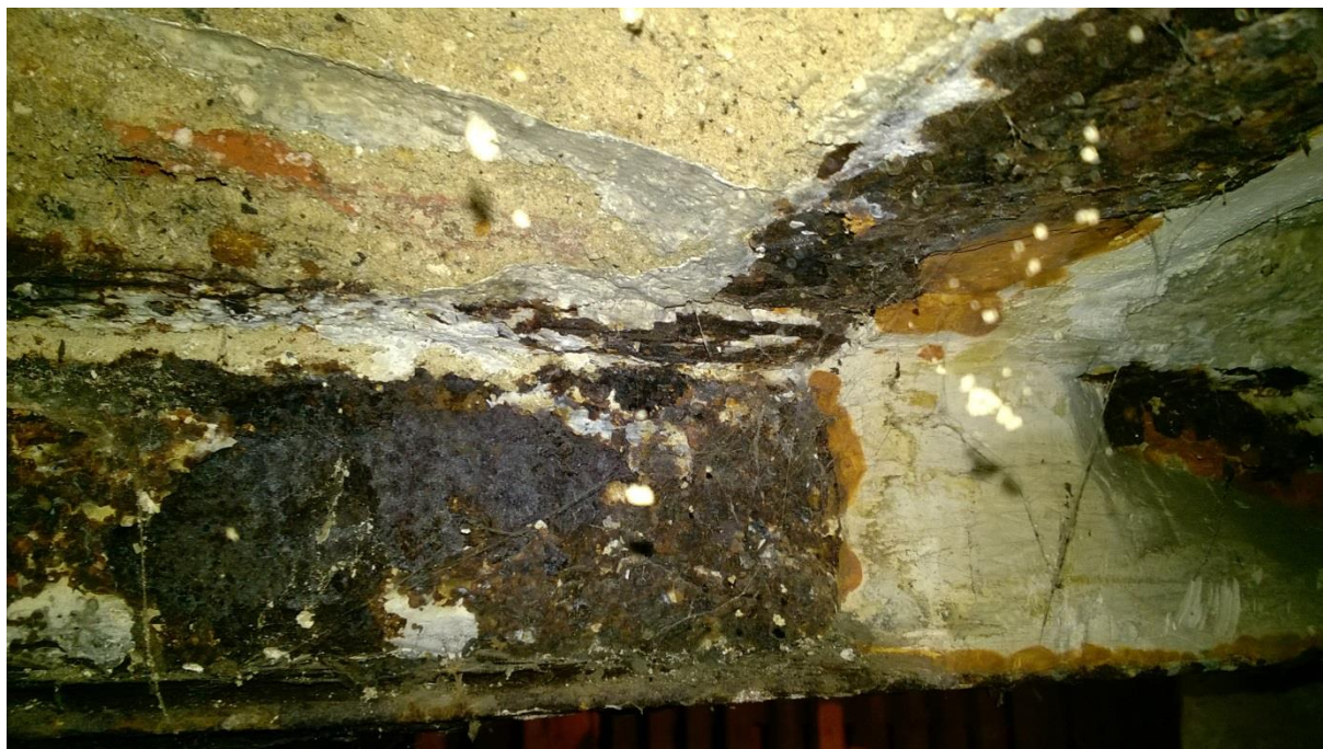
fot. nr 3 widoczne uszkodzenie belki w pomieszczeniu piwnicznym nr 5 nad nadprożem okiennym
