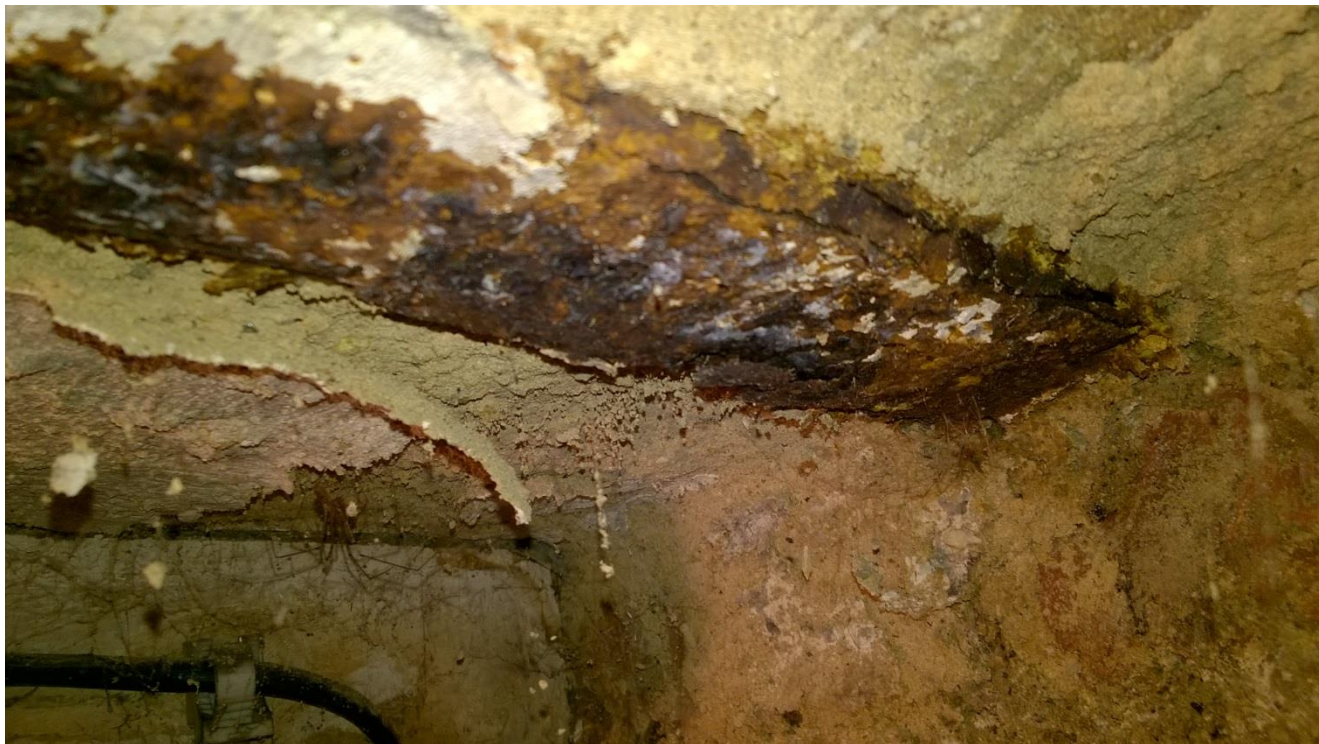
fot. nr 1 skorodowana belka w pomieszczeniu nr 4
