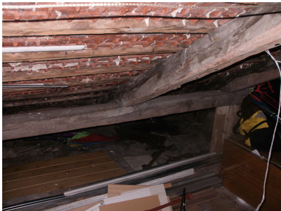
Zdjęcie nr 7 – słupki S 2, belka B1, płatew PŁ 4, krokwie K
