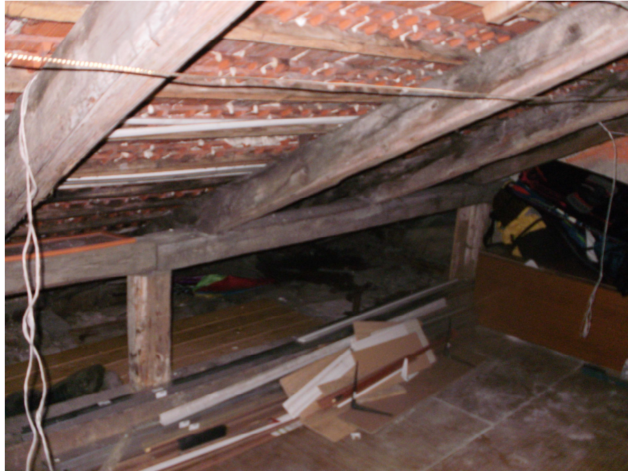
Zdjęcie nr 6 – słupki S 2, belka B1, płatew PŁ 4, krokwie K
