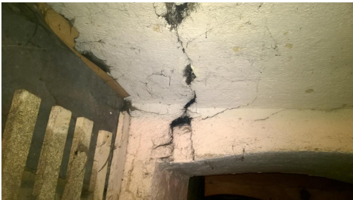
spękanie ceramicznego łuku stropu odcinkowego
