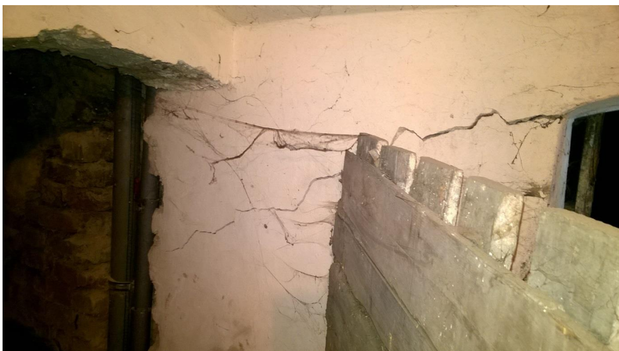
spękanie ceramicznego łuku stropu odcinkowego
