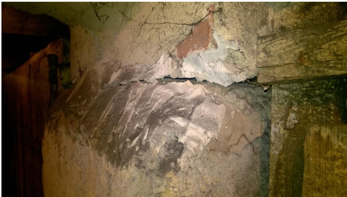
pęknięcie ściany z przemieszczeniem przy nadprożu łukowym
