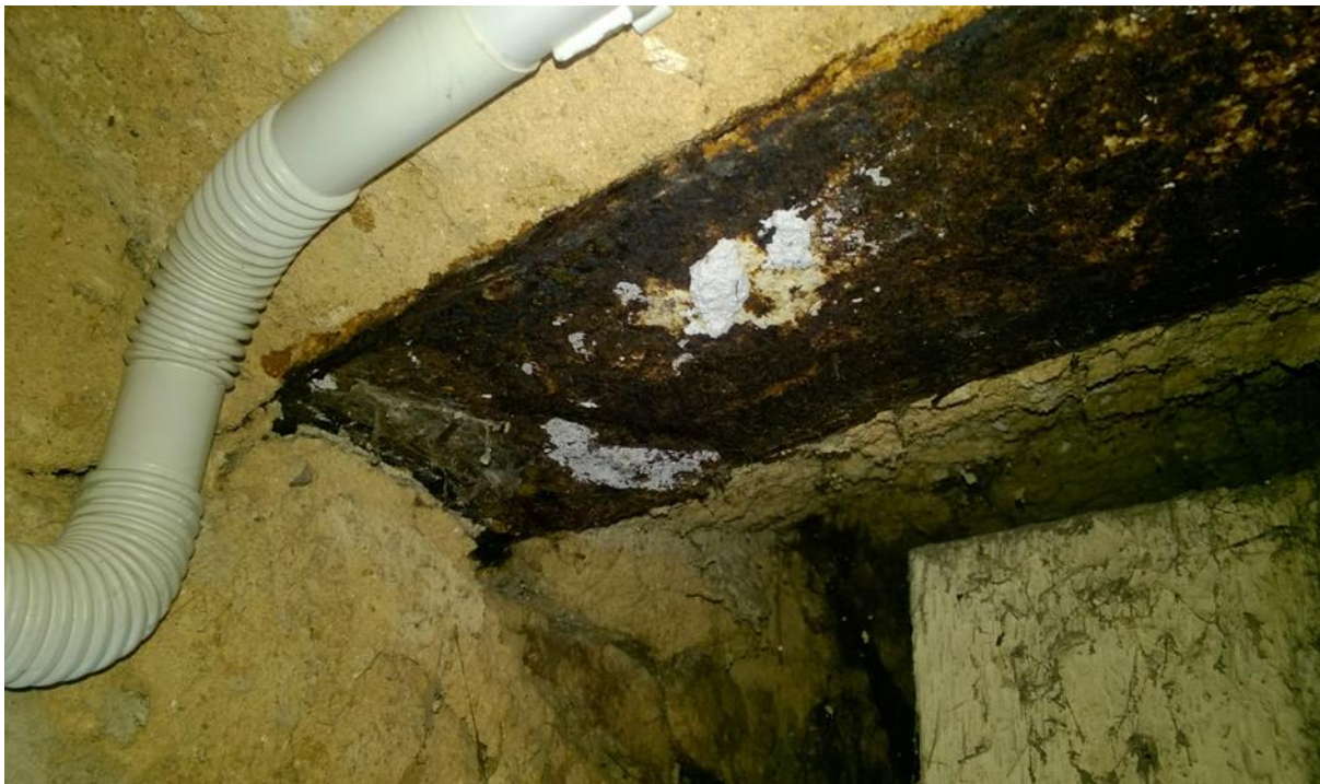
rozwarstwiająca korozja dolnej półki belki stropowej w pomieszczeniu piwnicznym nr 9
