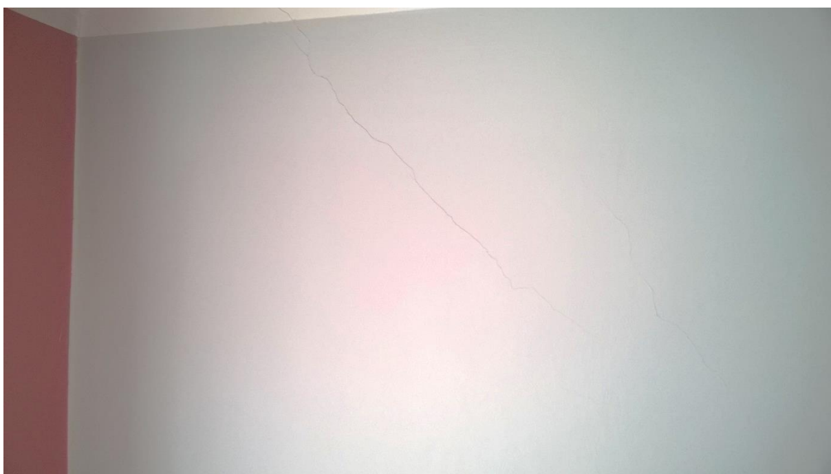
spękania ściany nośnej w pokoju mieszkania nr 2
