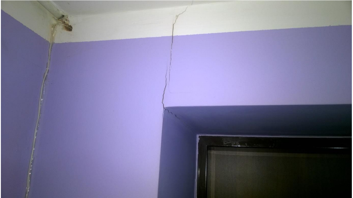
spękania nadproża drzwiowego- drzwi wejściowe do mieszkania nr 2
