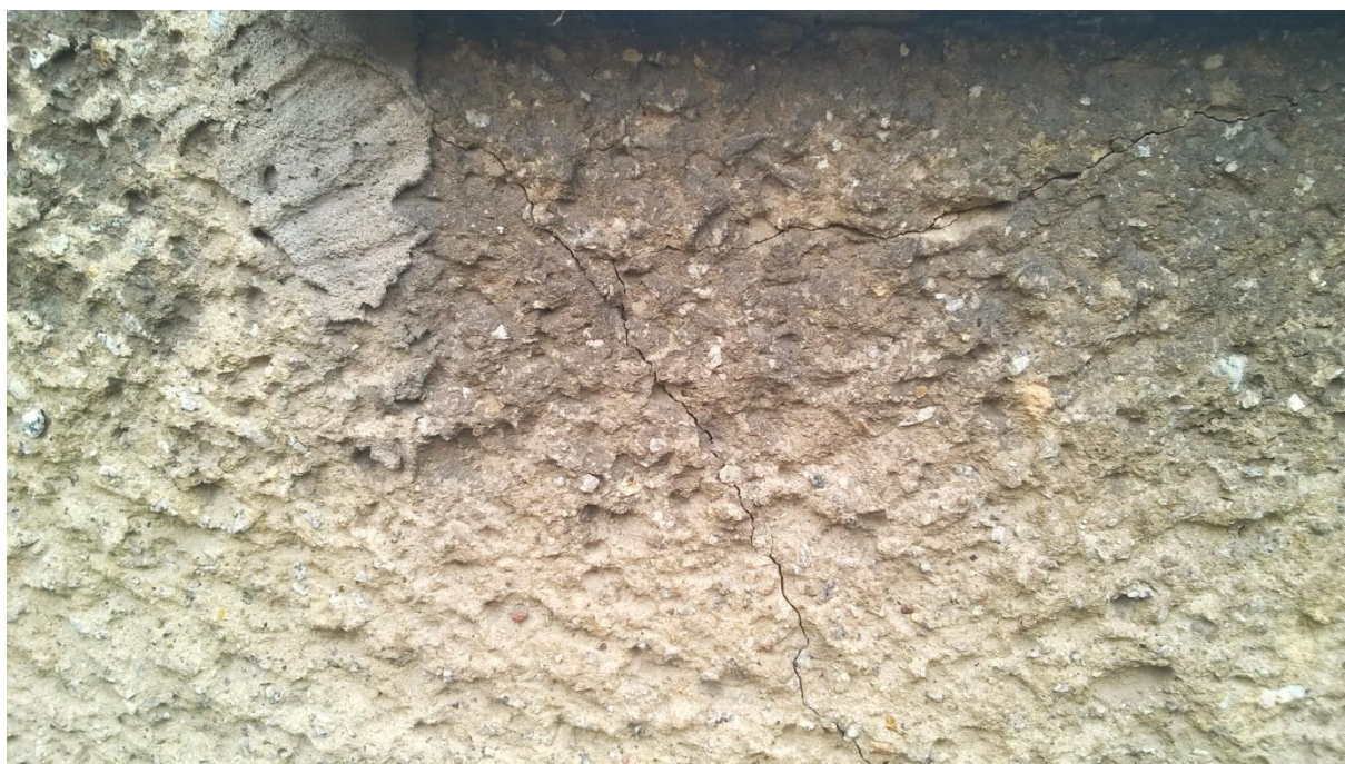
spękanie pod oknem parteru ściany szczytowej lewej
