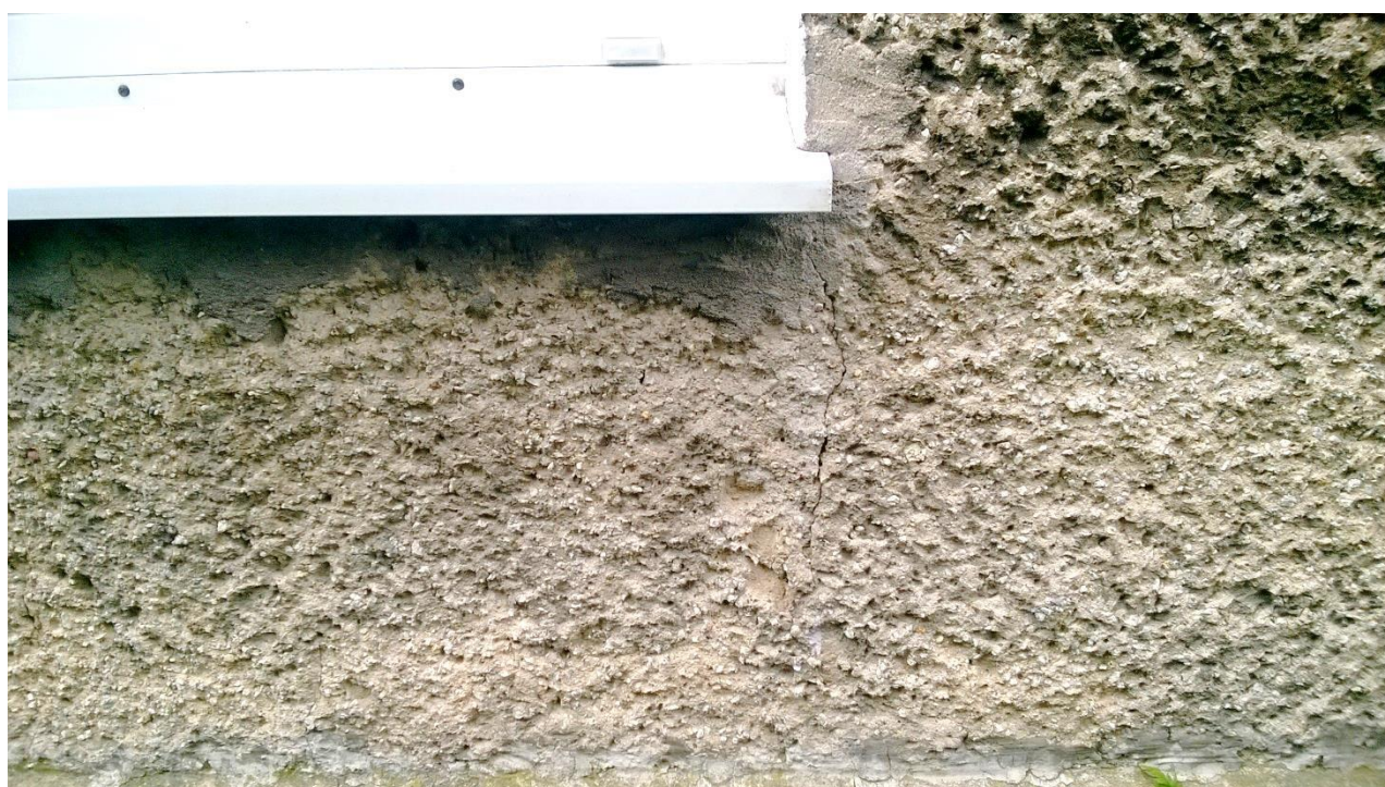
spękanie pod oknem parteru ściany szczytowej lewej
