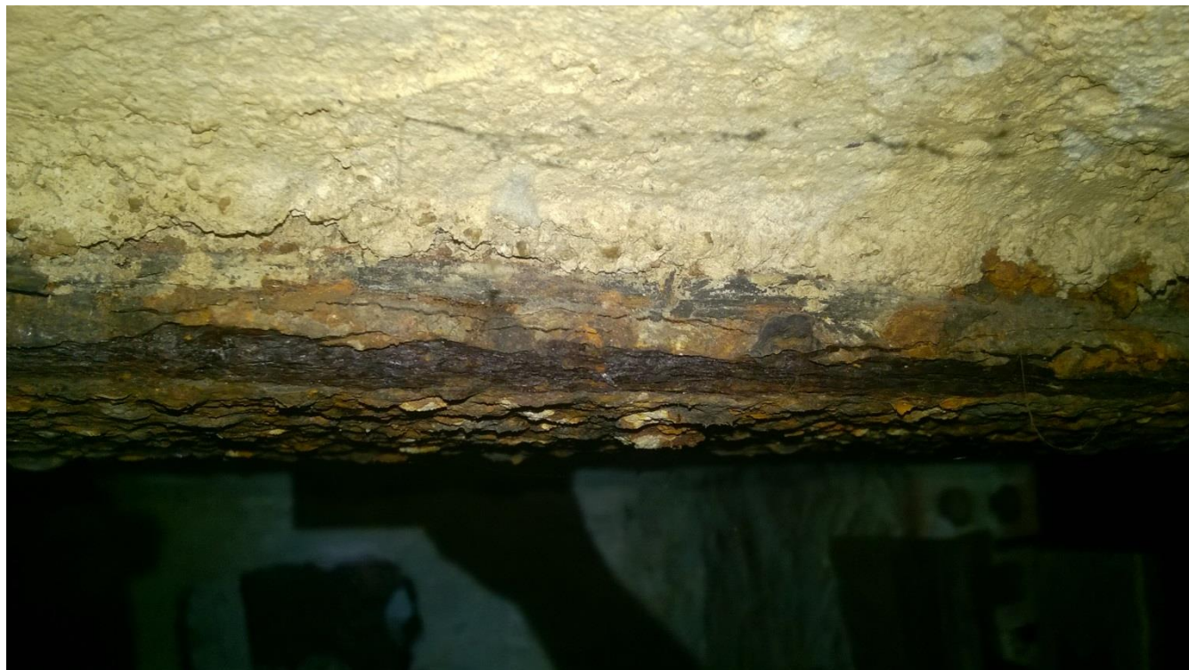
rozwarstwiająca korozja dolnej półki belki stropowej w piwnicy pod przybudówką
