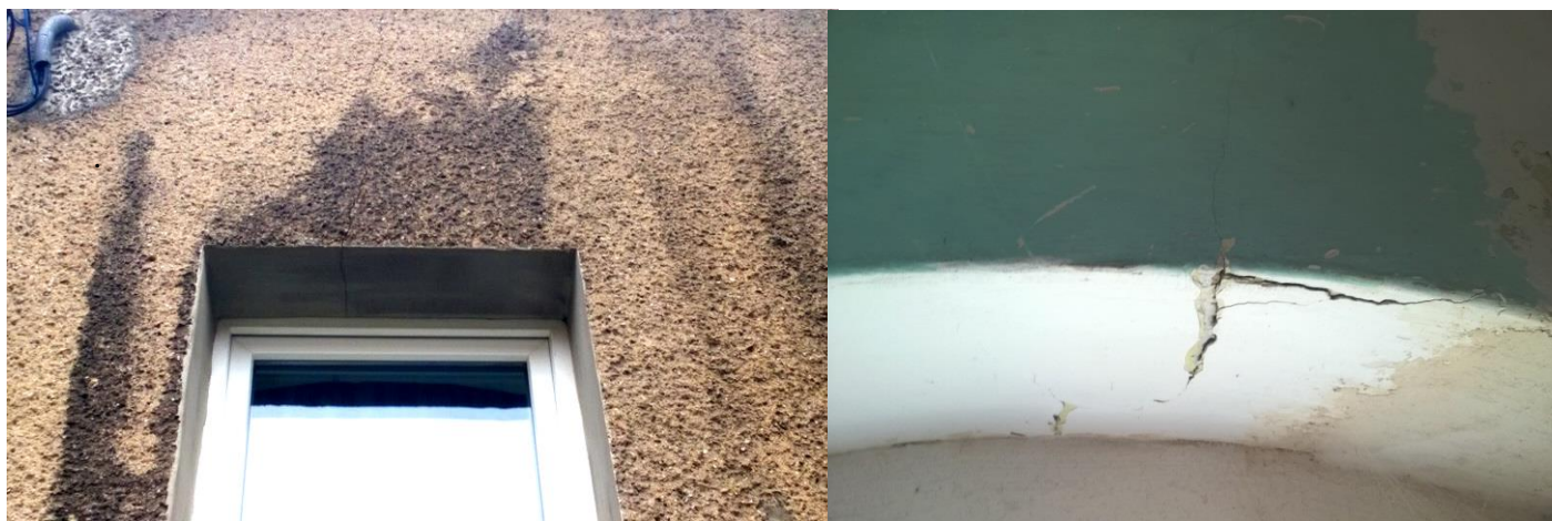
spękanie nadproże i ściana podłużna frontowa
