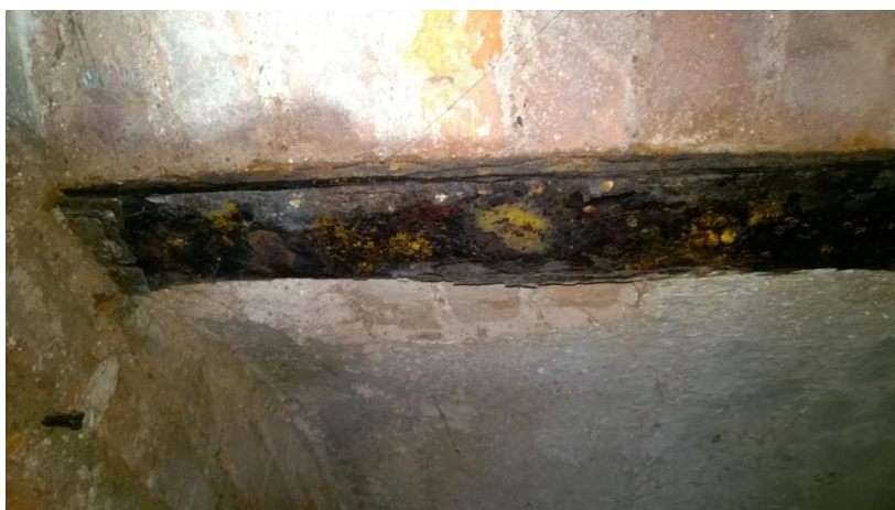
fot. nr 2 korozja ogólna belki stropowej- belka w kotłowni
