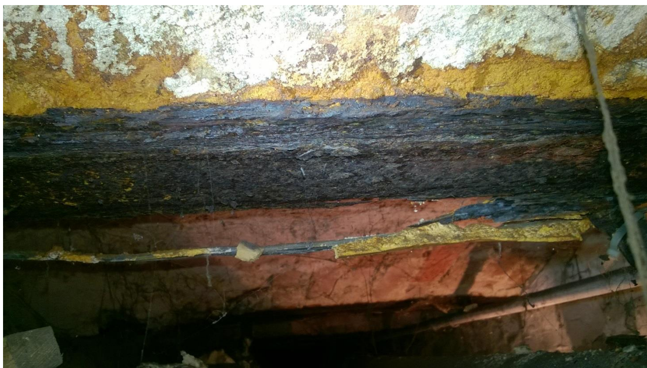
fot. nr 1 korozja powodująca rozwarstwienie dolnych pólek belek stropowych -belka w lewej części piwnicy – belki o dużej rozpiętości 710cm i nietypowym przekroju I280
