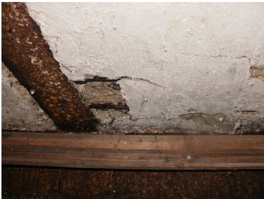
Zdjęcie nr 26 – widoczne zbrojenie stropu nad pom. nr 0030
