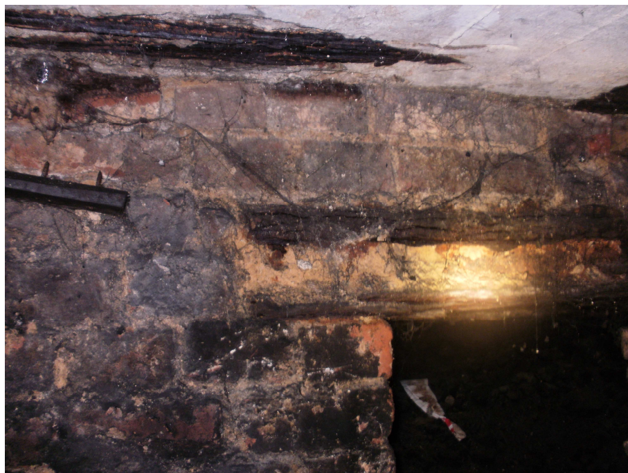
Zdjęcie nr 10 – nadproże nr 5 i widoczne skorodowane pręty zbrojeniowe
