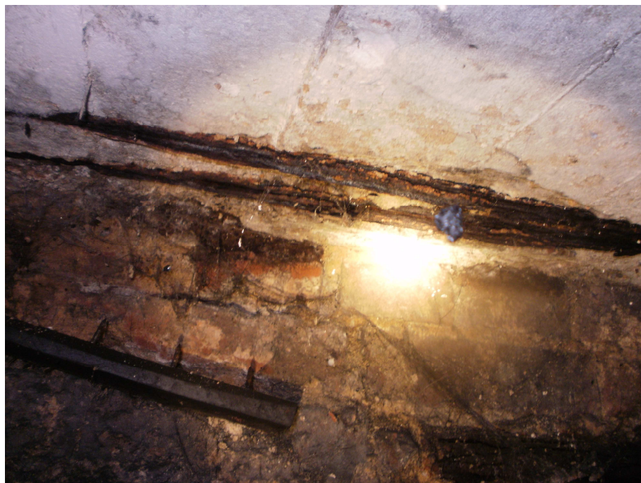
Zdjęcie nr 11 – pręty zbrojeniowe – strop nad pomieszczeniem nr 009
