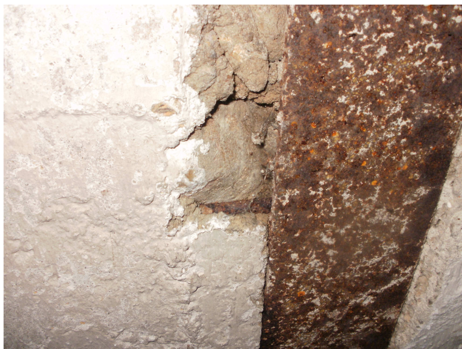
Zdjęcie nr 20 – belka nr 14, widoczny pręt zbrojeniowy
