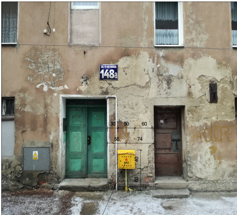
Istn. naścienna skrzynka gazowa o wym. 500x400x250mm z istn. kołnierzym GKG dn32
