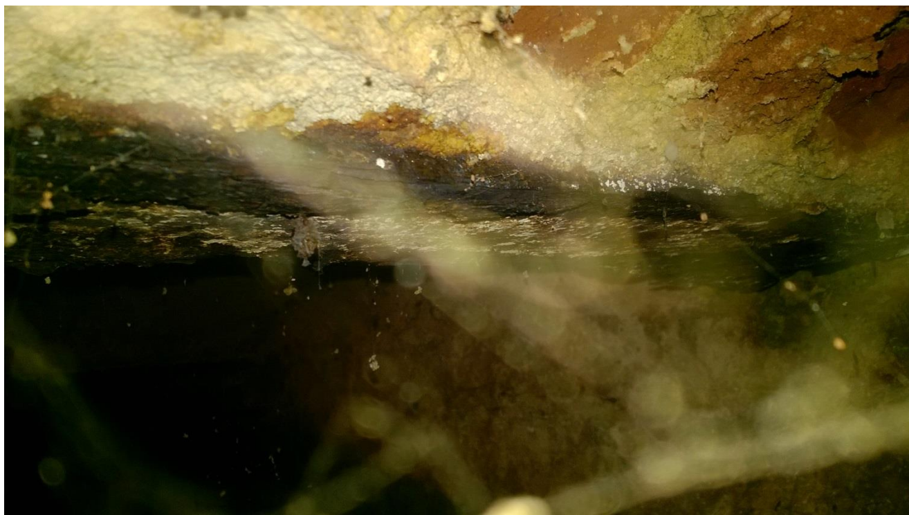
fot. nr 1 rozwarstwiająca korozja dolnej półki belki stropowej w pomieszczeniu piwnicznym nr 3
